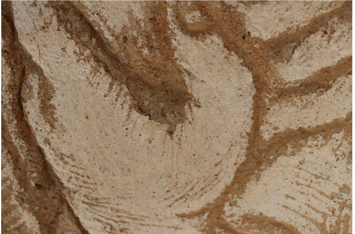
Obrázek 9 Detail defektu-prasklin v horní části restaurovaného úseku. Stav před restaurováním.
