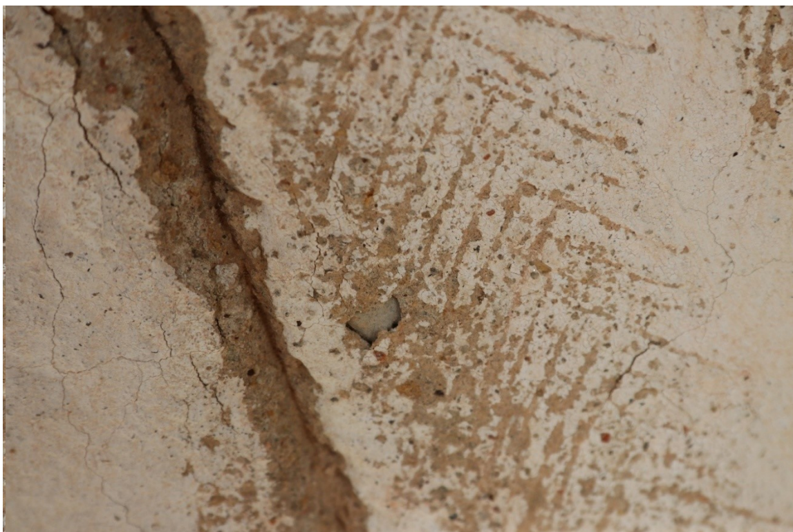
Obrázek 5 Detail ztráty koheze v spodní části restaurovaného úseku. Stav před restaurováním.
