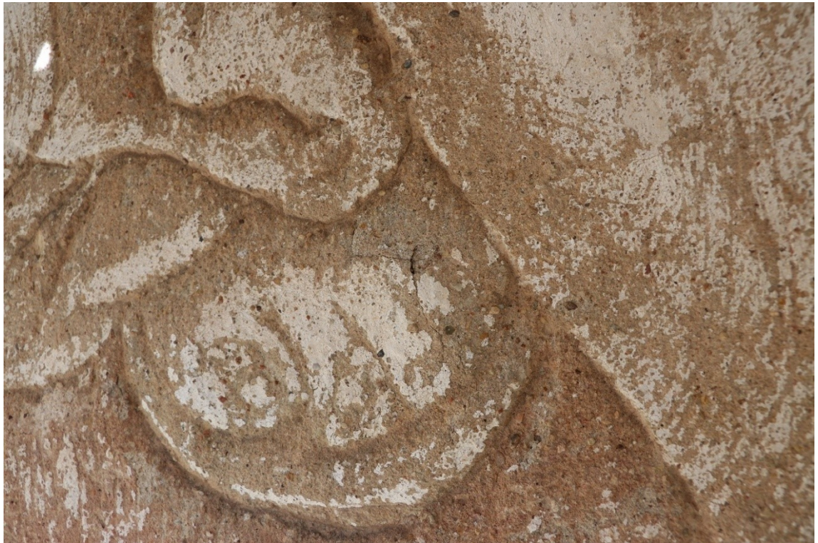
Obrázek 3 Detail poškození dolní části restaurovaného úseku. Stav před restaurováním.
