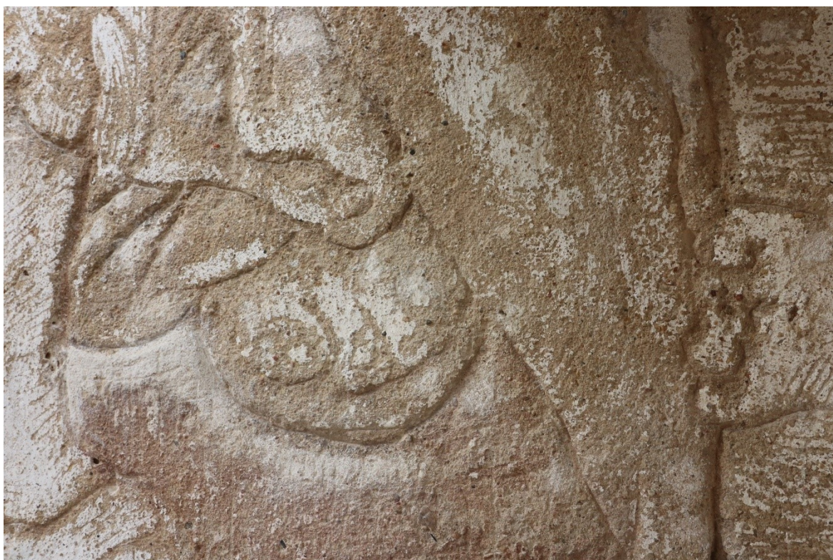
Obrázek 16 Detail spodní části restaurovaného úseku. Stav po vytmelení.
