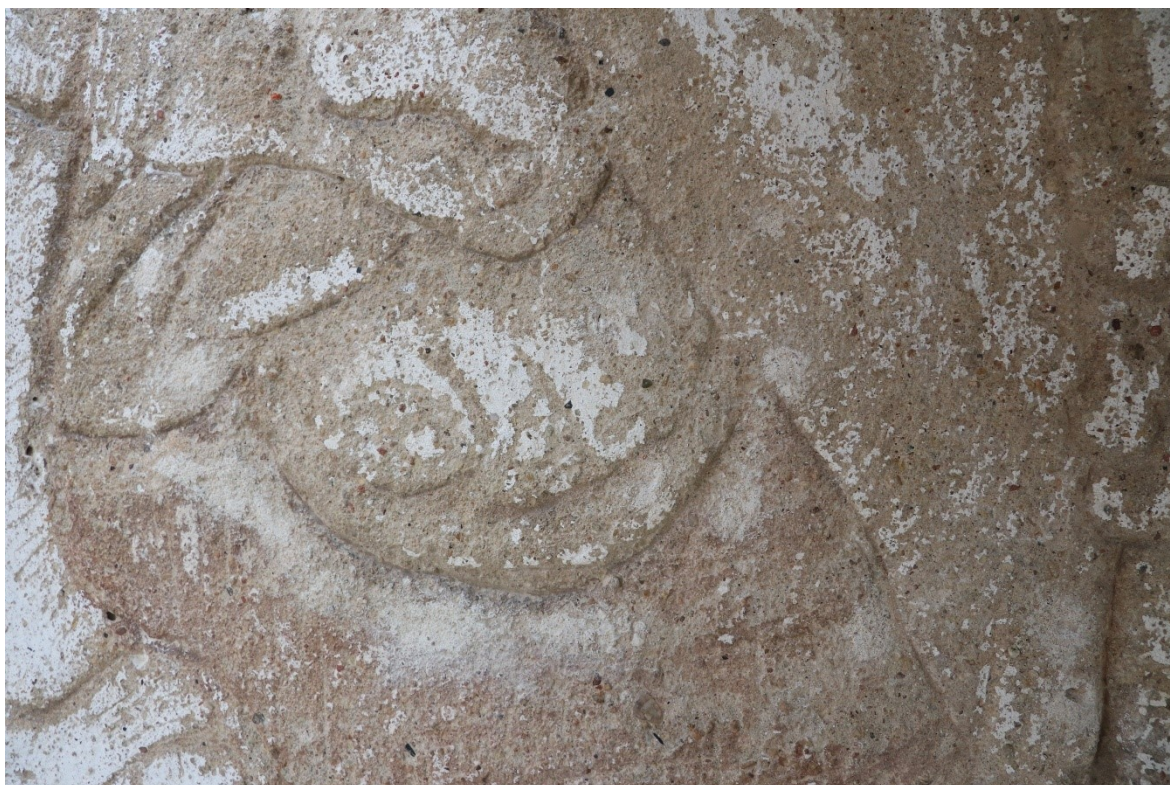
Obrázek 13 Detail spodní části úseku. Stav po očištění a konsolidaci.
