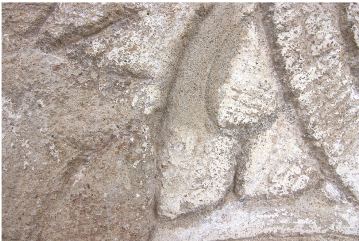
Obrázek 15 Detail spodní části restaurovaného úseku. Stav po vytmelení.
