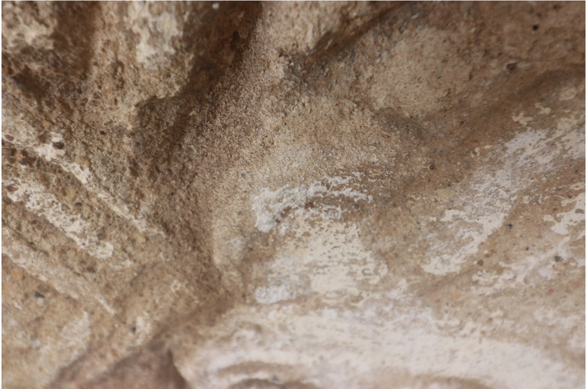
Obrázek 27 Detail spodní části restaurovaného úseku. stav po restaurování.
