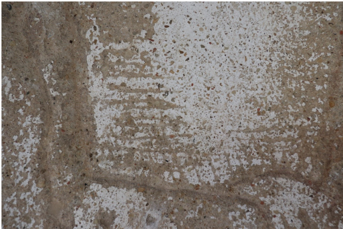
Obrázek 12 Detail spodní části úseku. Stav po očištění a konsolidaci.
