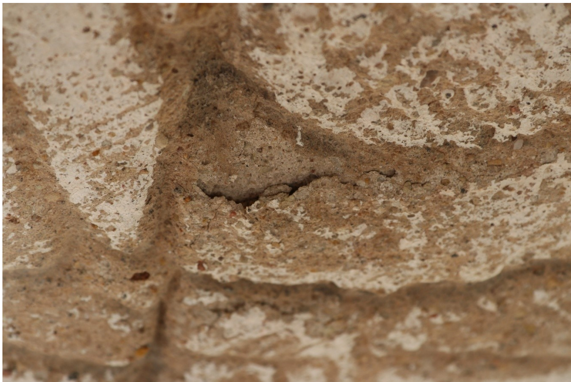
Obrázek 7 Detail ztráty koheze omítkových vrstev. Stav před restaurováním.
