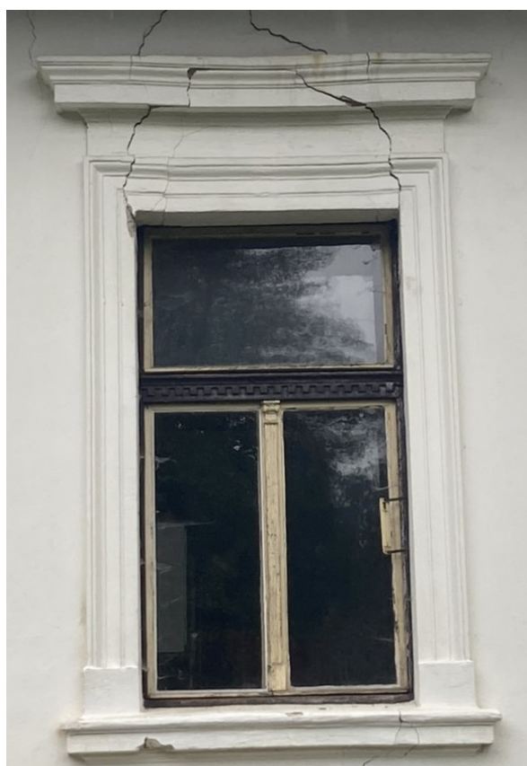
Obr. 104: Špaletové okno do tvaru T s šambránou, podokenní a nadokenní římsou, vyřezané „vlnkování“ dřeva pod horním křídlem
