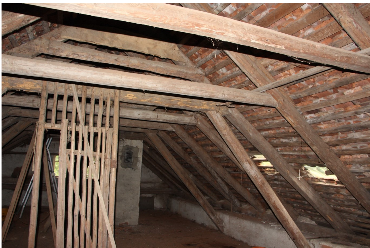
Obr. 125: Detail krovu s šikmou stolicí
