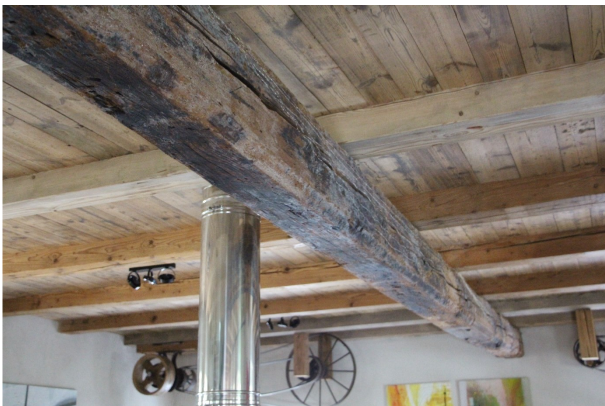
Obr. 45: Jedlový průvlak v prvním patře
