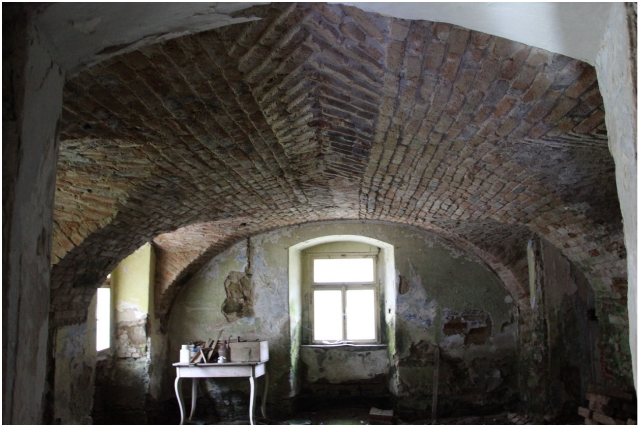
Obr. 110: Placková klenba s výsečemi v první místnosti přízemí obytné části
