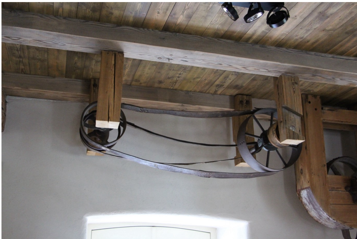
Obr. 44: Pohled na druhotně dekorativně instalovanou transmisí v prvním patře
