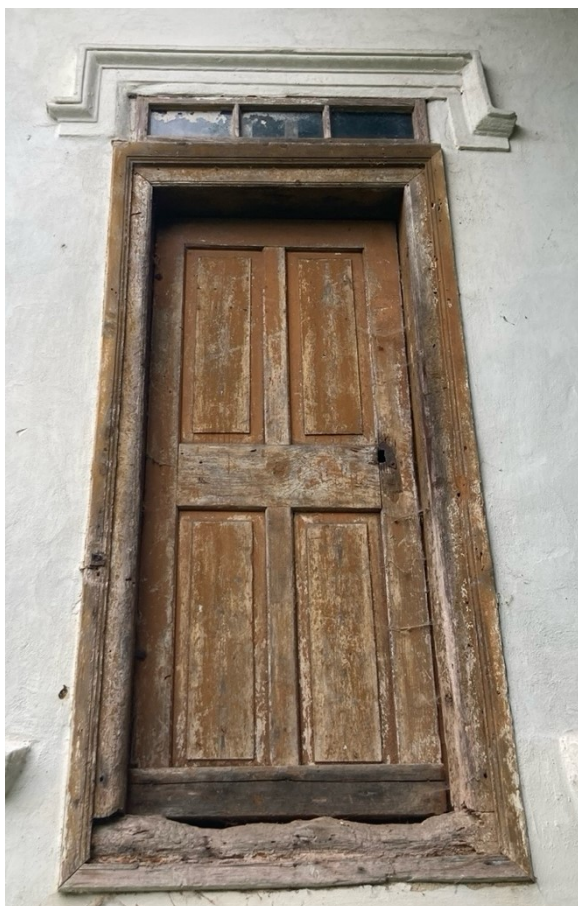
Obr. 98 a 99: Lícová strana dveří do prvního patra mlýnice ze dvora; (vpravo) Lícová strana dveří v prvním patře mlýnice, neprůchozí – zazděné z rubové strany
