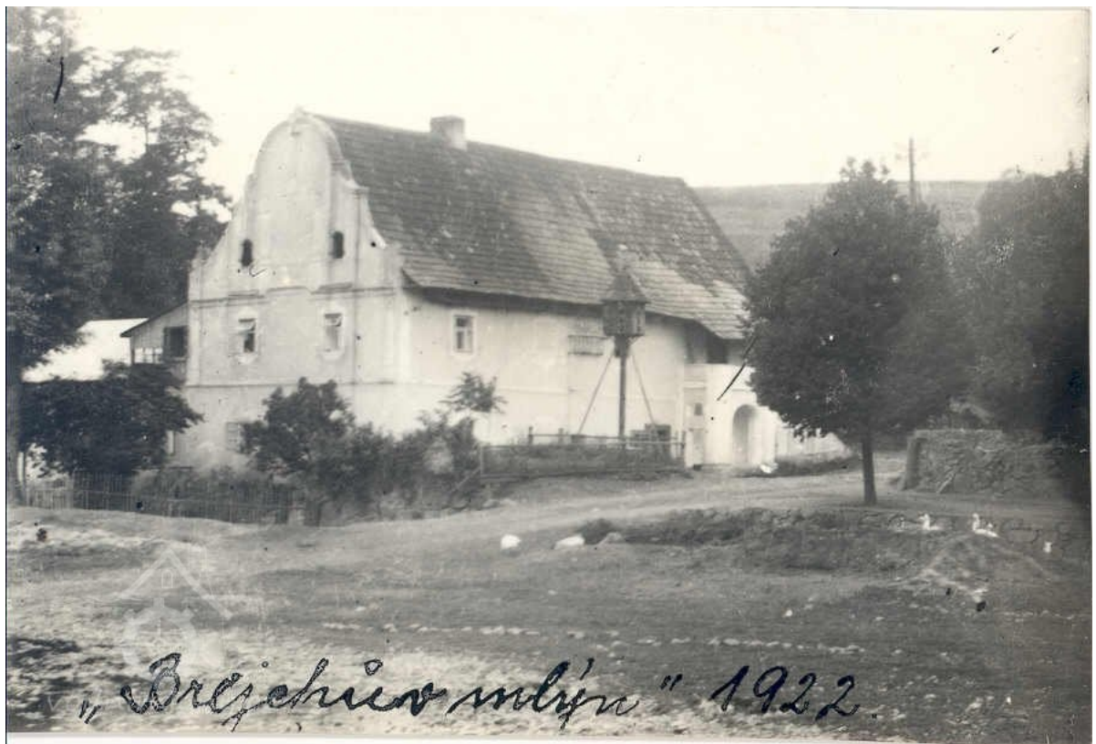
Obr. 58: Historická fotografie z roku 1922 před přestavbou
