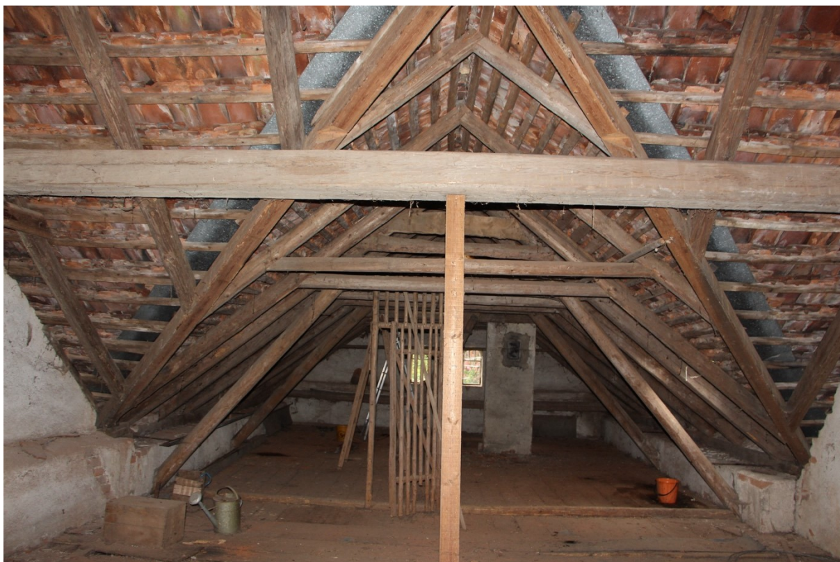
Obr. 124: Hambalkový krov pod nižším hřebenem střechy nad obytnou částí
