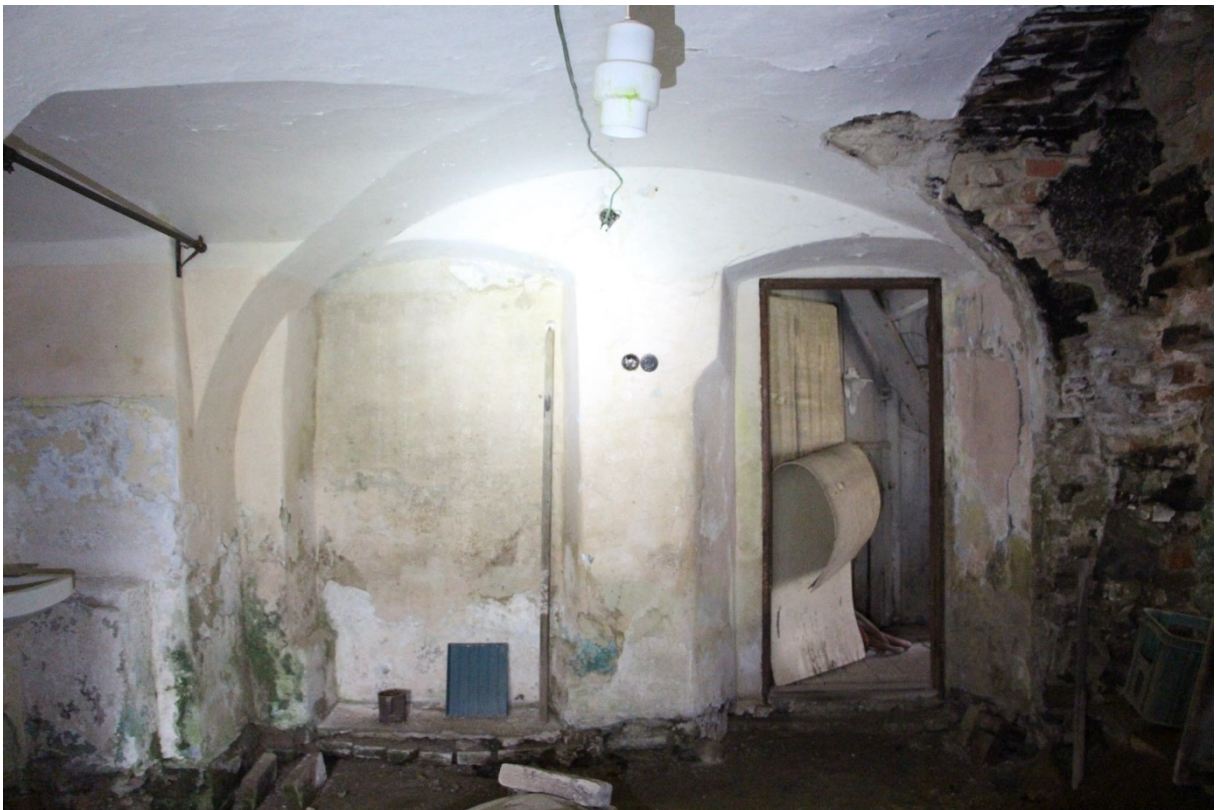
Obr. 111: Omítnutá placková klenba s výsečemi – vedlejší místnost
