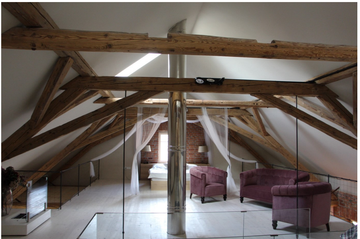
Obr. 50: Pohled na severní část krovu
