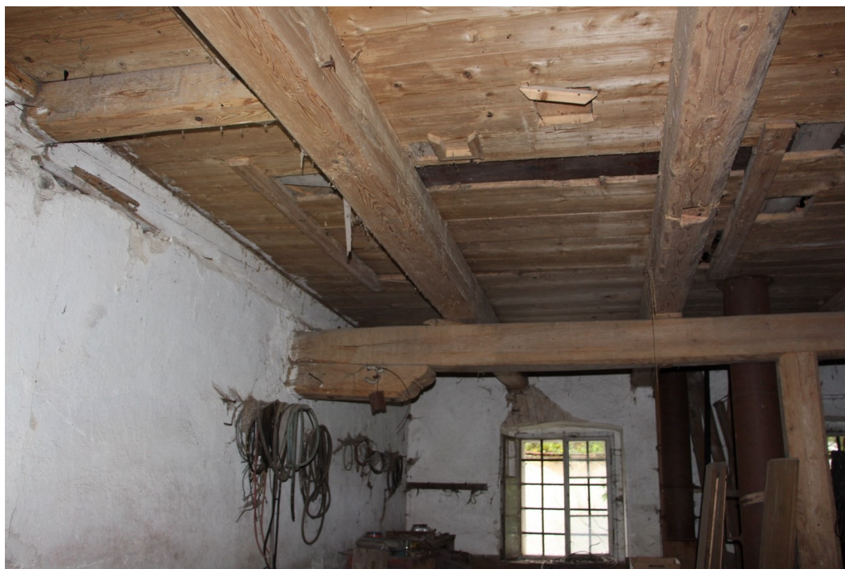
Obr. 118: Strop v prvním patře s průvlakem
