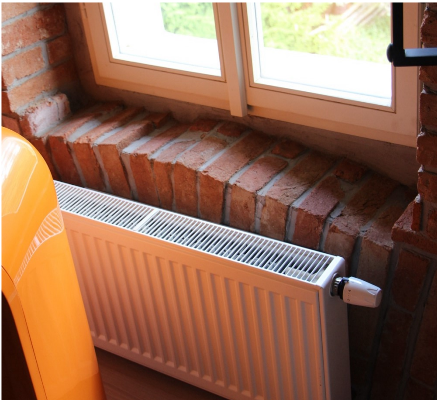
Obr. 52: Klenutý cihelný pas pod oknem
