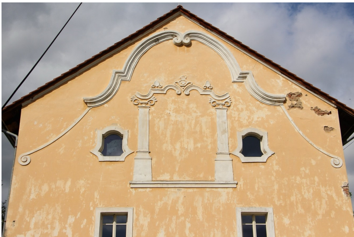
Obr. 36: Detail štítu jižního průčelí
