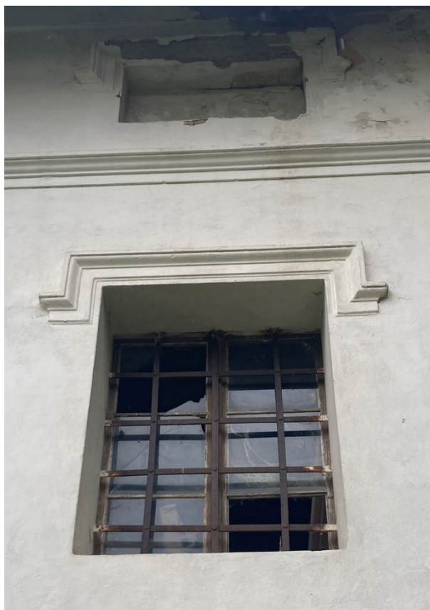
Obr. 103: Okno na severním průčelí s mříží
