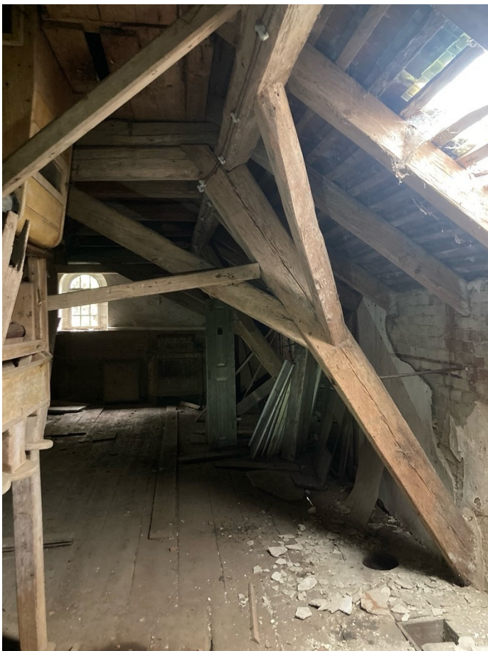
Obr. 128: Ležatá stolička se vzpěrou a pásy držícími vaznici
