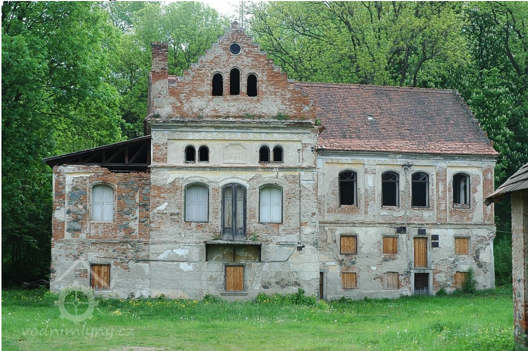
Obr. 65: Celkový pohled na budovu ze západu
