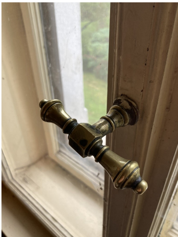
Obr. 107 a 108: (vlevo) Detail mosazné kliky okna; (vpravo) detail kuželového závěsu s kuličkou
