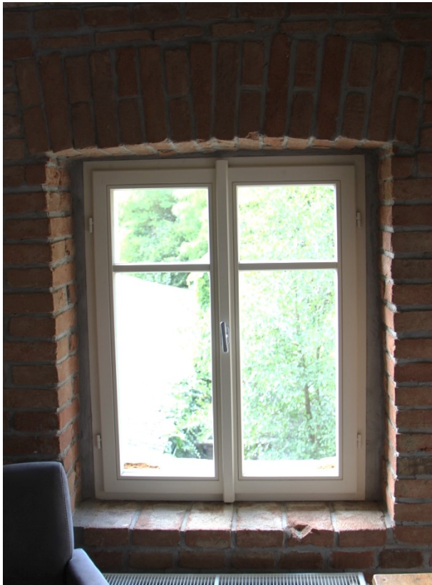
Obr. 53 a 54: (vlevo) novodobé dvoukřídle, čtyřtabulkové okno ve druhém patře; (vpravo) v prvním patře s parapetem
