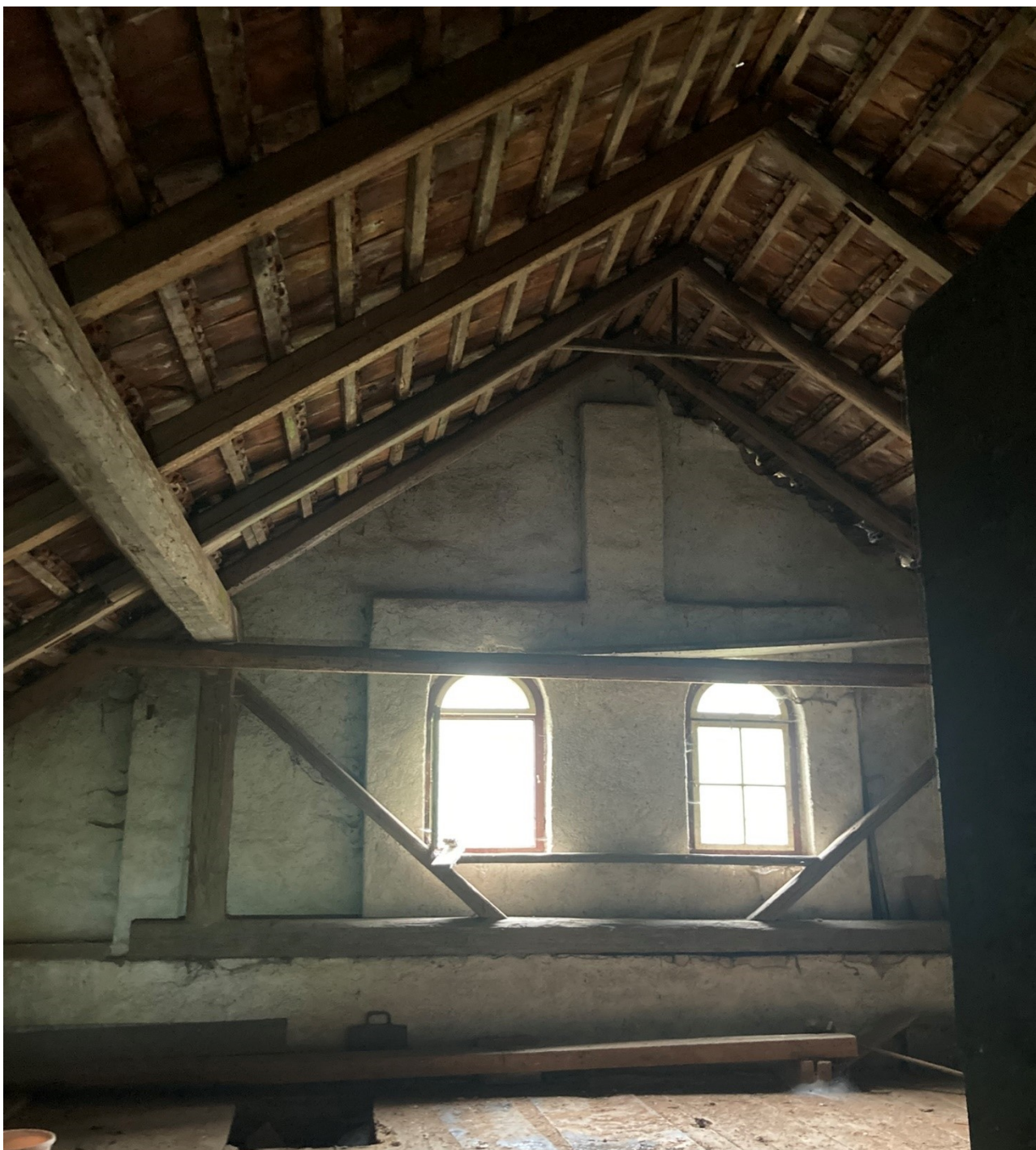
Obr. 123: Vaznicový krov nad obytnou částí pokračující do mlýnice
