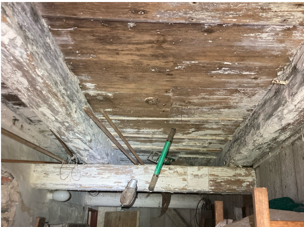
Obr. 117: Trámový strop se záklopem v chodbě
