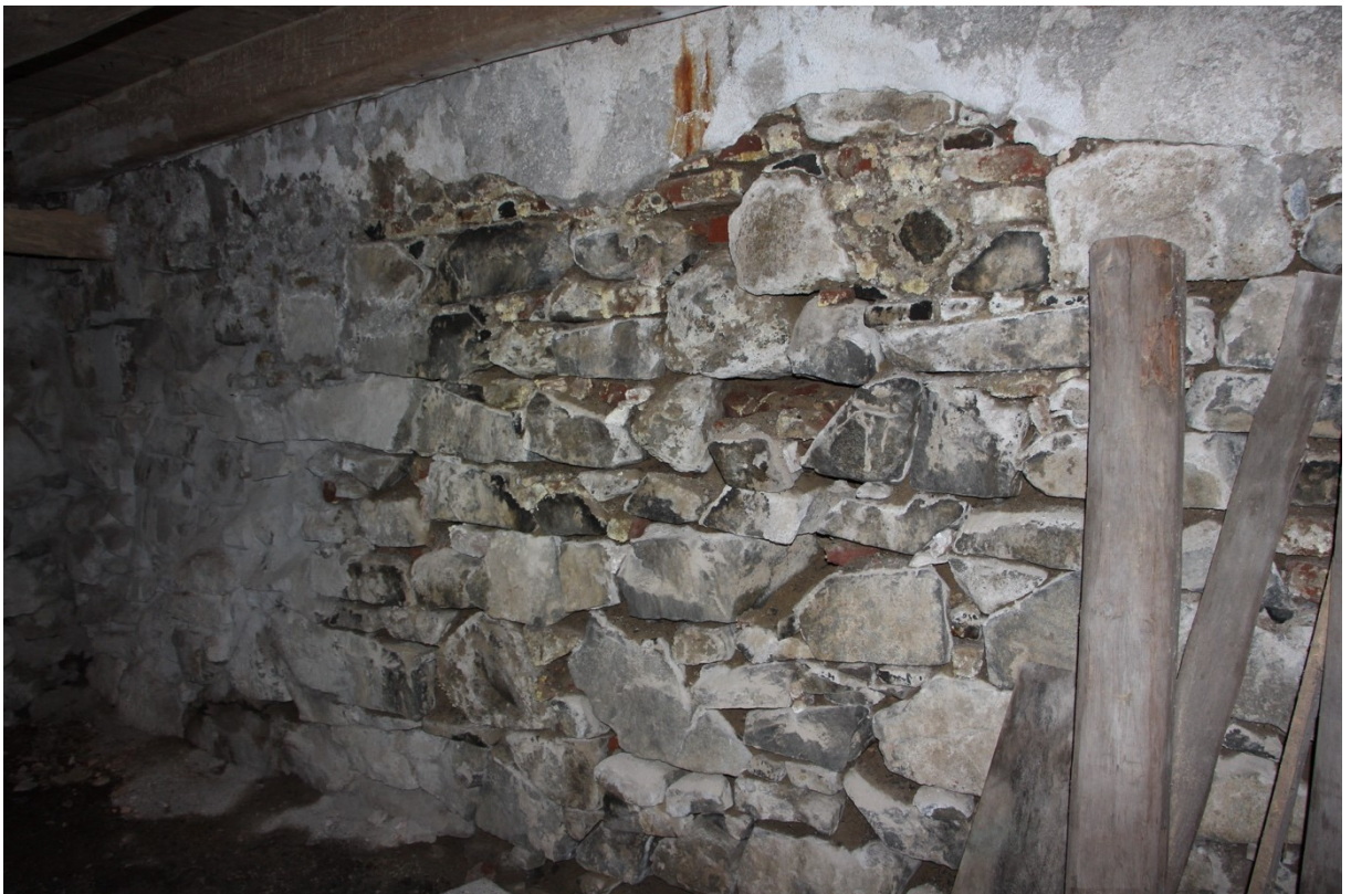
Obr. 114: Detail odkrytého zdiva v mlýnici
