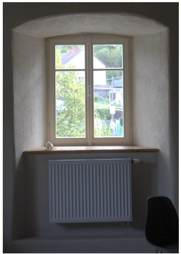
Obr. 53 a 54: (vlevo) novodobé dvoukřídle, čtyřtabulkové okno ve druhém patře; (vpravo) v prvním patře s parapetem
