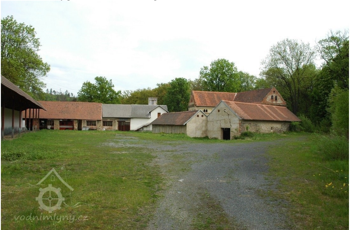
Obr. 66: Pohled na areál s hospodářskými budovami
