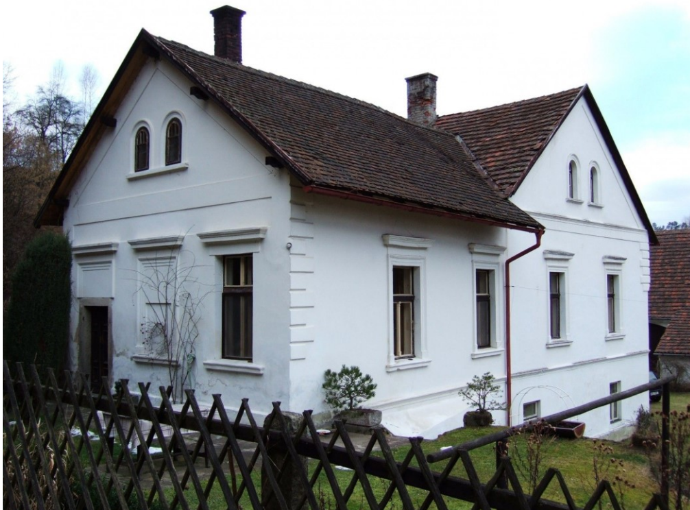
Obr. 84: Pohled na jihovýchodní část domu – obytná část
