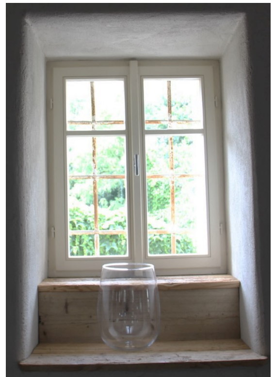
Obr. 55 a 56: (vlevo) Novodobé kasulové okno ve druhém patře; (vpravo) dvoukřídle, čtyřtabulkové okno s mříží a dvojitým parapetem v prvním patře
