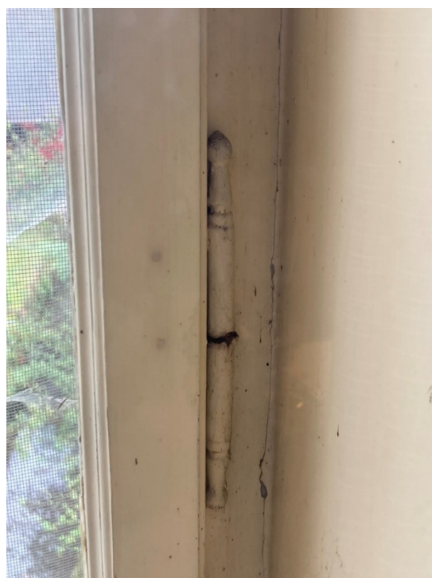
Obr. 107 a 108: (vlevo) Detail mosazné kliky okna; (vpravo) detail kuželového závěsu s kuličkou
