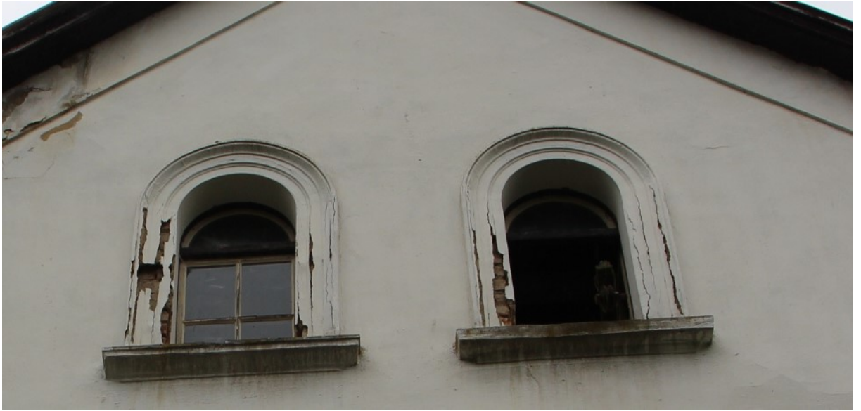
Obr. 105: Dvojice půlkruhově zakončených okének na východním průčelí
