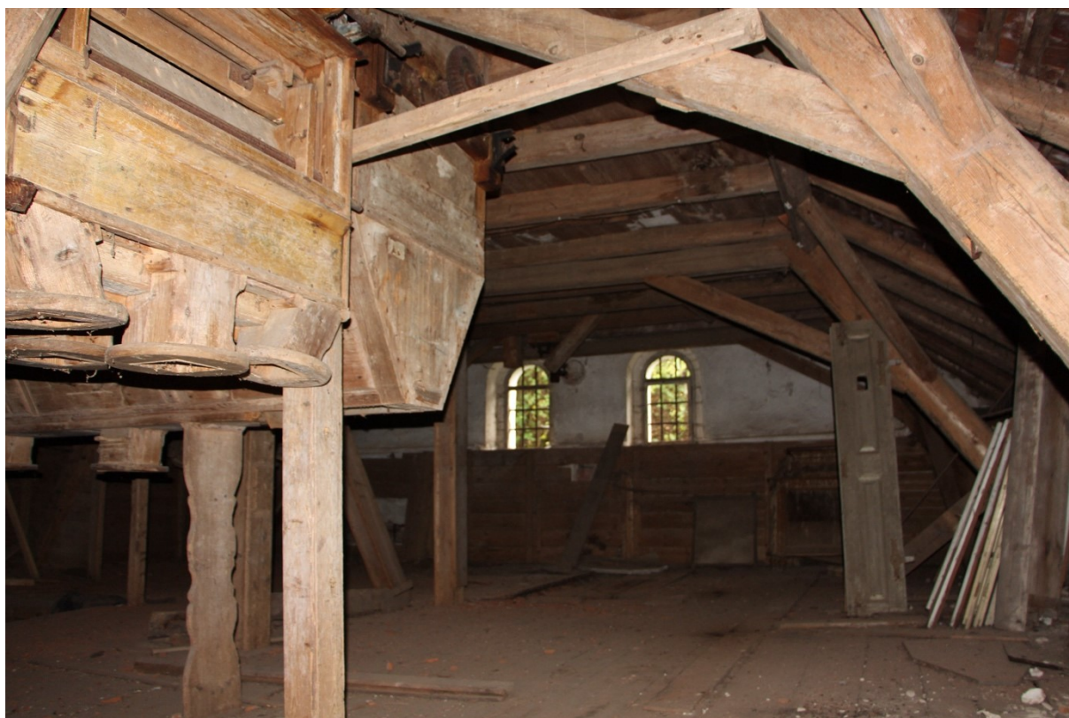
Obr. 127: Konstrukce hambalkového krovu mlýnice
