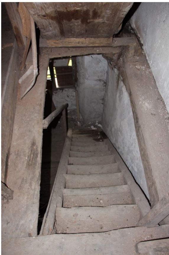
Obr. 119 a 120: (vlevo) Žebříkové schody s trémovými schodnicemi a deskovými stupni pokrytými lištovaným bedněním; (vpravo) dva hranolové vysévače v druhém patře
