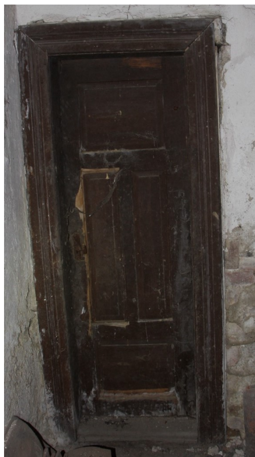
Obr. 98 a 99: Lícová strana dveří do prvního patra mlýnice ze dvora; (vpravo) Lícová strana dveří v prvním patře mlýnice, neprůchozí – zazděné z rubové strany
