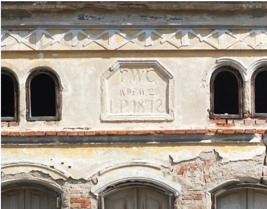
Obr. 71: Detail rámování s datací na západním průčelí
