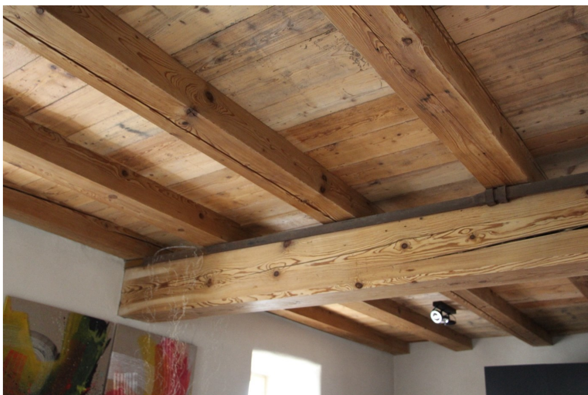
Obr. 48: Železné táhlo podél průvlaku
