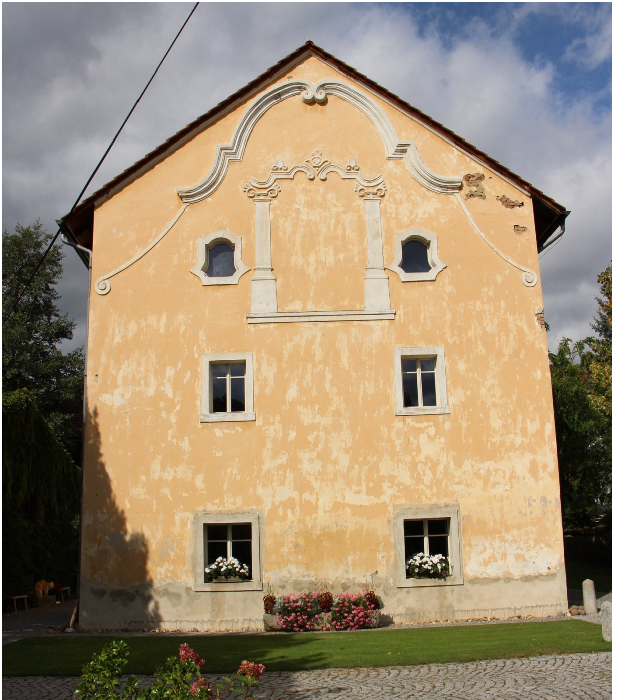
Obr. 35: Jižní průčelí s dekorativním štítem
