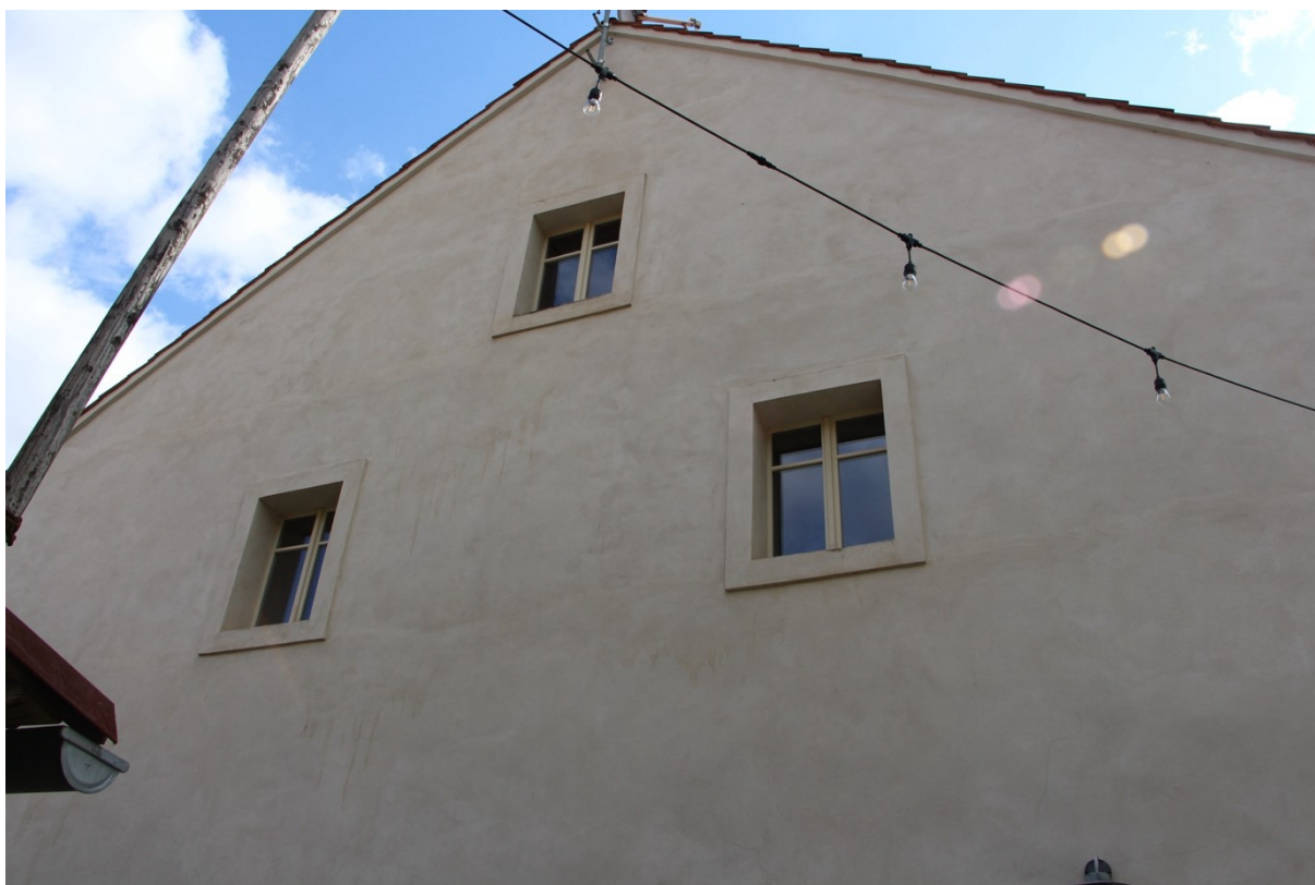
Obr. 39: Nově omítnuté severní průčelí – pohled na první a druhé patro
