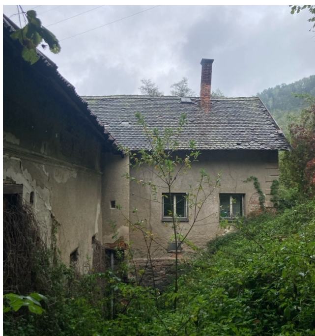
Obr. 92: Viditelný záchodový přístavek
