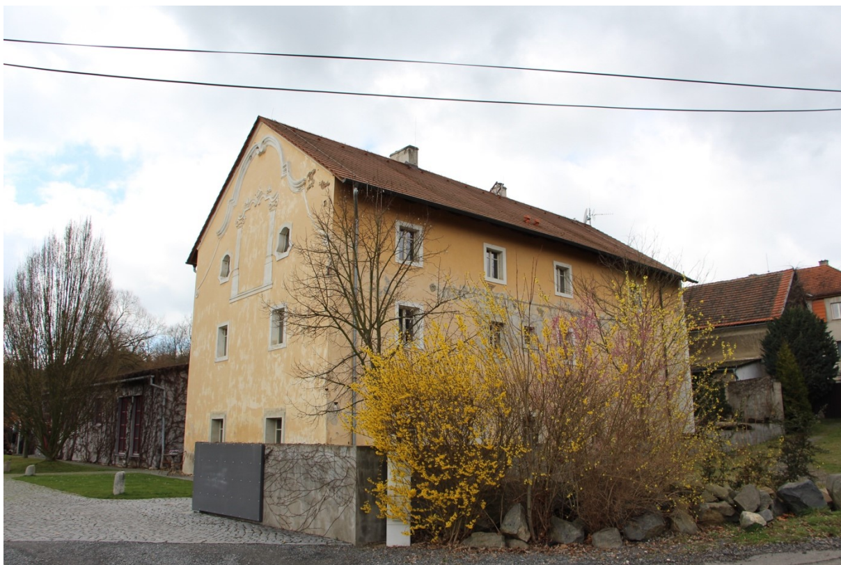
Obr. 37: Celkový pohled na budovu z jihovýchodu
