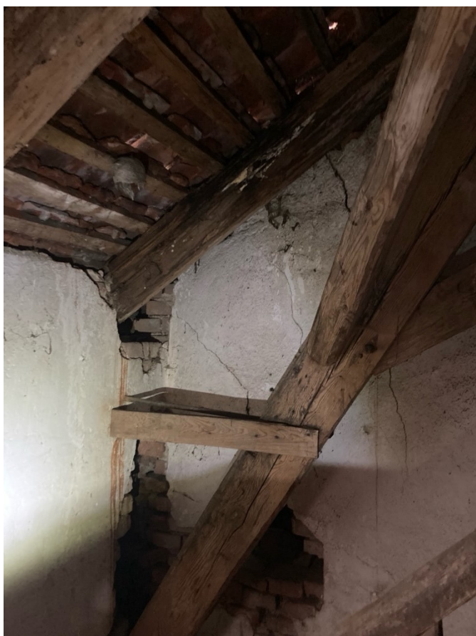
Obr. 129: Detail sloupku s podporou táhla a prkna
