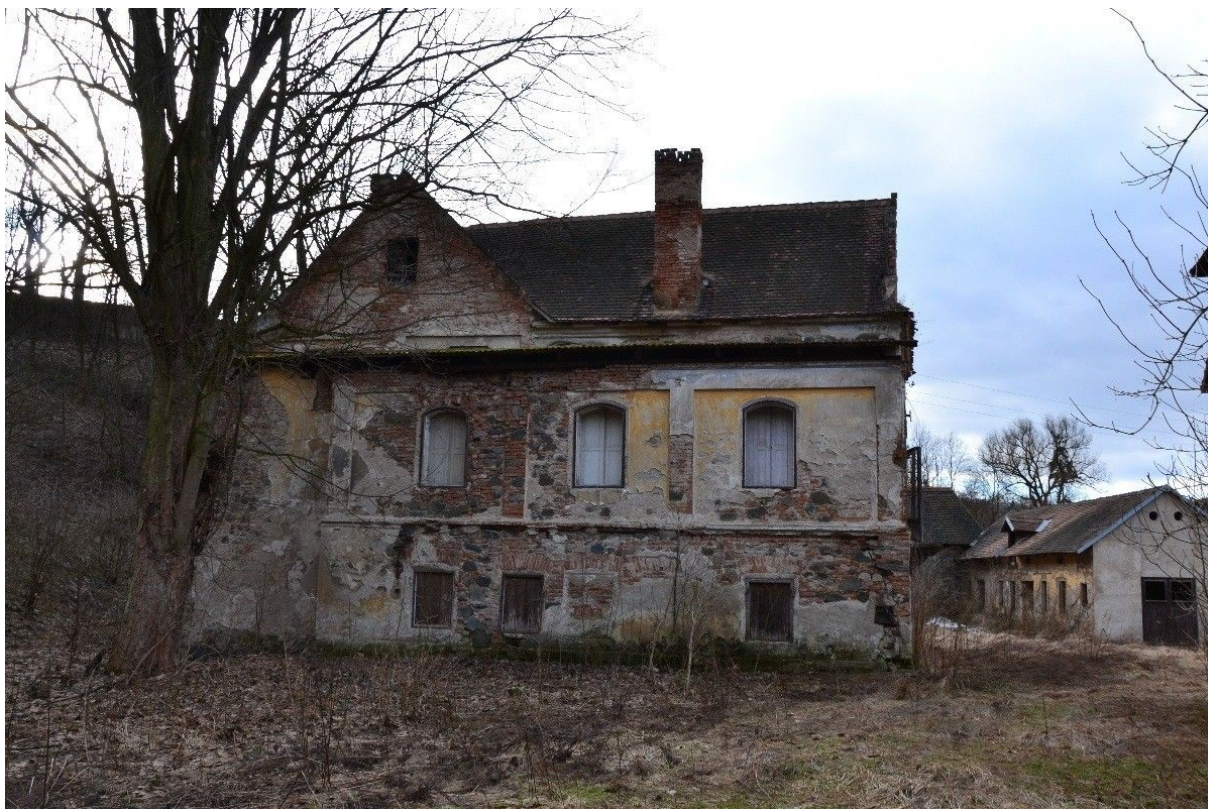
Obr. 69: Severní průčelí s přístavbou
