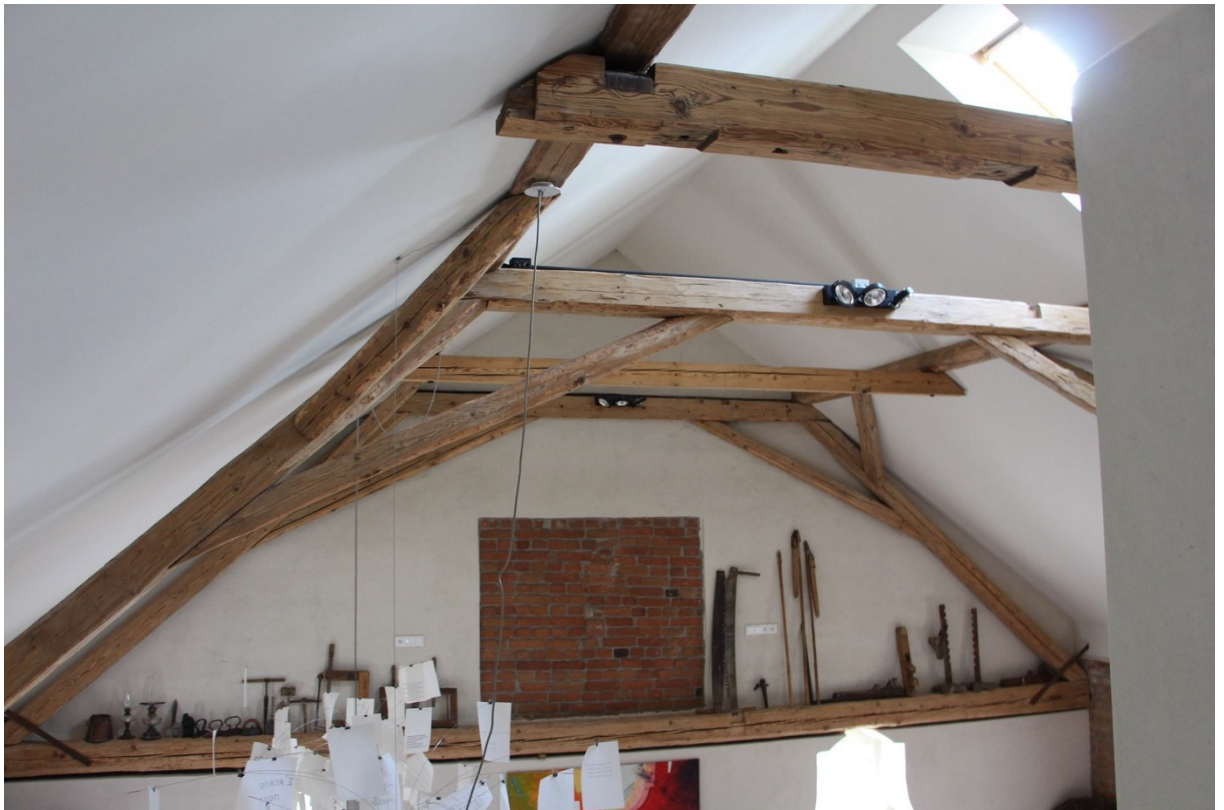
Obr. 49: Pohled na jižní stranu vaznicové konstrukce krovu
