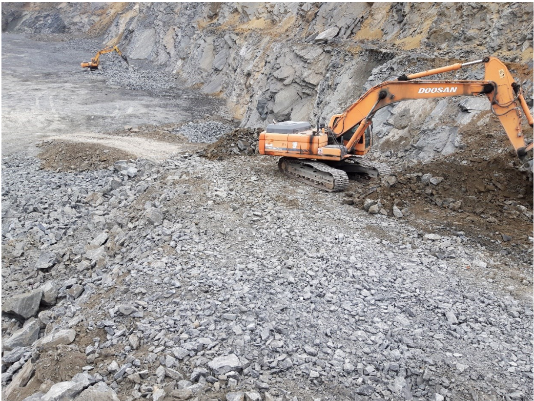
Obrázek č. 47 – Budování násypu 3
