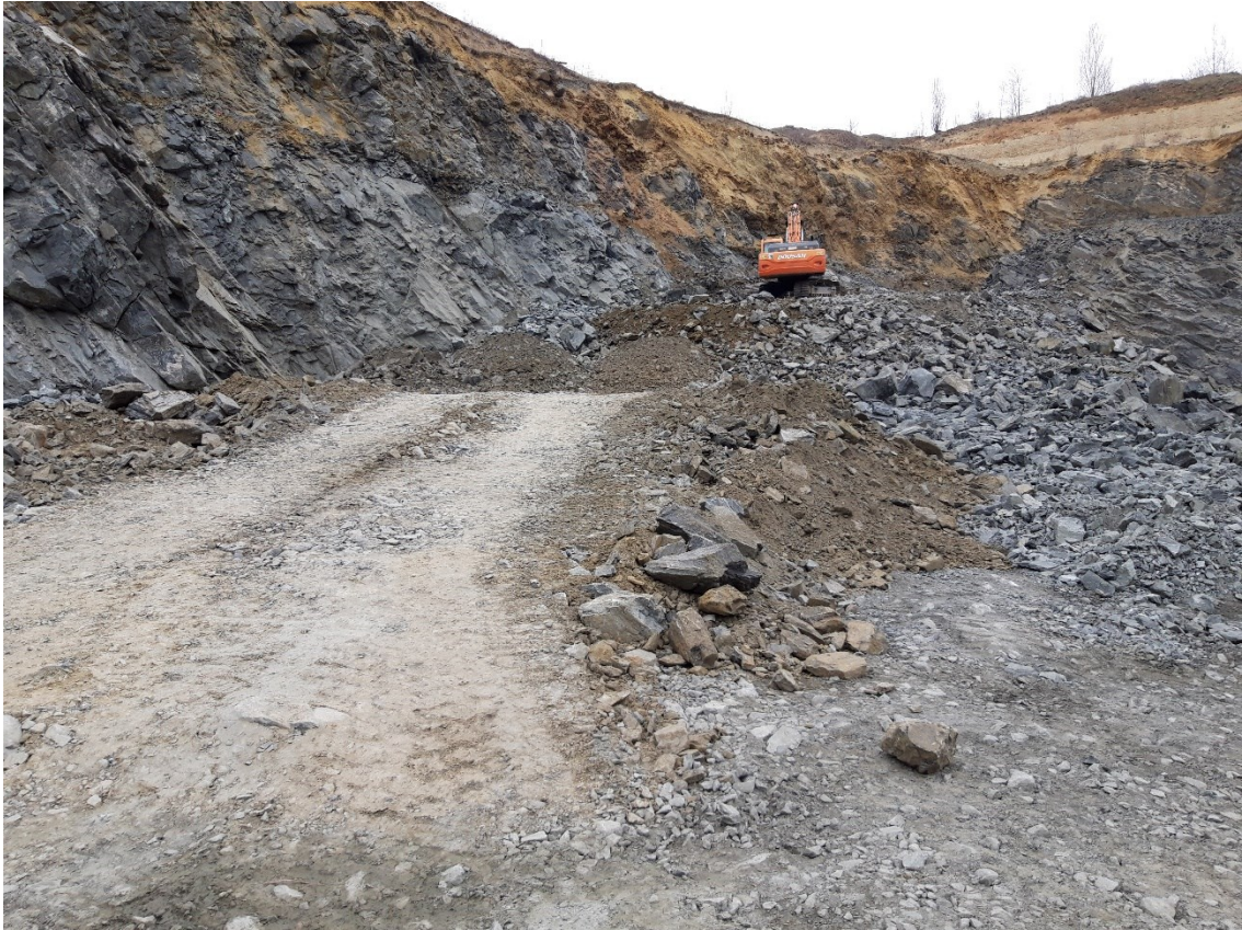
Obrázek č. 46 – Budování násypu 2
