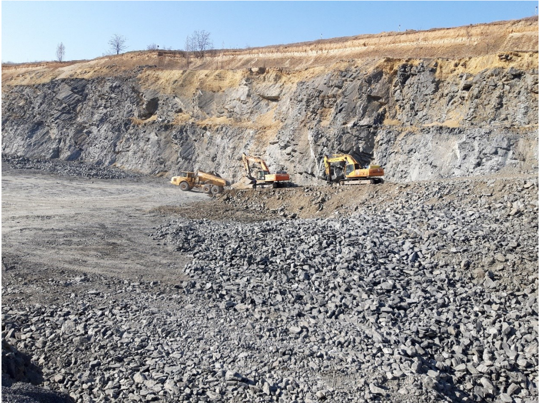
Obrázek č. 48 – Budování násypu 4
