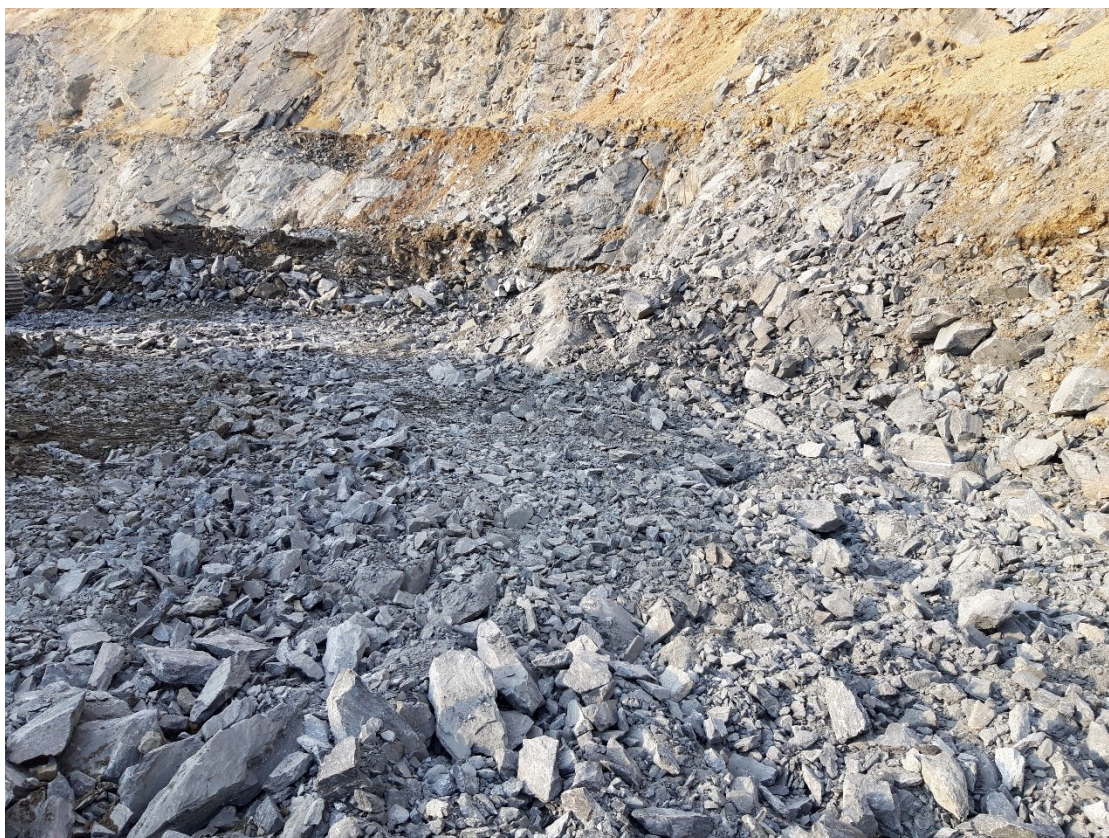
Obrázek č. 42 – Počátek budování trasy
