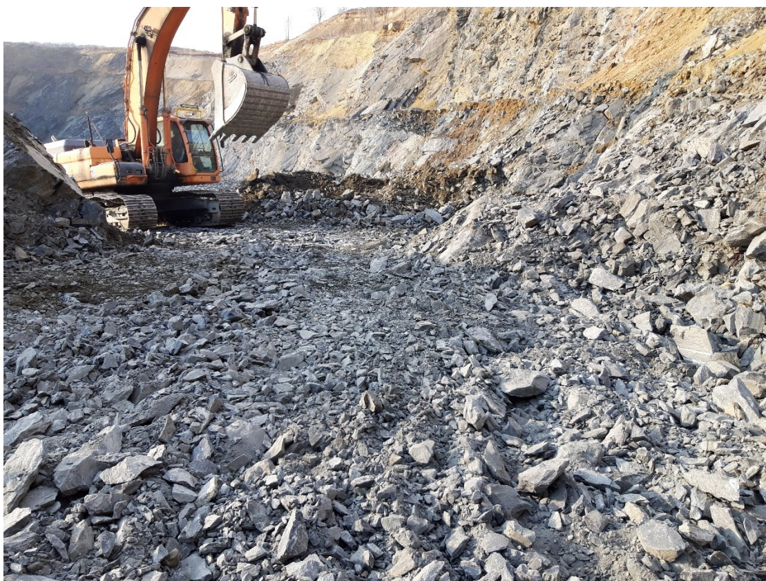
Obrázek č. 43 – Počátek budování trasy 2
