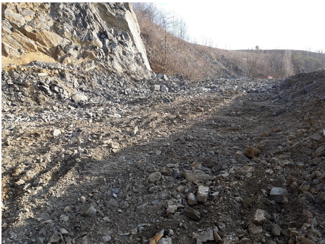
Obrázek č 44 - Počátek budování trasy 3
