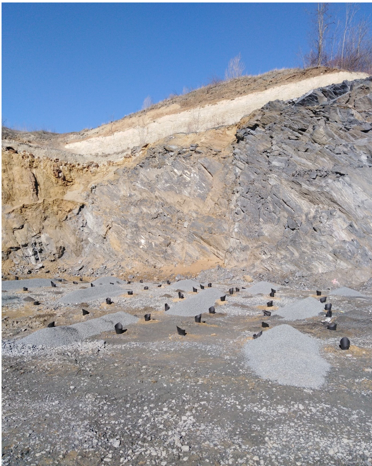
Obrázek č. 41 – Rozmístění vrtů v počátku trasy
