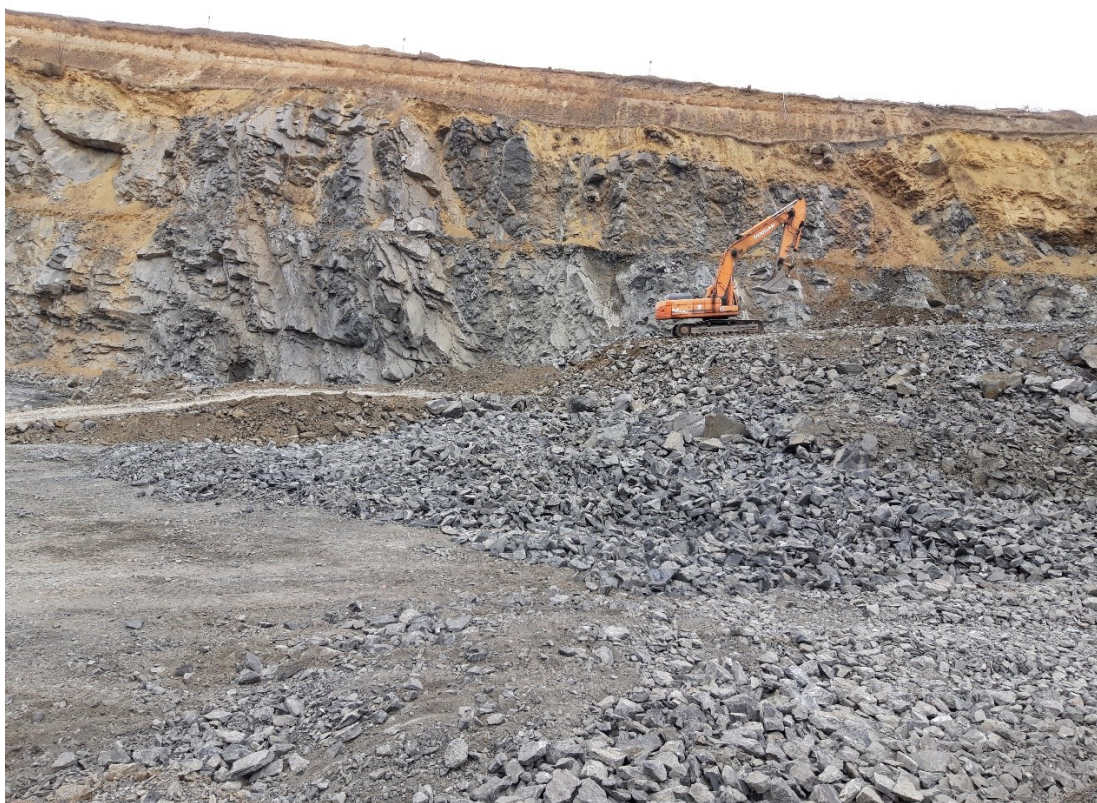
Obrázek č. 45 – Budování násypu
