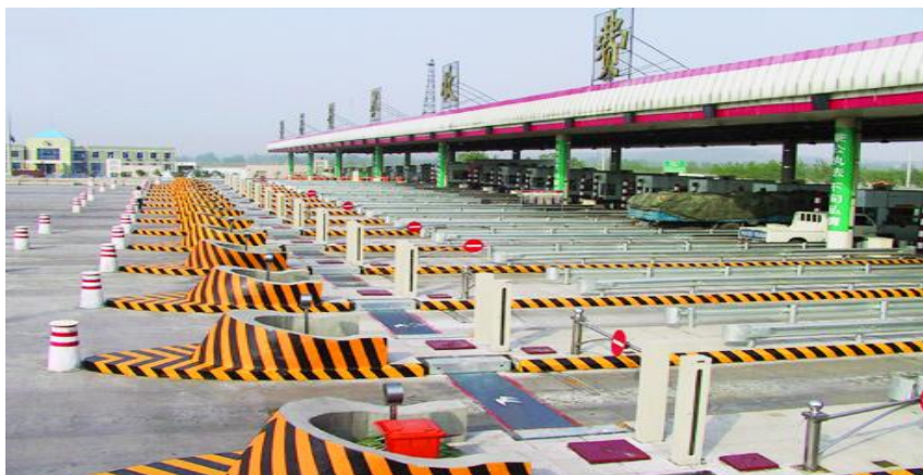
Obrázek č. 2 Mýtné kabiny
