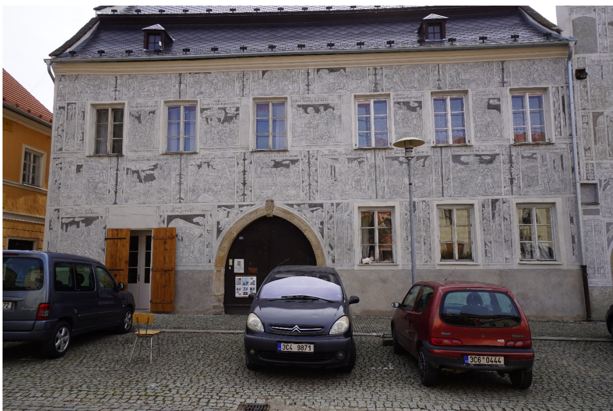
Obrázek 11 Celkový pohled na dům čp. 538 po restaurátorském zásahu v roce 2023. Foto: Jana Waisserová.
