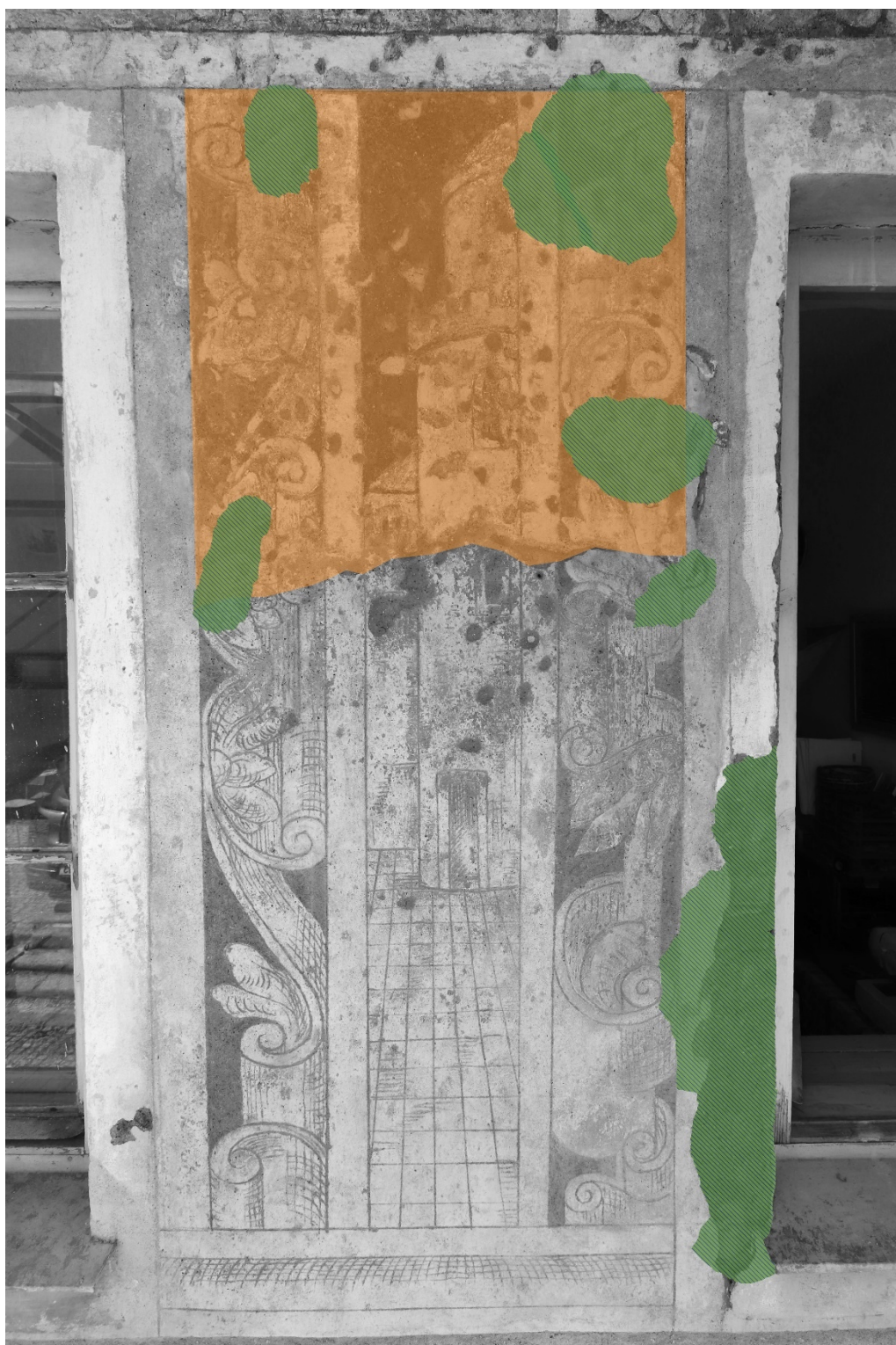
Obrázek 71 Grafický zakres poškození, iluzivní architektura.
