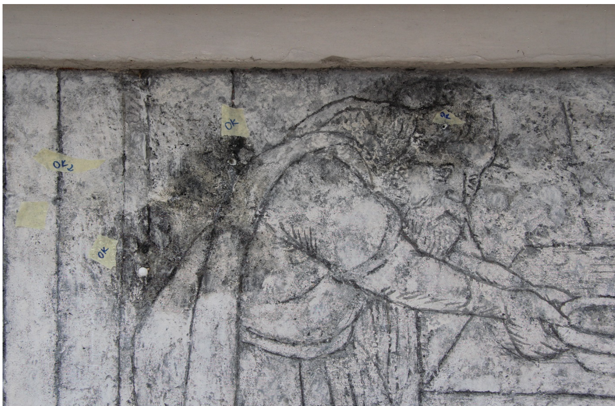
Obrázek 25 Průběh hloubkové injektáže na výjevu Andělé u Abraháma.
