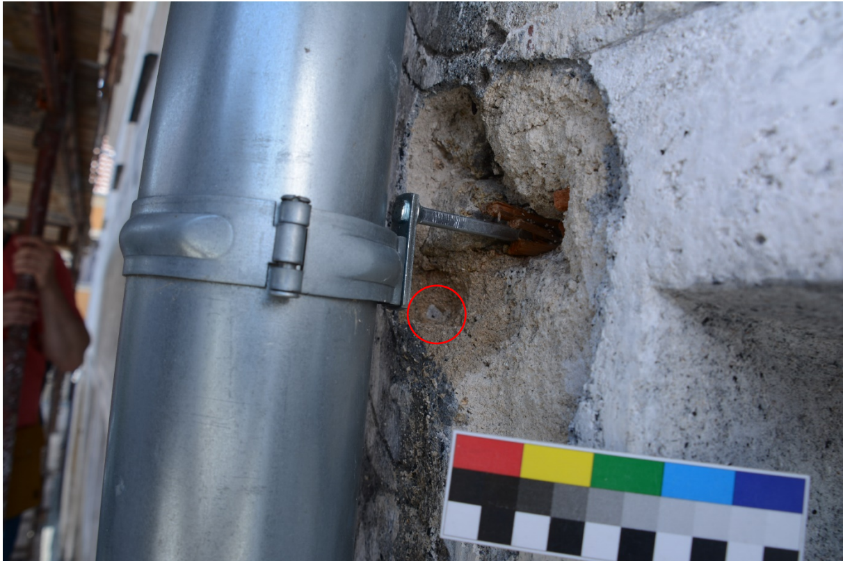
Umístění vzorku SPIV 3 v jádrové omítce (DSC_6105)
