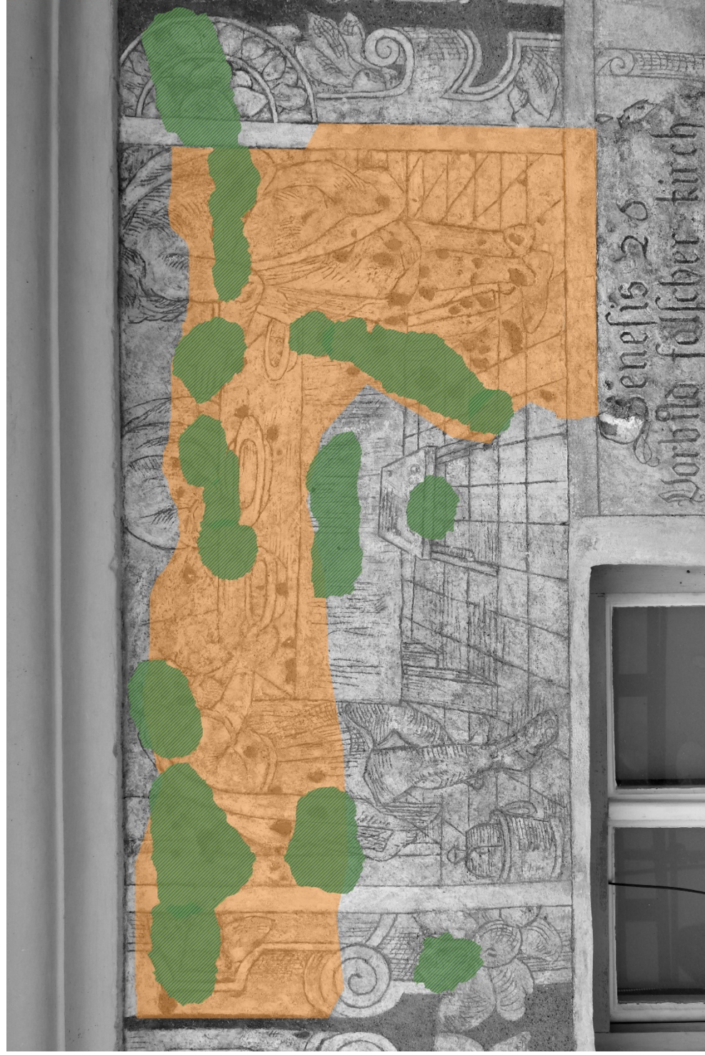
Obrázek 68 Grafický zakres poškození, výjev Andělé u Abraháma.
