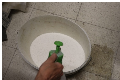
Obr. 2 Kropení hydrátu.
