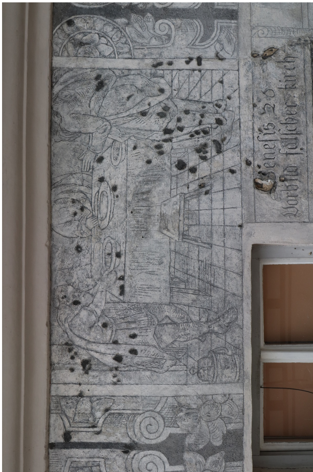
Obrázek 39 Sekvence výjevu č. 18 – "Andělé u Abraháma". Stav díla po odstranění nevyhovujících druhotných tmelů a konsolidaci otevřených defektů.
