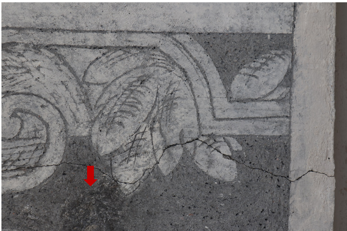
Obrázek 18 Detail praskliny v levém pásovém dekoru. Patrný je světle šedý doplněk a část originální omítky, která se vyznačuje tmavším odstínem. Originál nese stopy starších retuší. Šípkou je vyznačen fragment originální omítky. Stav díla před restaurováním.
