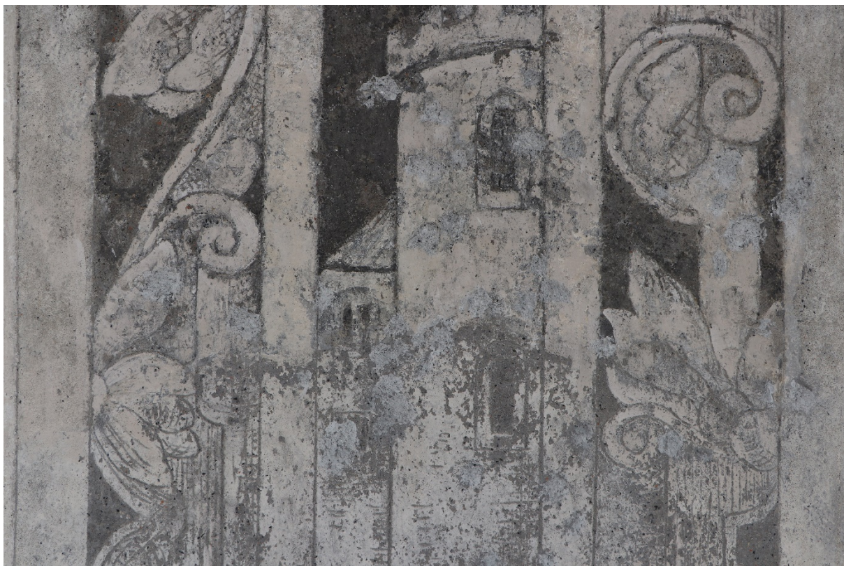
Obrázek 21 Detail horní části iluzivní architektury. V horní části detailu jsou zachyceny fragmenty originální omítky s druhotným pekováním. Dolní část je druhotným doplňkem. V celé ploše jsou patrné stopy poškození povrchu,
