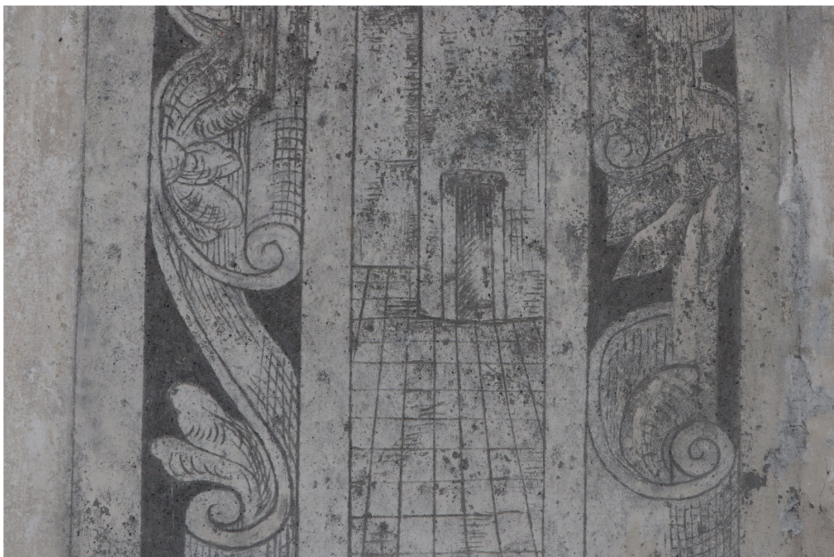
Obrázek 22 Detail spodní části iluzivní architektury s povrchovým poškozením. V pravé části je patrné provizorní zajištění otevřených defektů způsobených krupobitím. Stav díla před restaurováním.
