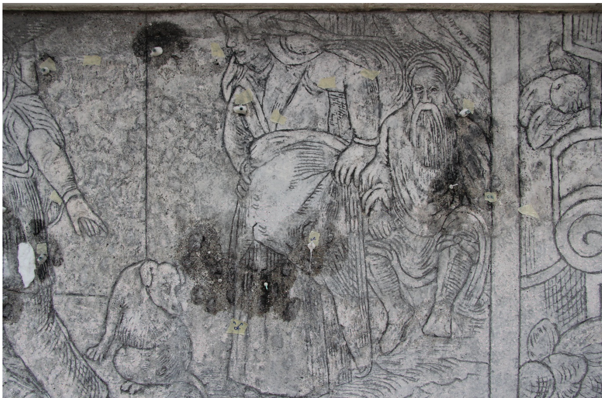
Obrázek 24 Průběh hloubkové injektáže na výjevu Sára vyhání Hagar.
