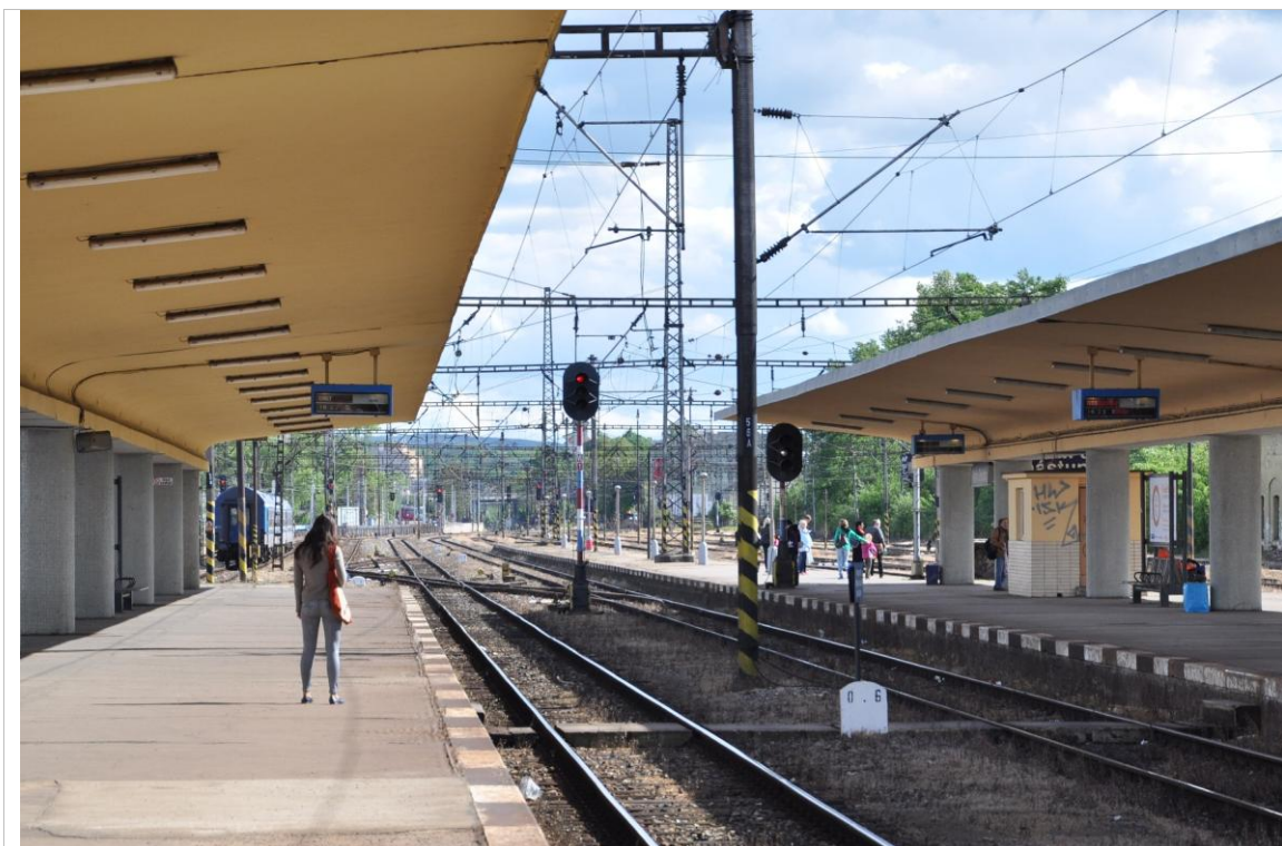
Obrázek 22 Praha-Smíchov, pohled na vložená návěstidla ve směru na Prahu-Radotín z obvyklého místa zastavení, 2. nástupiště
