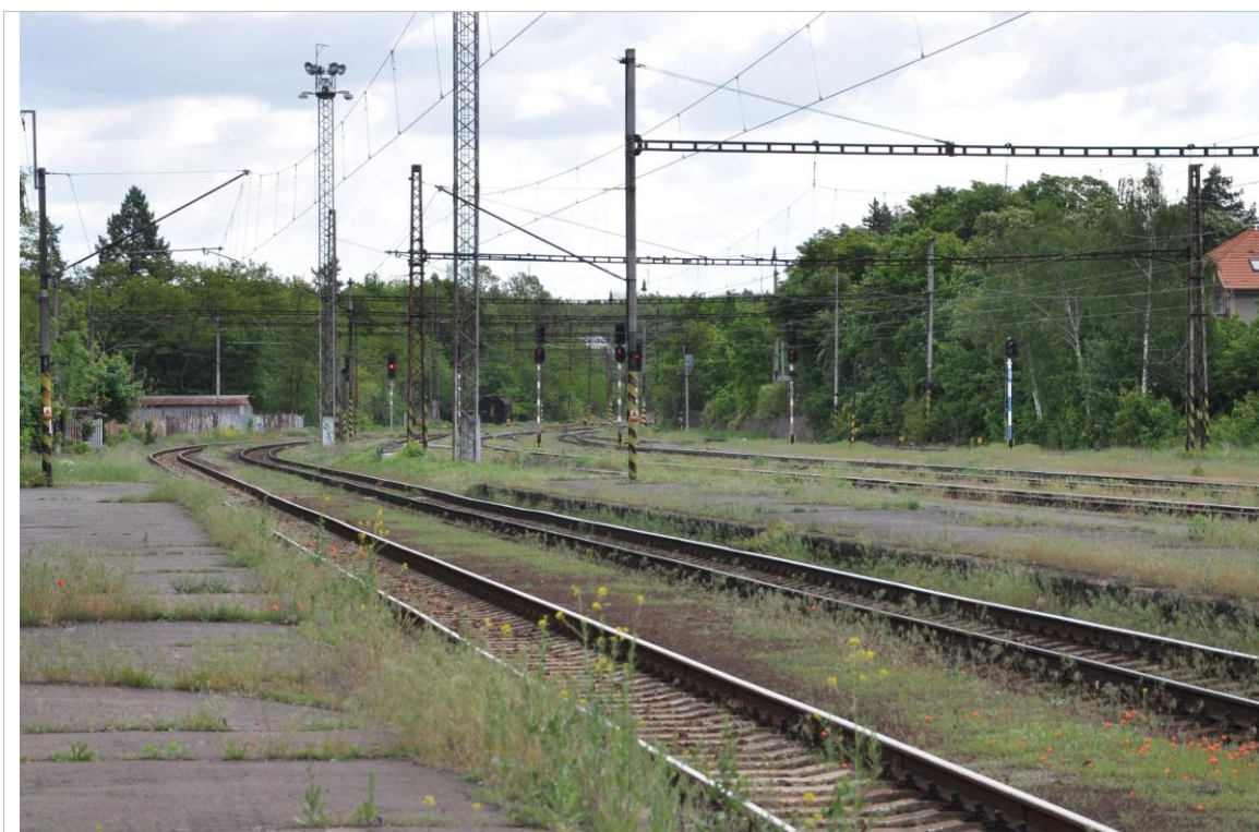
Obrázek 19 Praha-Krč, pohled na odjezdová návěstidla ve směru na Prahu-Vršovice os.n. z obvyklého místa zastavení, 1. nástupiště
