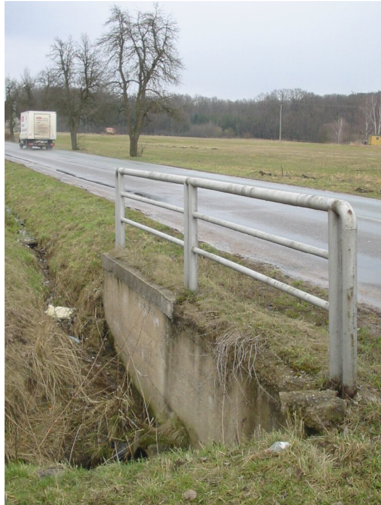
14) Pohled na stav odvodnění - levý příkop a trubní propustek DN800 (staničení km 0,910-0,950)
