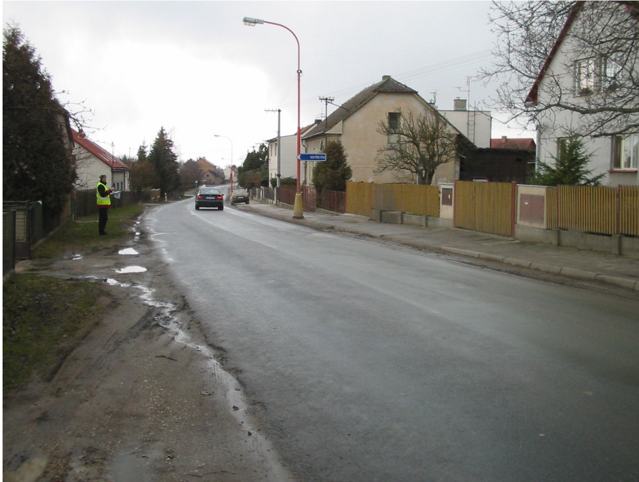
4) Celkový pohled (staničení km 0,200 – 0,350)
