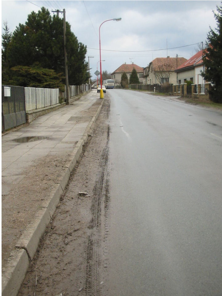
3) Pohled na špatné odvodnění okrajů vozovky (staničení km 0,200 – 0,350)
