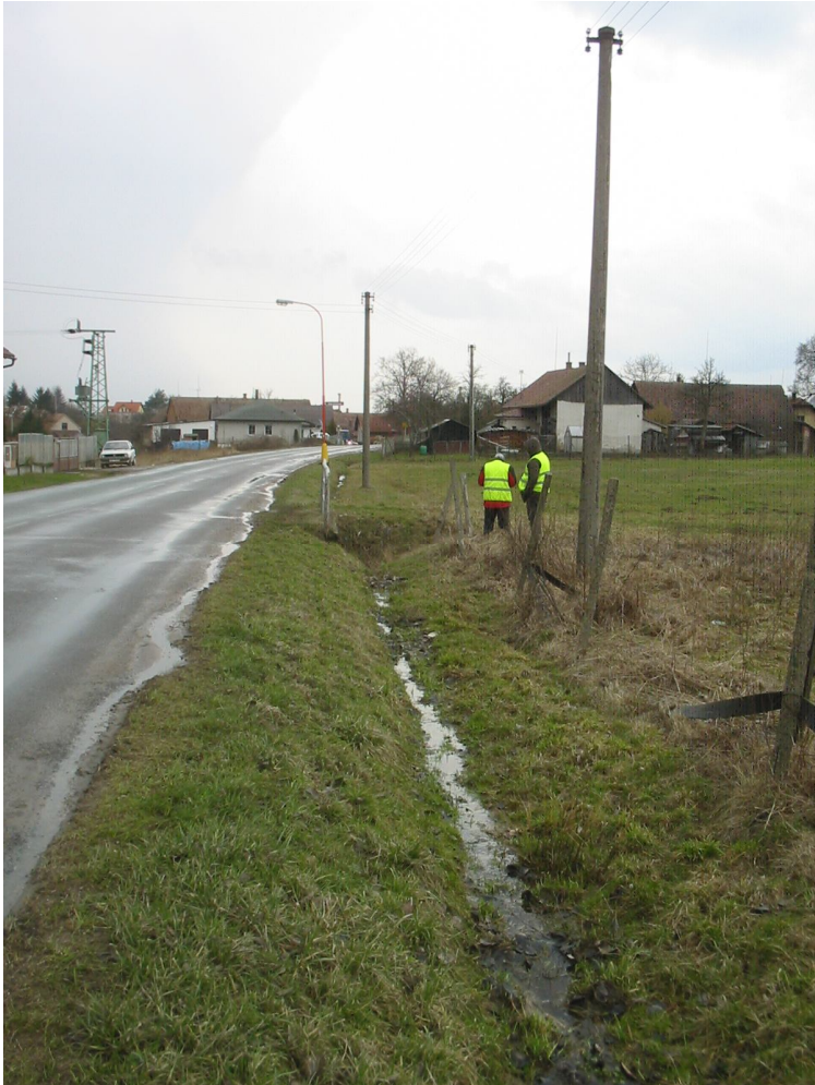
14) Pohled na stav odvodnění - levý příkop a trubní propustek DN800 (staničení km 0,910-0,950)
