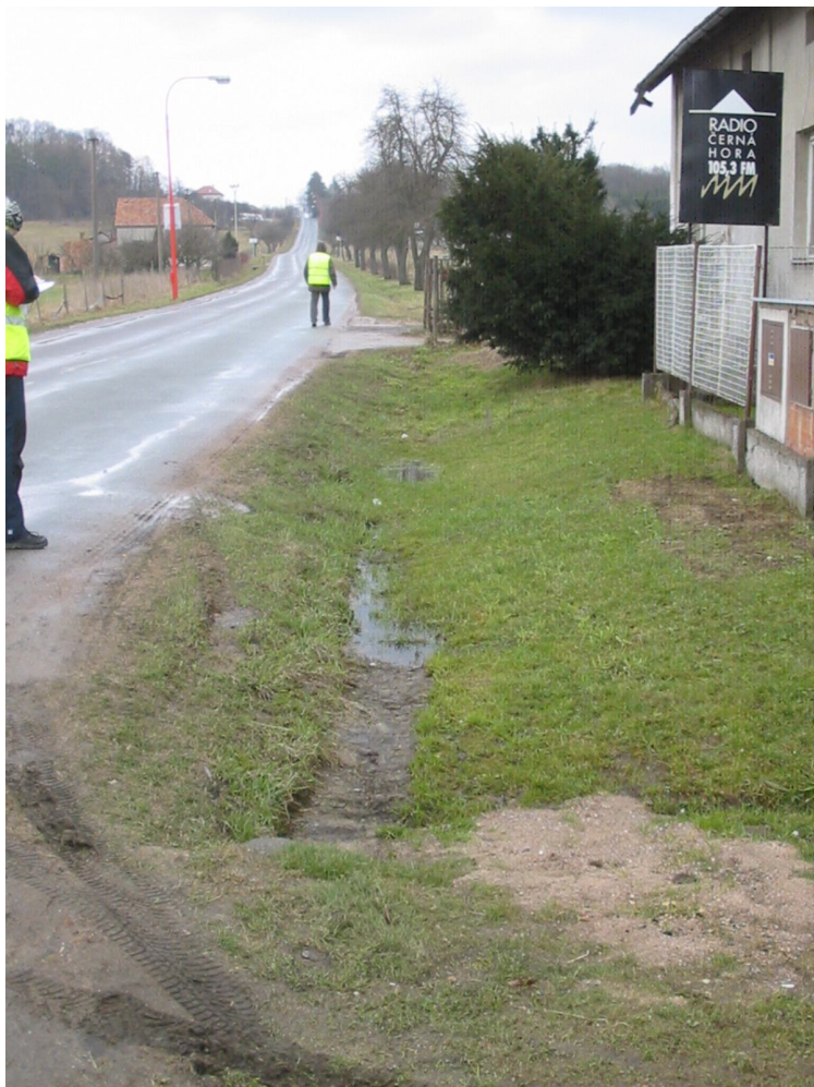
13) Pohled na stav odvodnění - pravý příkop (staničení km 0,900-1,000)
