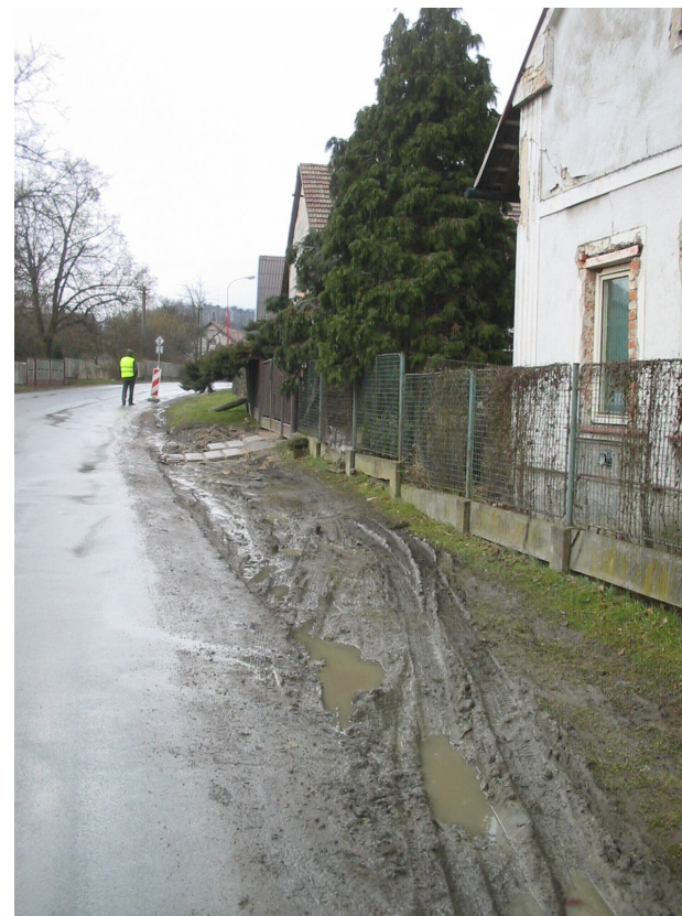
10) Pohled směrem na křižovatku se silnicí III/3183 v místě s nově navrženým autobusovým zálivem a na velmi špatný stav krajnice (staničení km 0,650-0,750)
