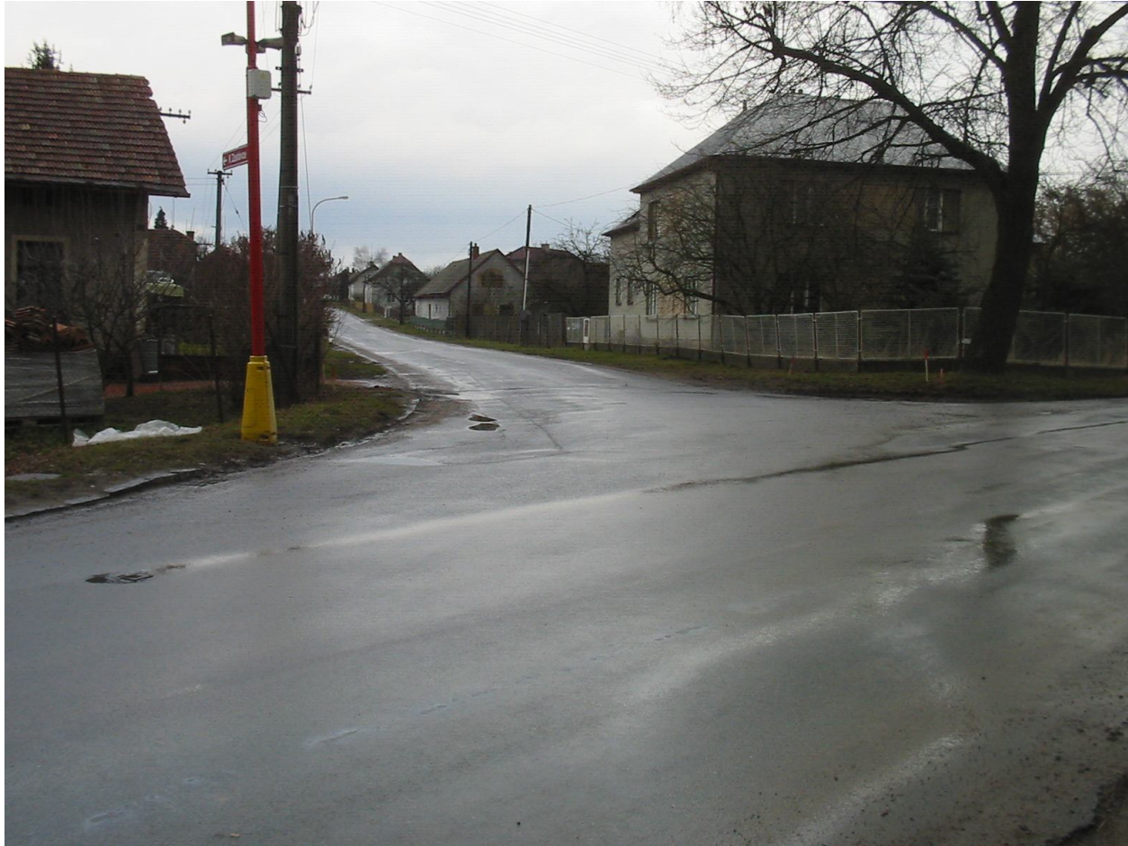
11) Pohled na křižovatku se silnicí III/3183 (dle staničení třetí křižovatka)
