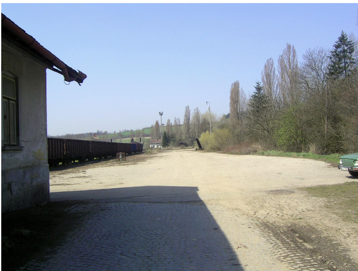
Foto 36 – Pohled na nákladíště od skladiště
