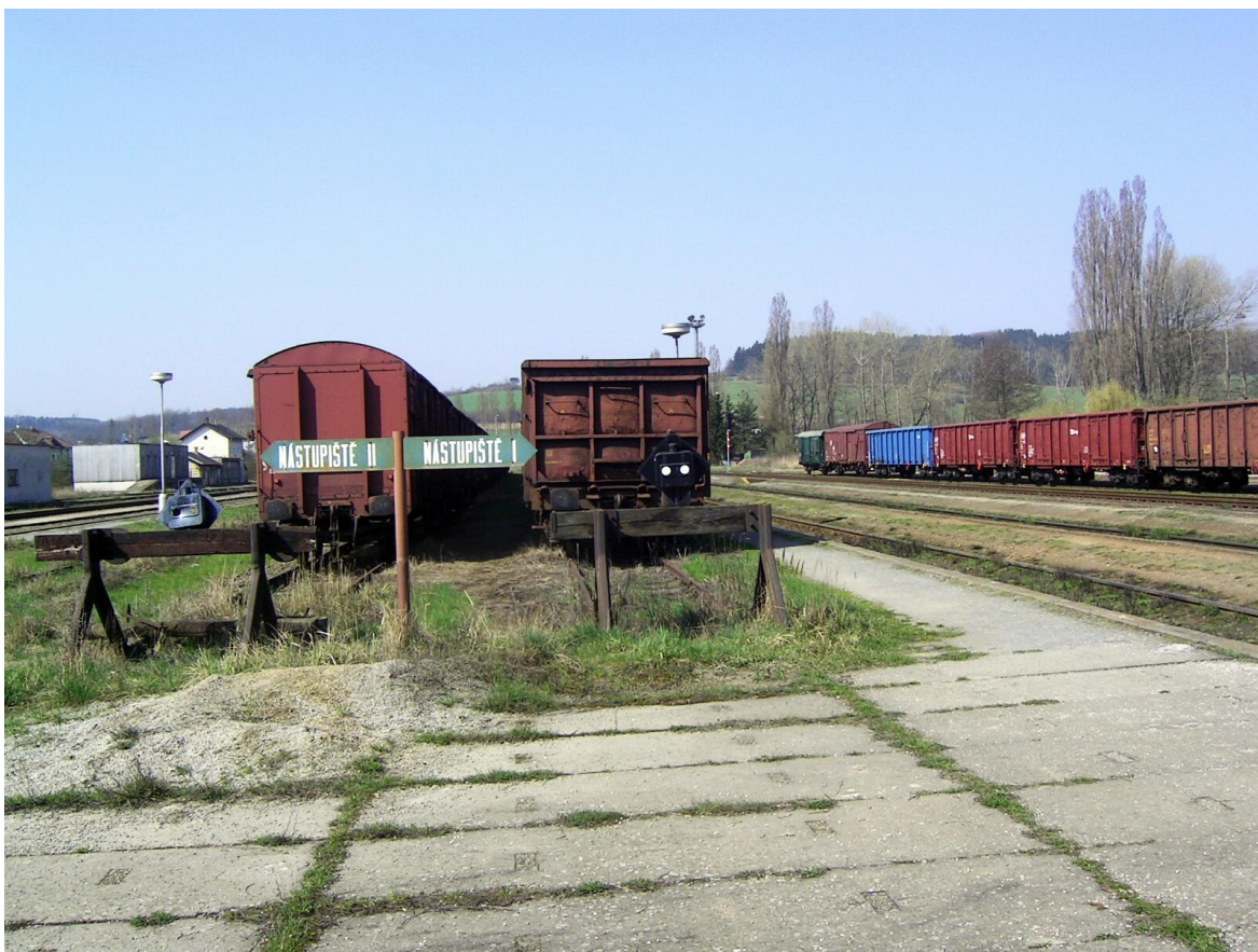
Foto 21 – Ukončení kusých kolejí č. 4 a 6, patrné je označení nástupišť a zpevněná plocha bet. panely
