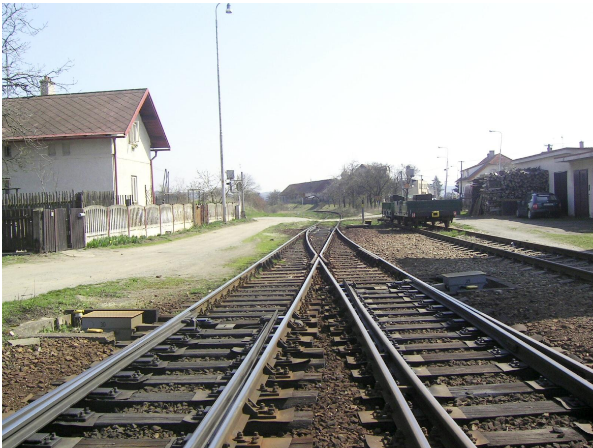
Foto 56 – Výhybky č. 29, 30 a 31 jihlavského zhlaví
