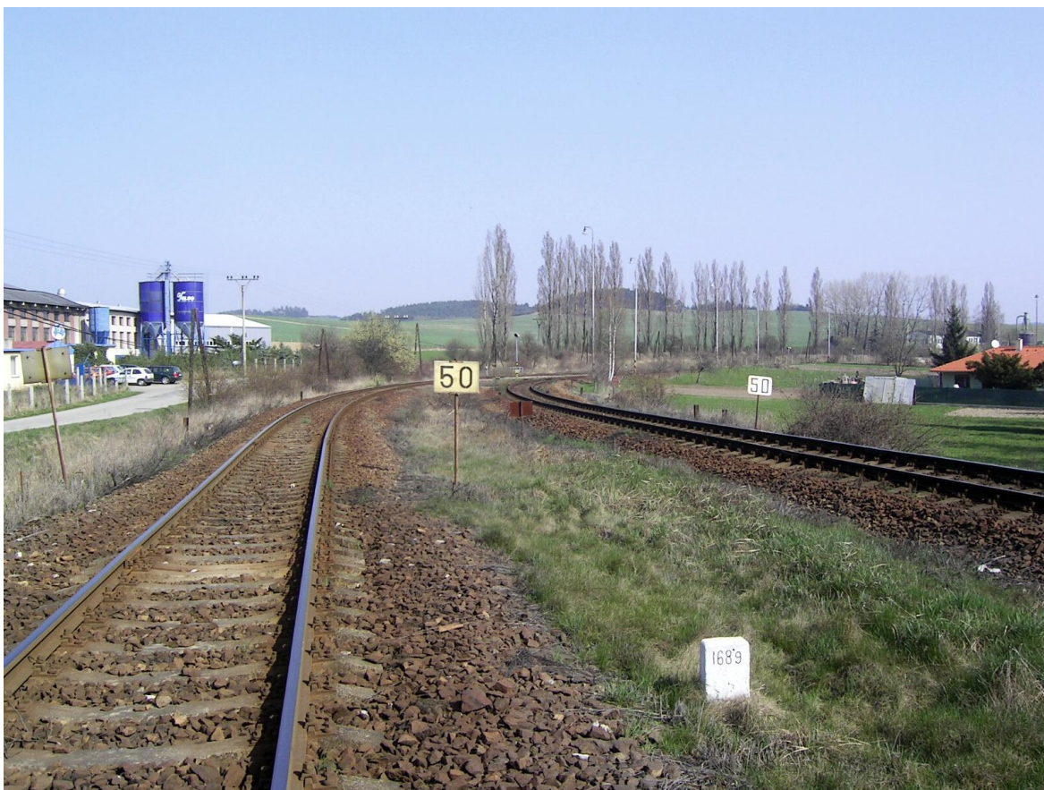
Foto 1 – Vjezd do stanice na znojemské zhlaví od Znojma a Brna
