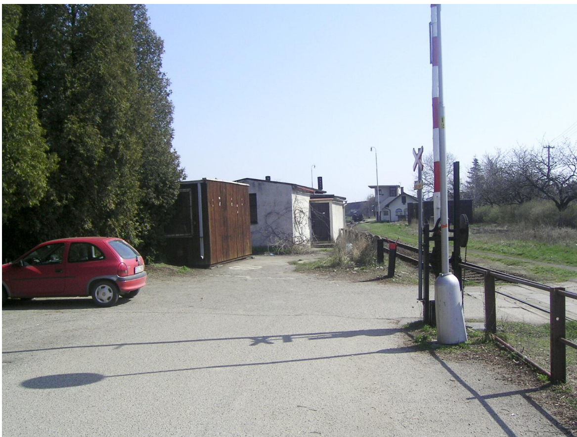
Foto 49 – Přístupová komunikace na nádraží, pohled od výpravní budovy
