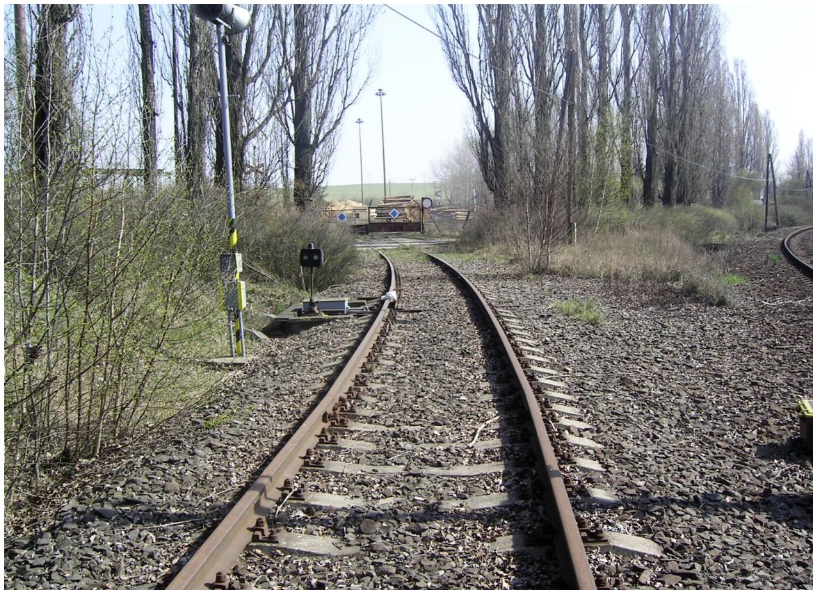
Foto 10 – Vlečka Lesní společnosti Jihlava a. s., vlevo výkolejka LVk 1, tvořící hranici styku drah
