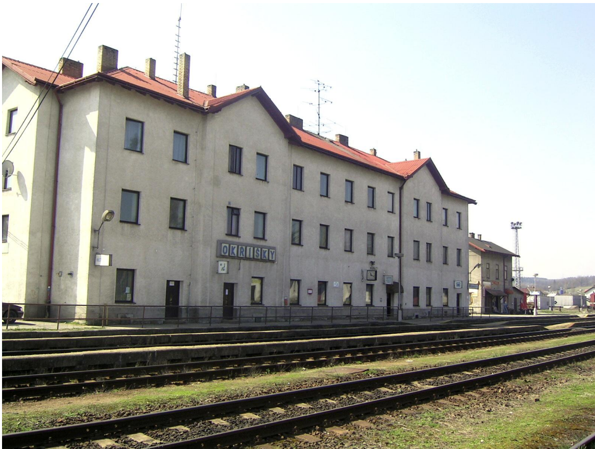
Foto 42 – Pohled na výpravní budovu od výhybky č. 25
