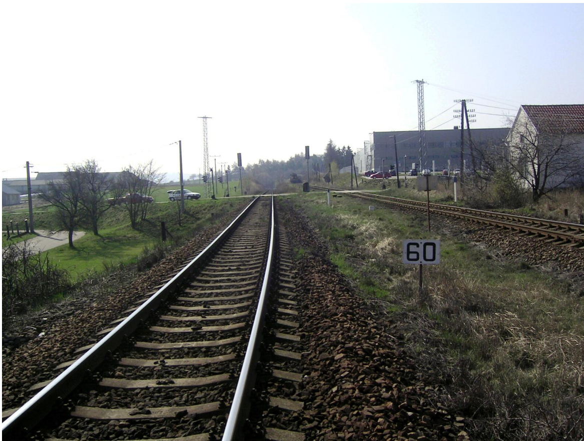
Foto 2 – Dvoukolejný přejezd v km 168,863 od Znojma a v km 60,874 od Brna
