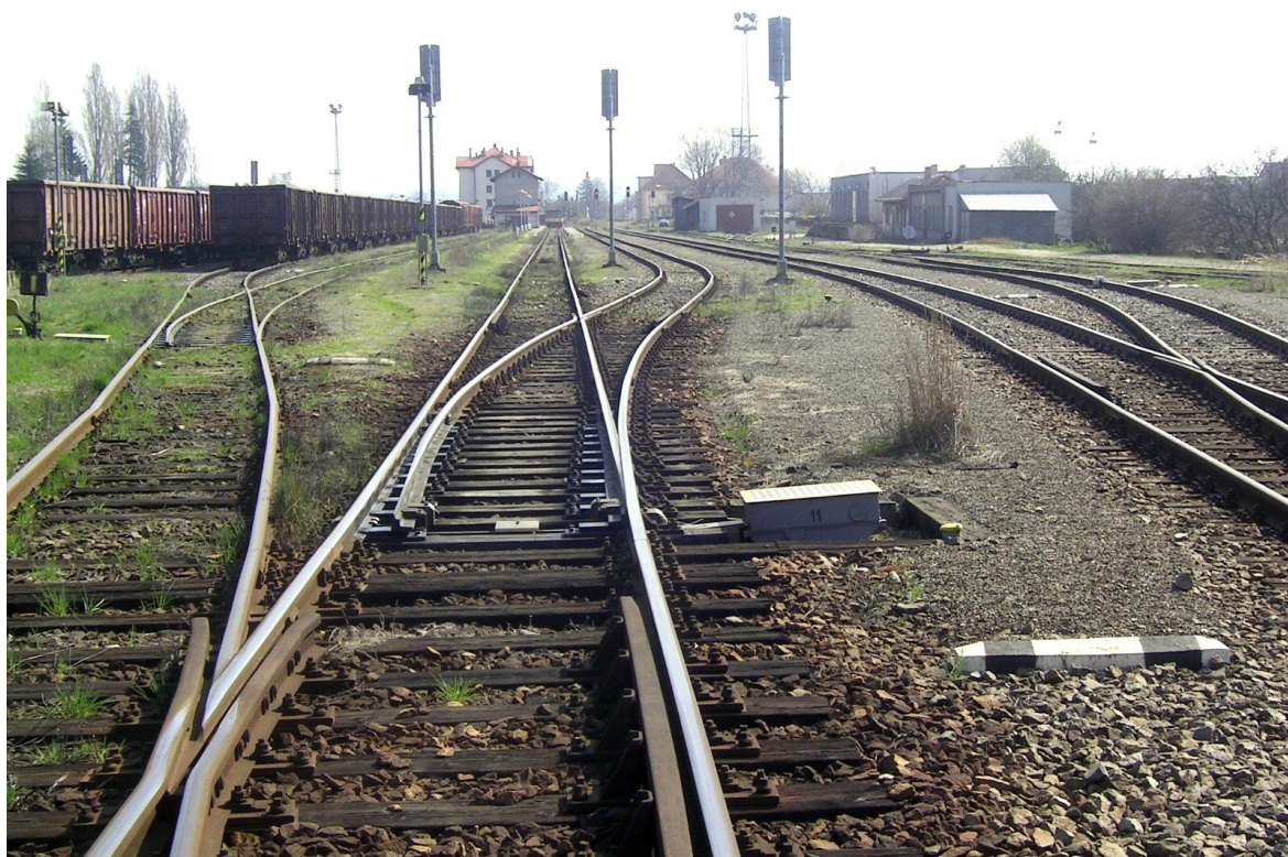
Foto 15 – Pohled na koleje č. 8, 10, 12, které byly rekonstruovány v r. 2004
