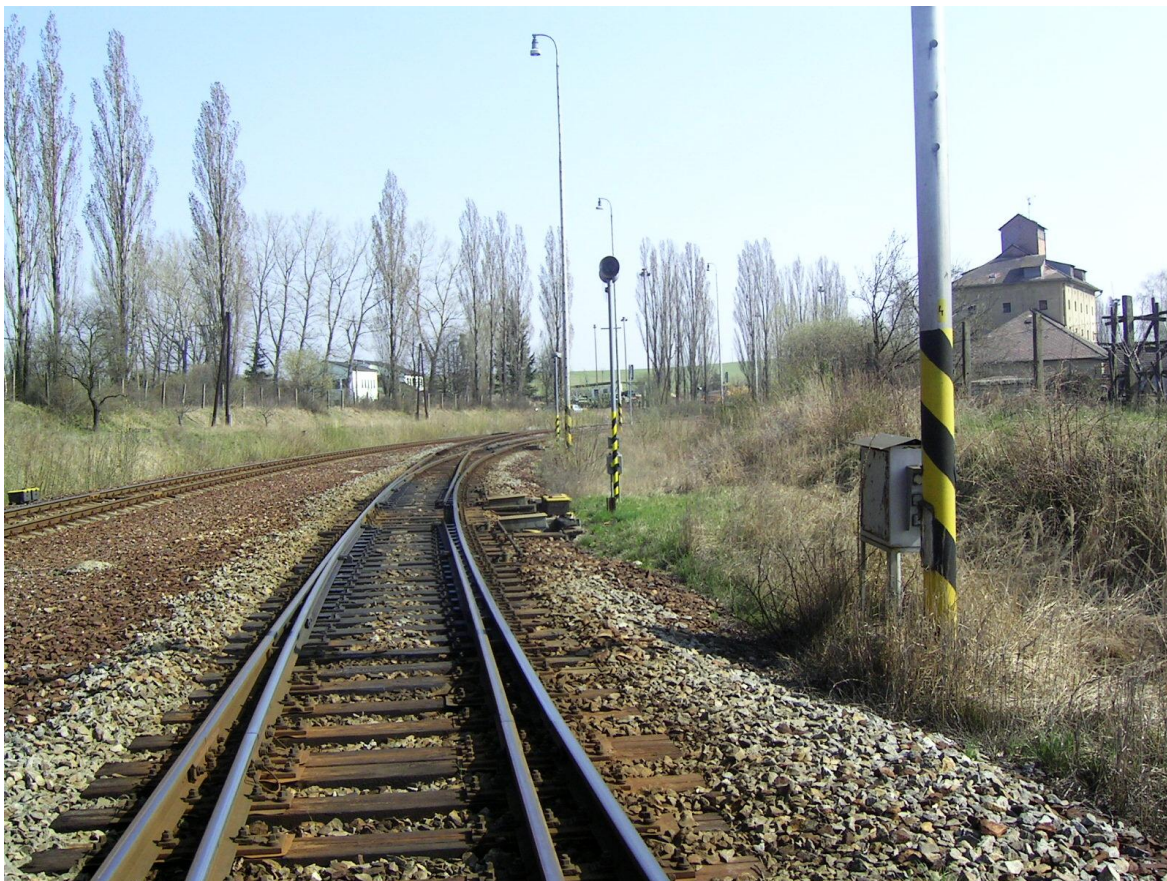
Foto 6 – Výhybky č. 2 a 3 ve směru do stanice ležící v 1. koleji
