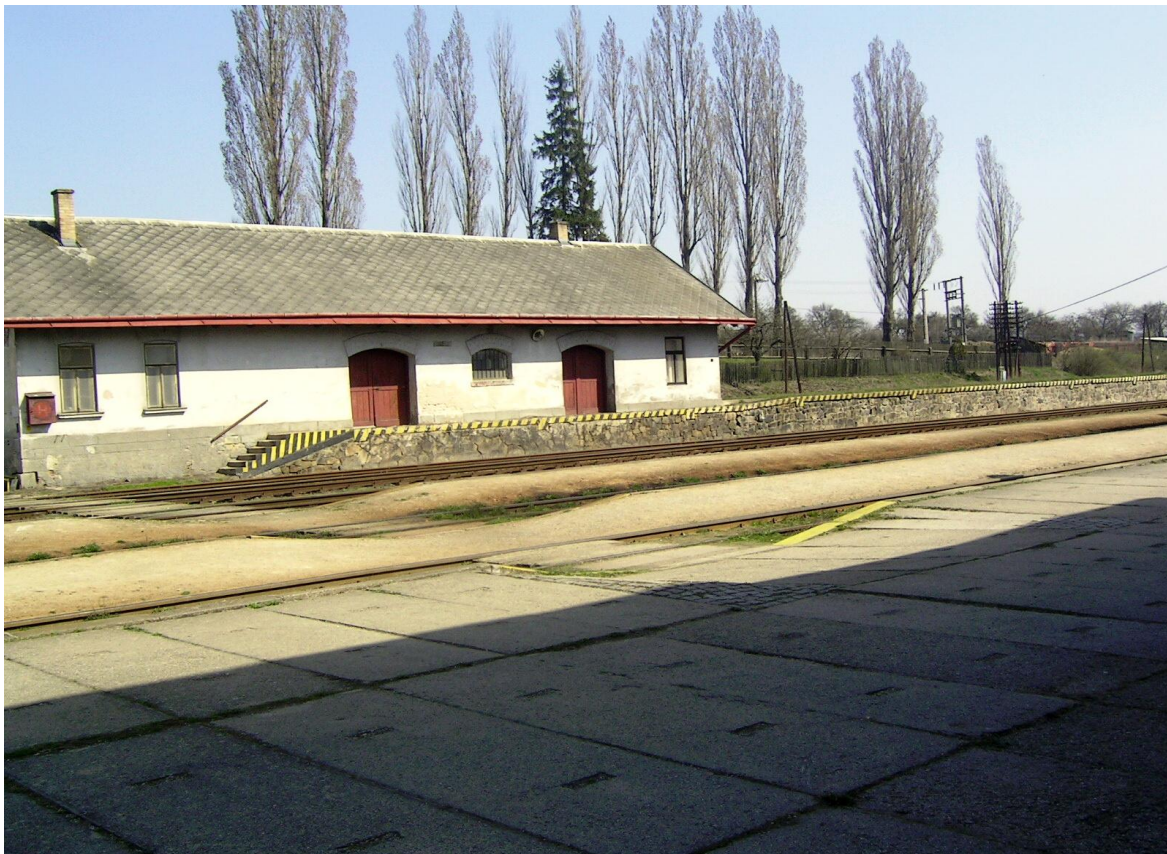
Foto 30 – Pohled na skladiště a boční rampu od bufetu, je vidět i služební přechod ke skladišti
