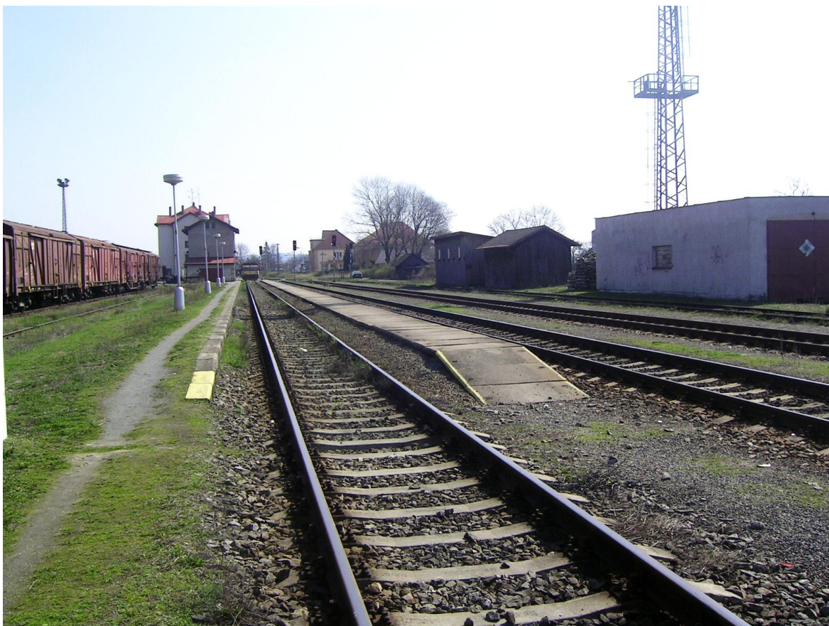
Foto 25 – Zde je vidět ukončení nástupišť u kolejí č. 10 a 12
