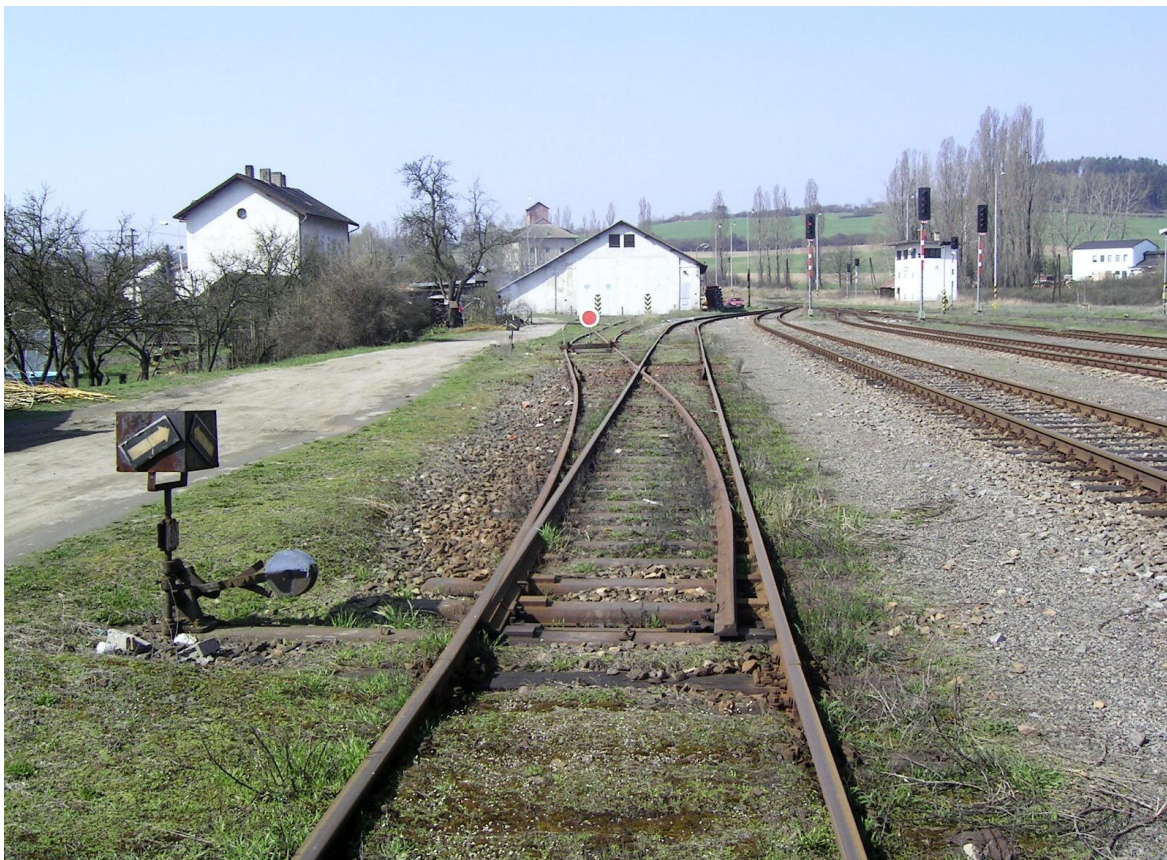
Foto 26 – Odbočení na remízu z koleje č. 16 výhybkou č. 20, majetek RSM Brno
