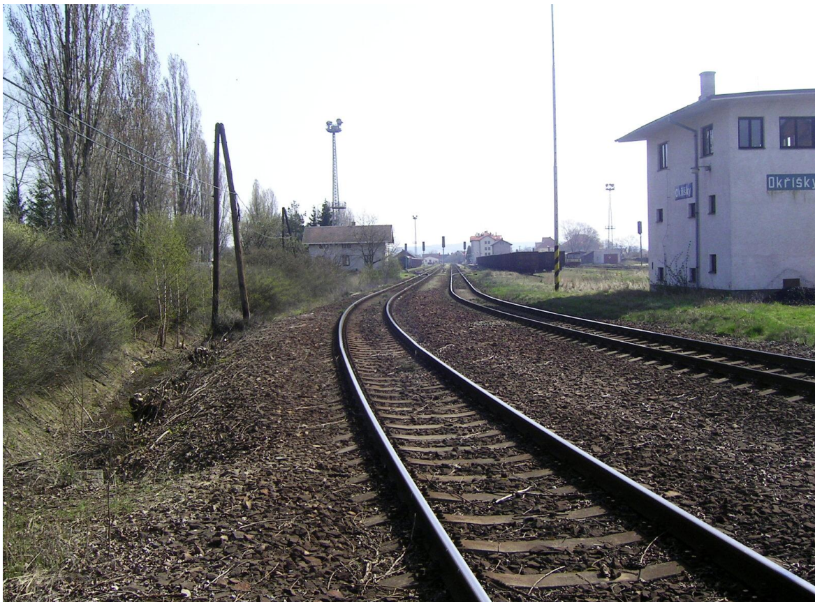
Foto 12 – Vlevo je vidět odvodnění , otevřený nezpevněný příkop, který vede až k mostu v km 169,517
