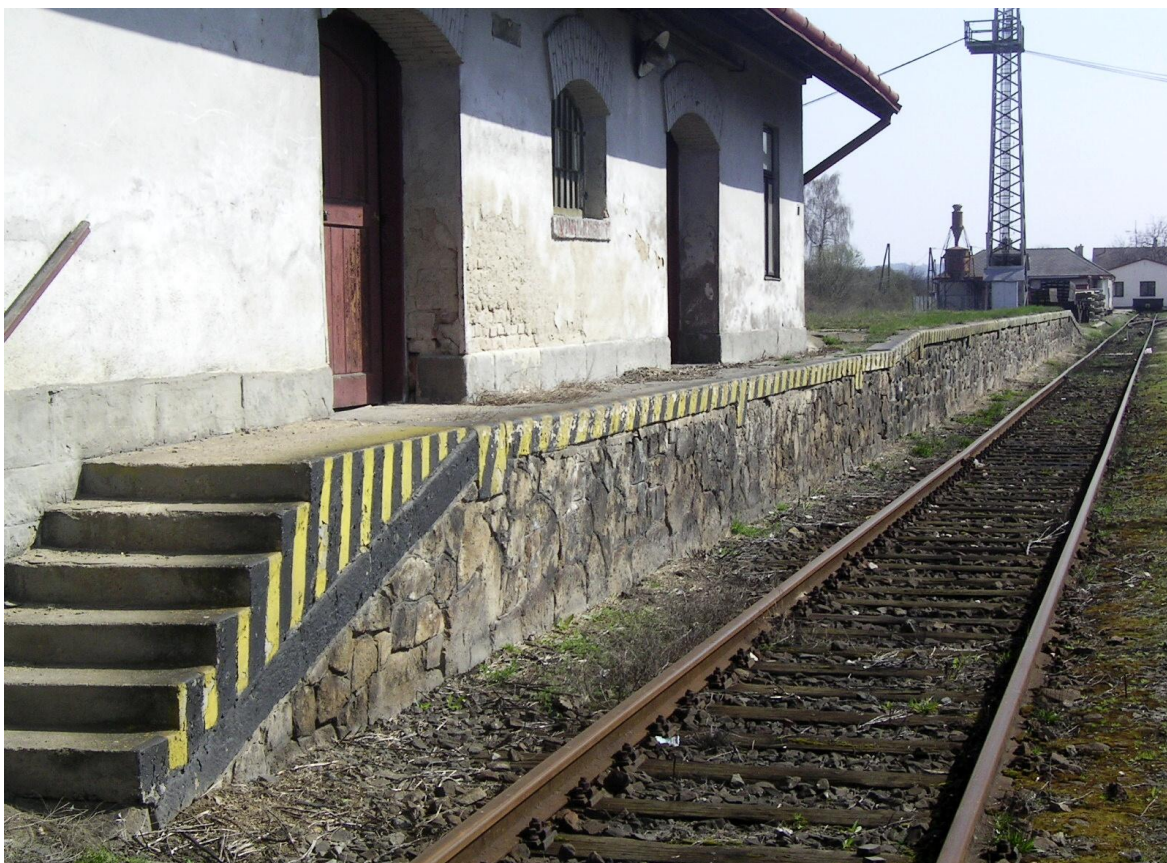
Foto 31 – Příchod na skladiště a boční rampu od koleje č. 7
