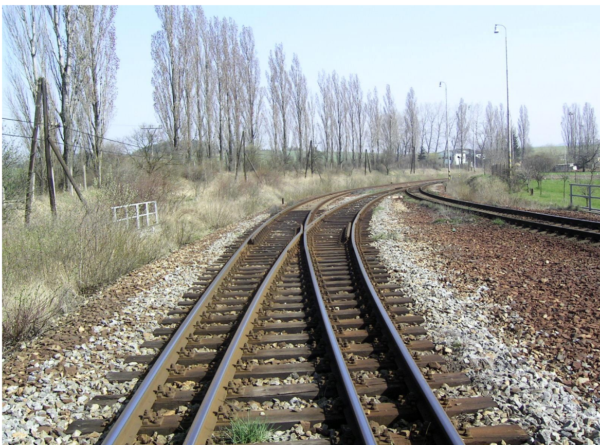
Foto 4 - Spojka z výhybky č. 1 na výhybku č. 2, na okrajích je vidět zábradlí propustku km 169,063
