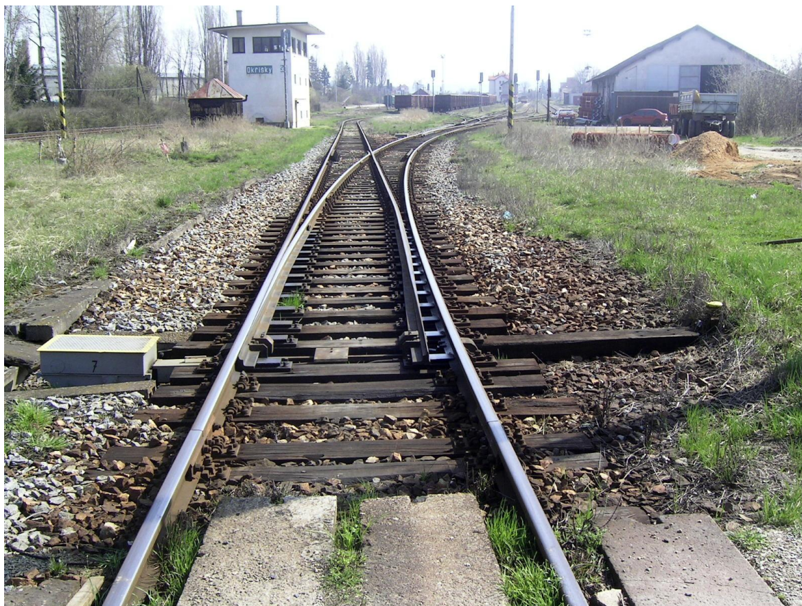
Foto 13 – Vjezd na sudou skupinu kolejí z výhybky č. 7, vlevo je vidět stavědlo St 1
