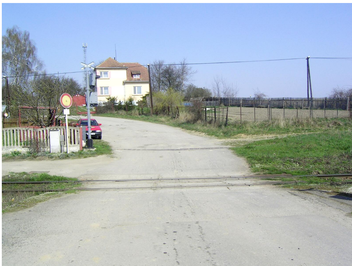
Foto 58 – Účelová komunikace z Nádražní ulice a přejezd v km 170,093
