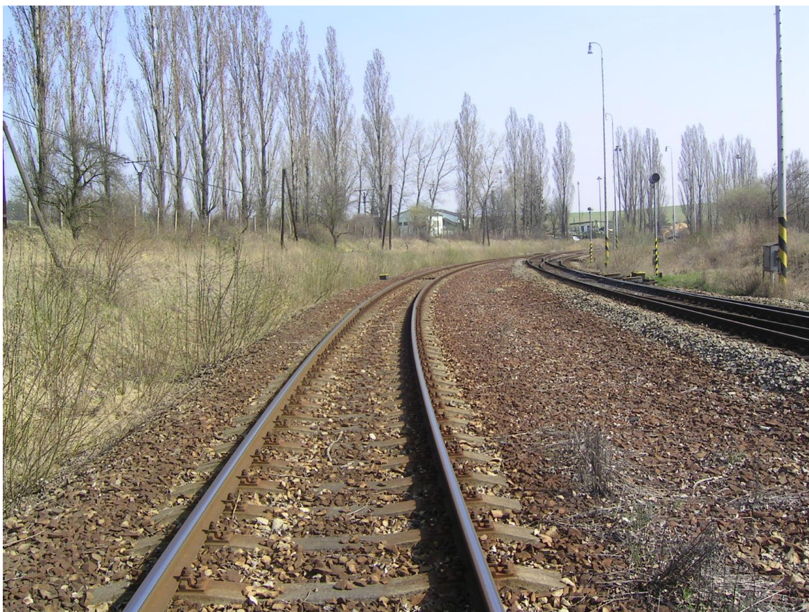
Foto 5 – Pohled od KV č. 1 na kolej č. 3a ve směru do stanice
