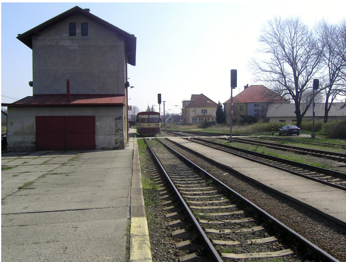
Foto 23 – Přístup na nástupiště u koleje č. 10, nebezpečný průjezdný průřez okolo bufetu
