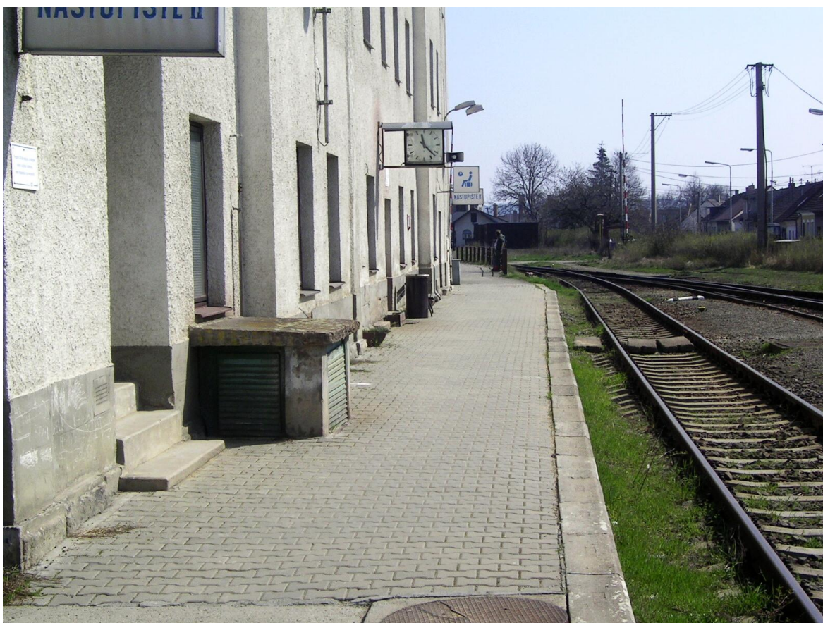
Foto 44 – Pohled na kolej č. 10 podél výpravní budovy ze strany od Nádražní ulice
