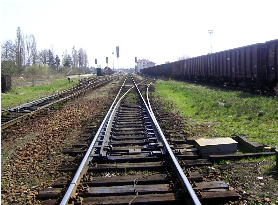
Foto 18 – Pohled do stanice směrem po první koleji od výhybky č. 15
