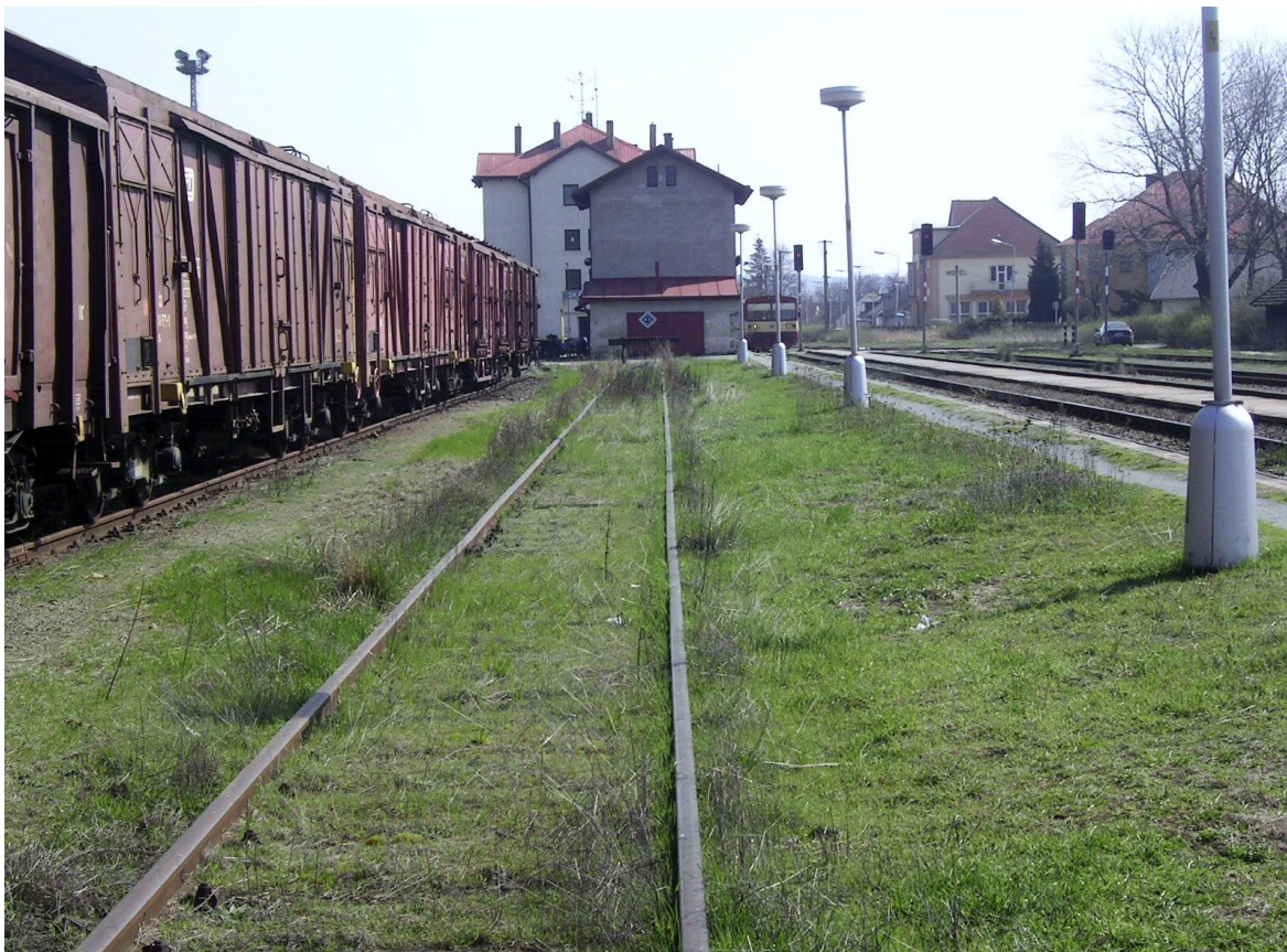
Foto 24 – Kusá kolej č. 8, v pozadí je vidět bufet a výpravní budovu
