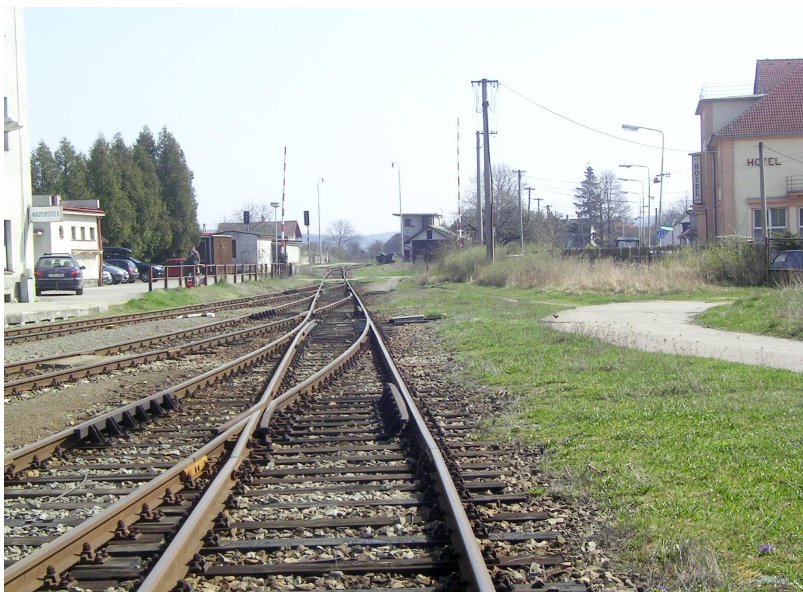
Foto 46 – Matečná kolej směrem od KV č. 22
