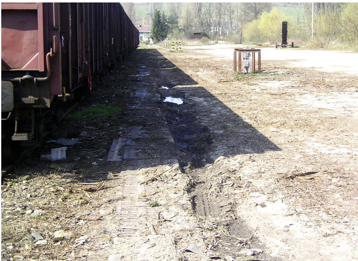
Foto 33 – Odvodnění volné skládky pomocí prahových vpustí
