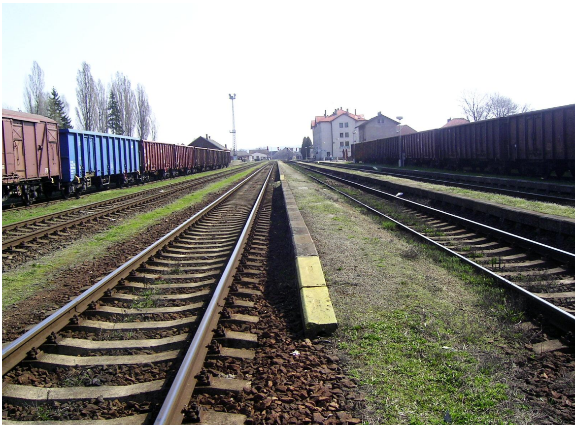
Foto 20 – Úrovňová nástupiště s nástupní hranou Tischer u 1., 2. a 3. koleje
