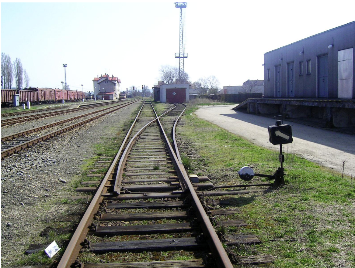
Foto 27 – Odbočení z koleje č. 16 na kolej 18a výhybkou č. 101, majetek SDC Jihlava
