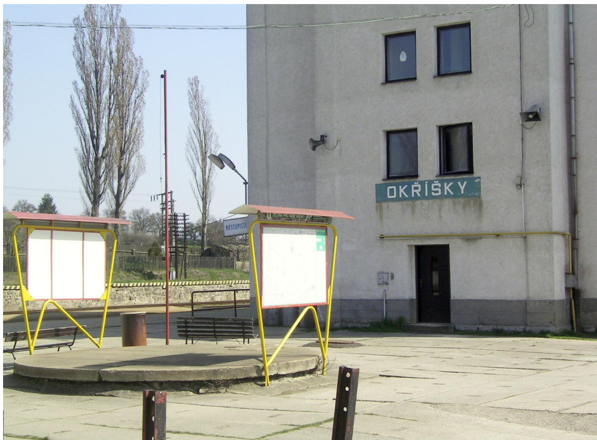
Foto 45 – Plocha pro cestující mezi bufetem a výpravní budovou
