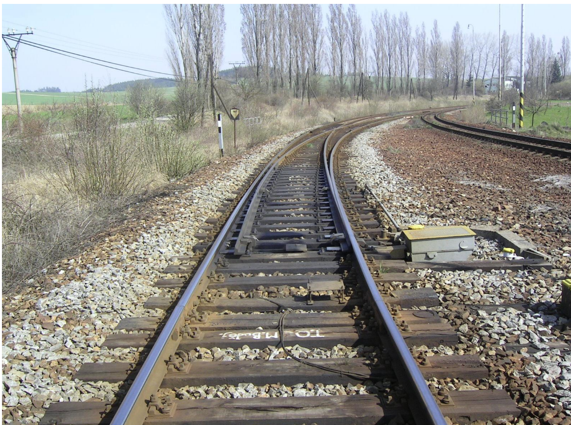
Foto 3 – Vjezdová výhybka č. 1 od Znojma
