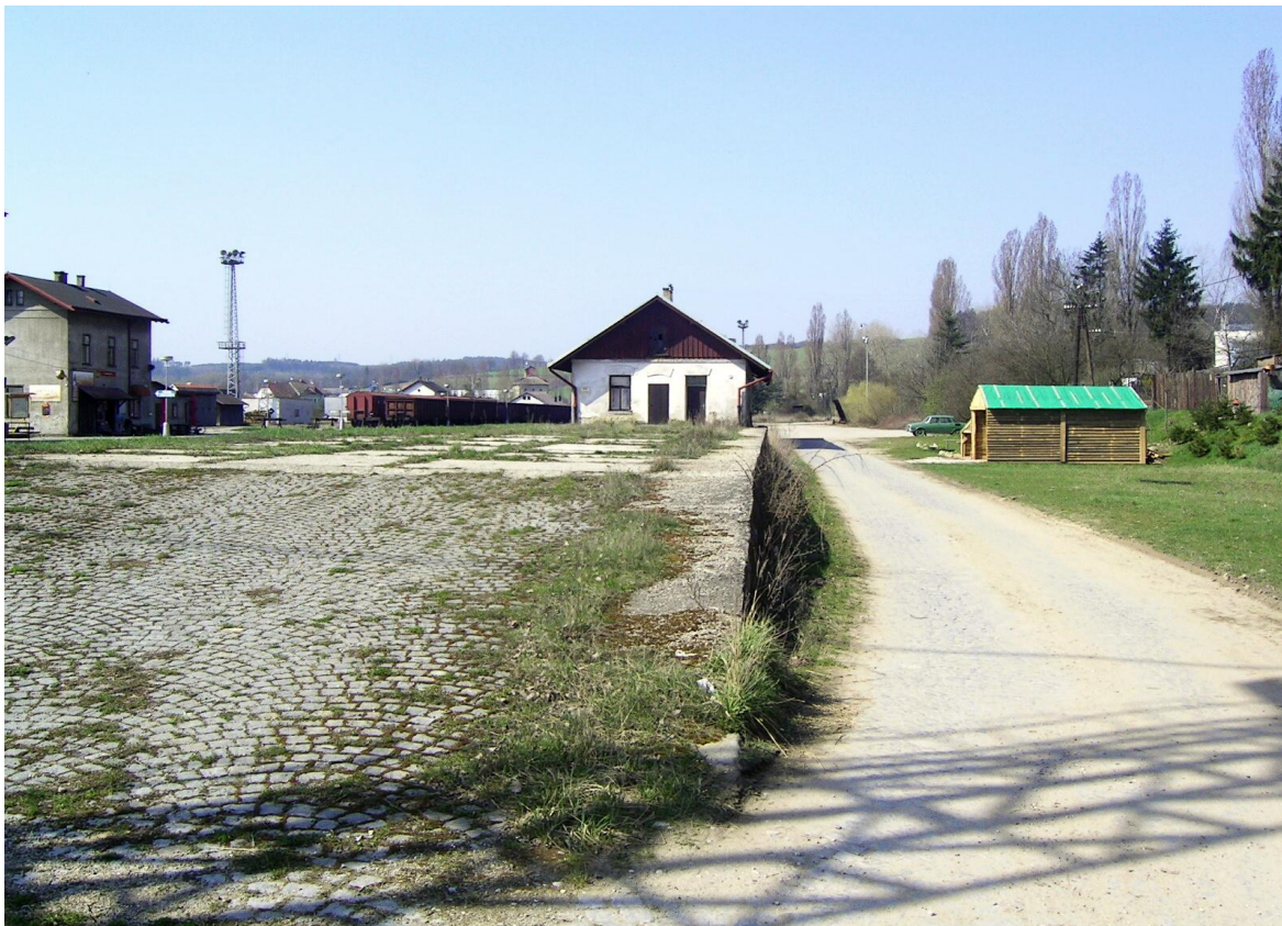
Foto 40 – Nájezd na boční rampu
