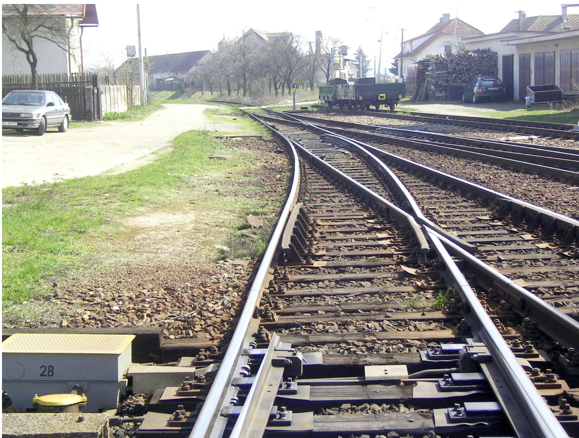
Foto 55 – Přístupová cesta k TO Jihlava podél zhlaví
