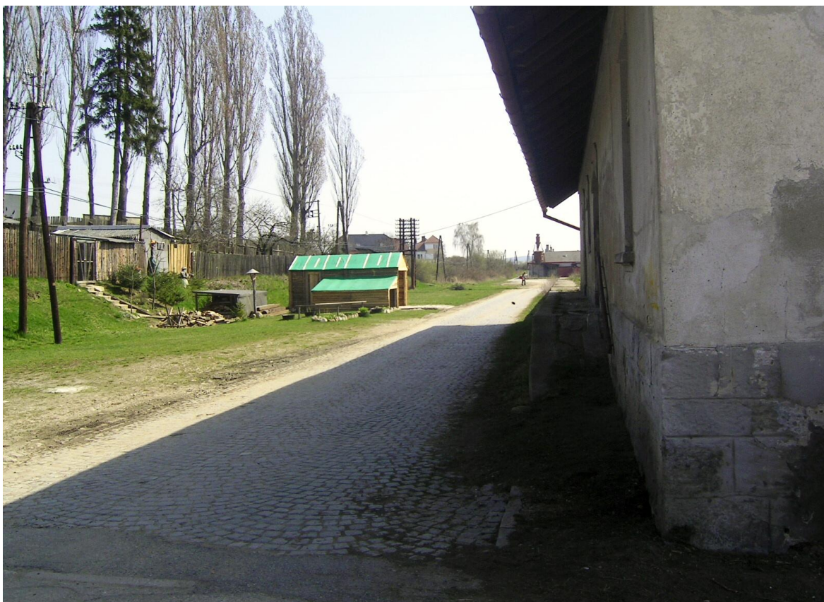
Foto 35 – Přístupová komunikace na volnou skládku podél boční rampy
