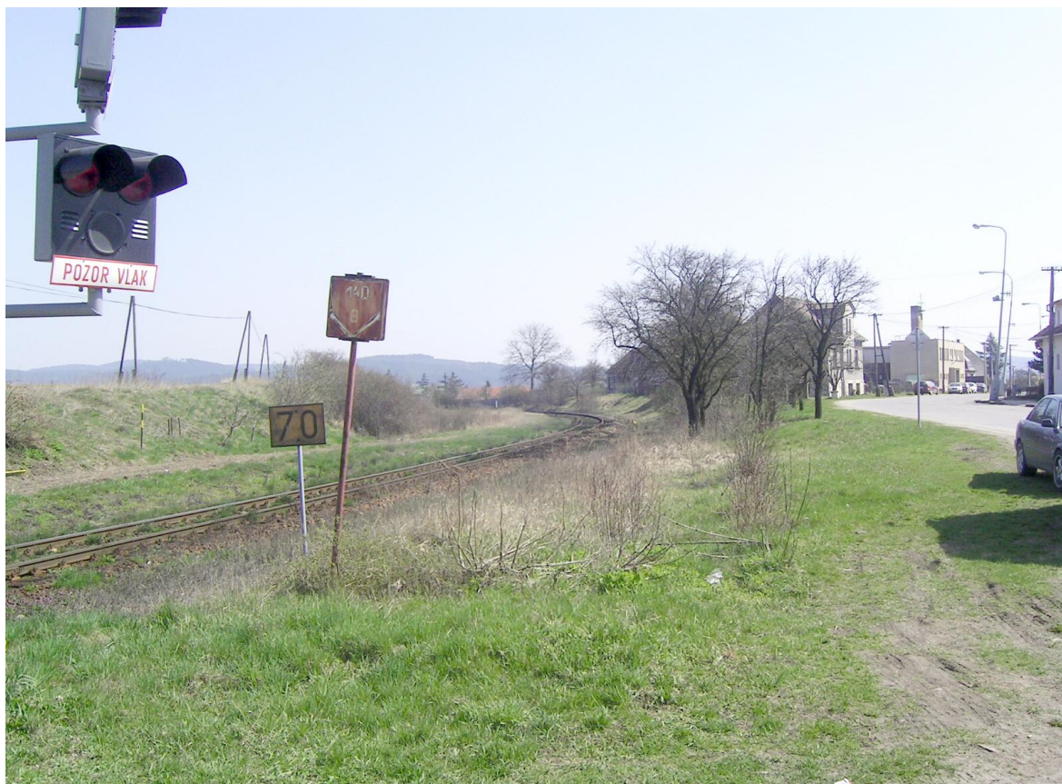
Foto 57 – Pohled na záhlaví stanice ve směru na Jihlavu
