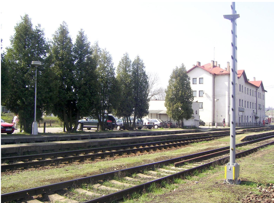
Foto 53 – Pohled na výpravní budovu a nástupiště u kolejí č. 1, 2, 3 od konce stanice
