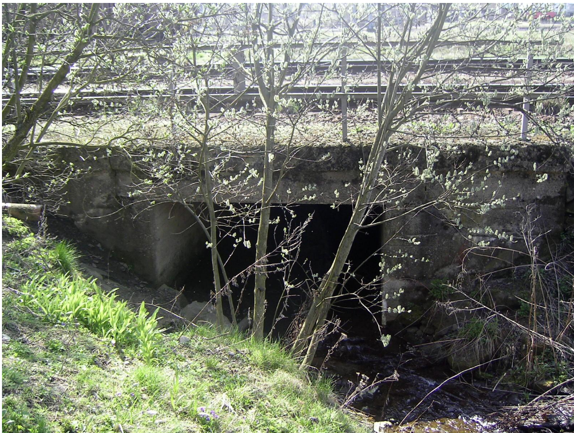
Foto 17 – Vtok mostu km 169,517, který vede napříč všemi staničními kolejemi, pohled od vlečky
