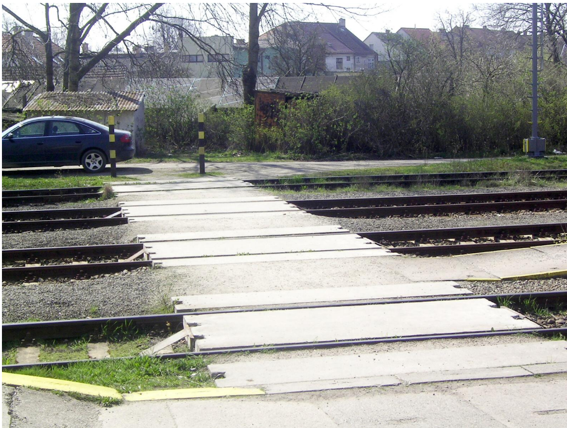
Foto 29 – Další pohled služebního přechodu přes sudé koleje od bufetu
