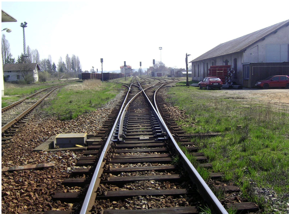
Foto 14 – Pohled do stanice z výhybky č. 8
