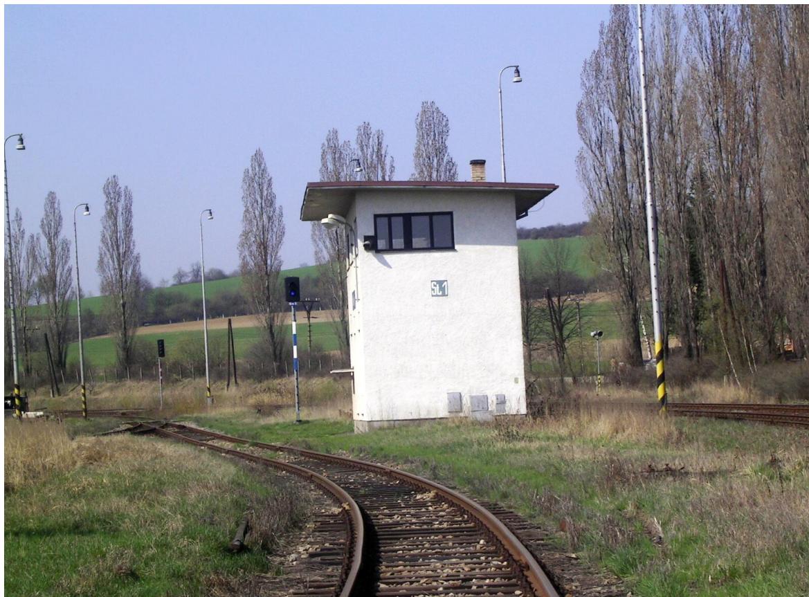
Foto 16 – Pohled na stavědlo St 1 směrem od výpravní budovy z koleje č. 4
