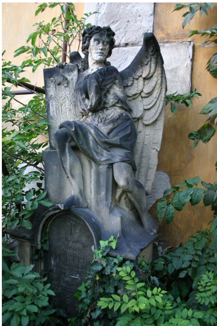
Obr. 1 Náhrobek obklopený rozrůstající se vegetací, která zabraňuje odvětrávání vlhkosti ze spodní poloviny náhrobku.
