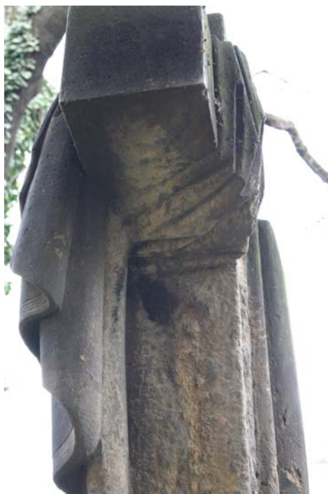
Obr. 4. Povrchová koroze kamene
