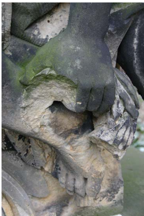
Obr. 5. Mechanické poškození v partii ruky s věncem
