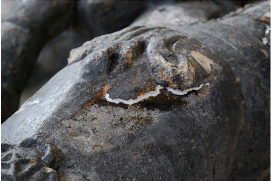
Obr. 54: Injektáž dutin a uvolněného tmelu v okolí lilie na trupu světce.
