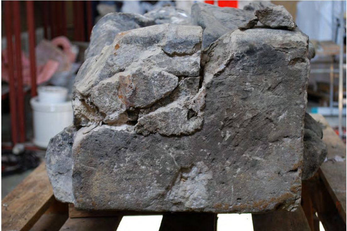
Obr. 42: Stav podstavce sochy svatého Václava. Odstranění nevhodných cementových vysprávek v okolí statické trhliny.
