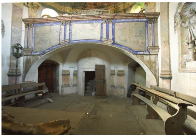
6. Pohled od oltáře na západ – na kruchtu a podkruchtí s trojicí dveřních prostupů, vlevo dnešní jediný vstup z exteriéru do lodi
