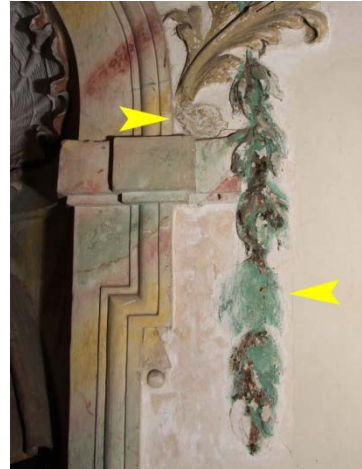
41. Povrchové úpravy na plastické výzdobě vně architekturu V niku provedené i místech ztrát štukového reliéfu
