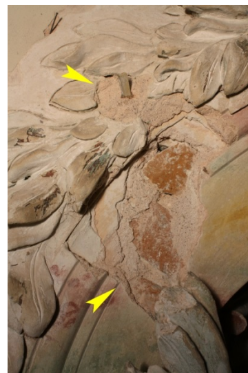
48. Obnažená štuková souvrství v šambráně niky a festonu (na záběru chybí část obvodového profilu, několik listů a celé jablko), ztráty v omítkovém souvrstvích stěny lodi umožňují pozorovat způsob zdění cihelného záklenku této SZ niky.
