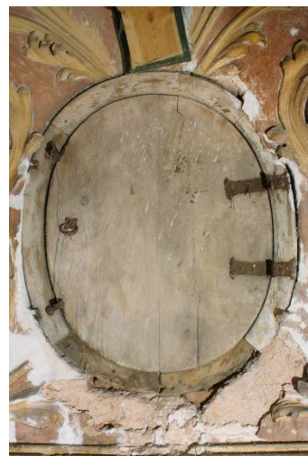
23. Stav dochování servisních dvířek v klenbě, resp. před konzervačním zásahem, snímek z roku 2013
