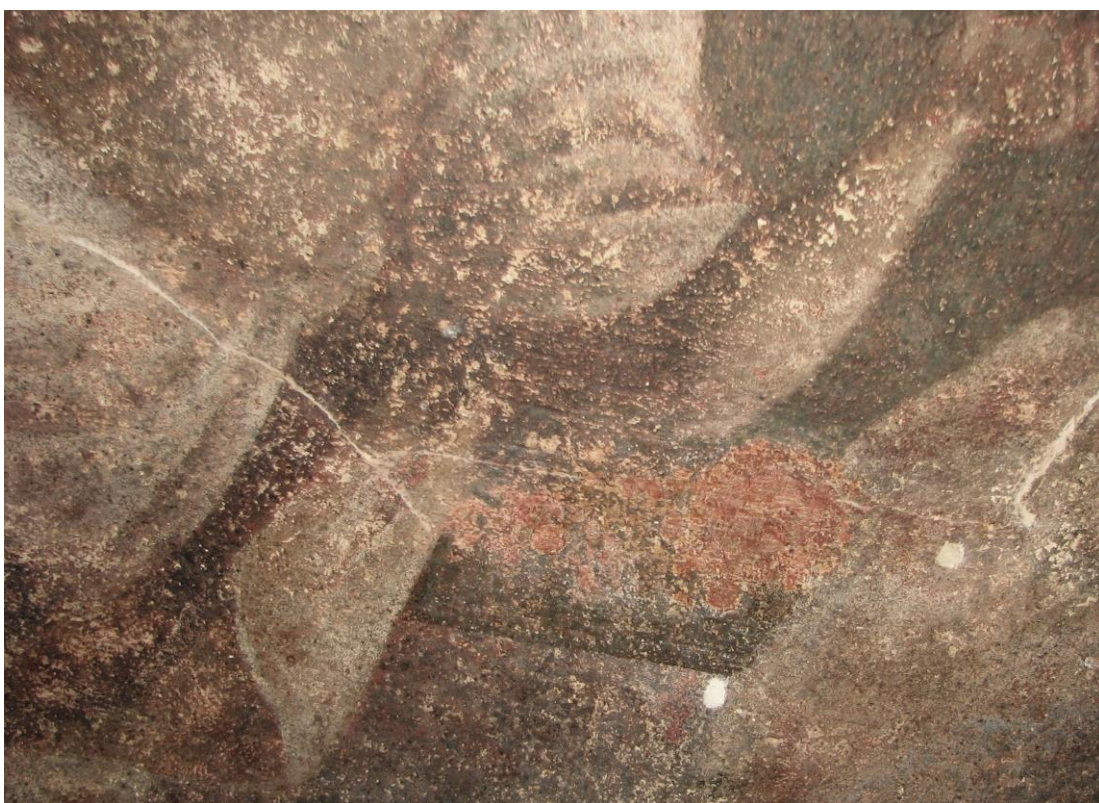
Obr. 25 Zapojování vytmelených a poškozených míst pomocí červené podkladové retuše.
