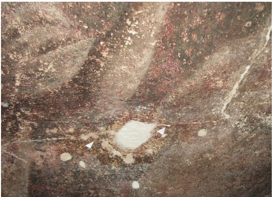
Obr. 24 Detail malby po vytmelení drobných defektů.
