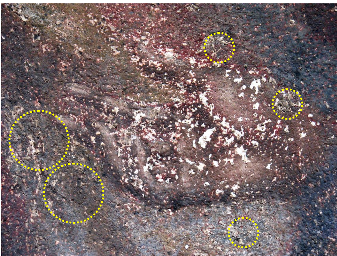
Obr. 6 Detail malby po sejmutí plísní. Jsou viditelné uvolněné krakely barevné vrstvy (ohraňčeno žlutou přerušovanou čarou na fotografii). Fotografováno v umělém světle.
