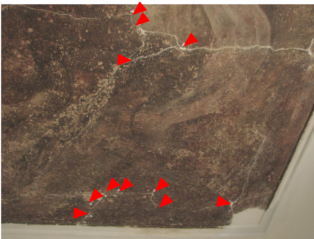
Obr. 21 Detail malby po vytmelení prasklin, defektů v omítkové vrstvě a doplnění profilu štukového rámu. Šípkami jsou označena uvolněná místa v omítkové vrstvě, kde byla aplikována injektážní směs.
