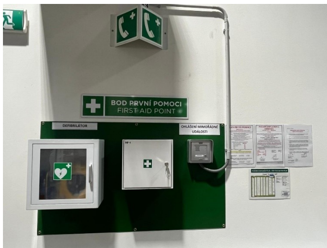
Obrázek 6 - Bod první pomoci na montáži
