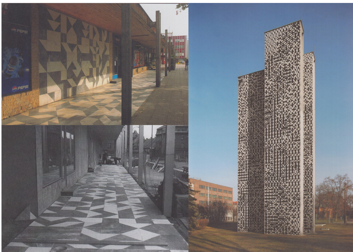
Obrázek 9: Chodník a zeď v Litvínově, větrací komíny Letenského tunelu. Zdroj:[1].
