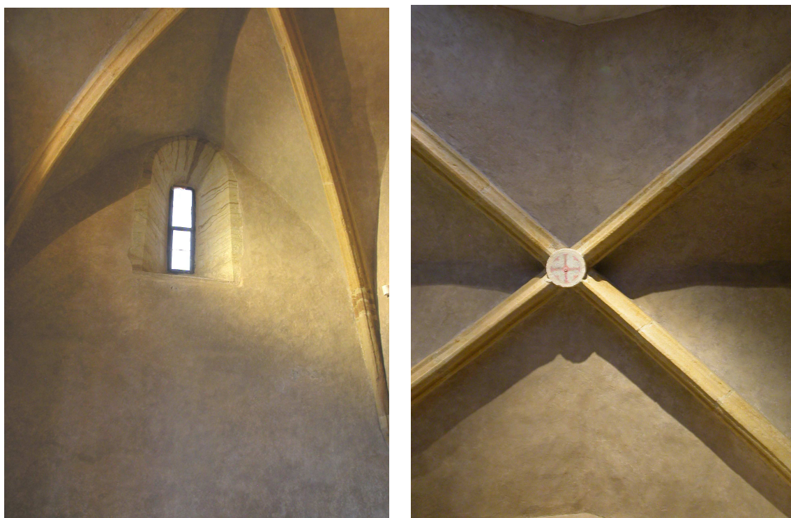
Obr. č. 9 Románské okno a hruškovitý profil klenebních žebér v sakristii přeloučského kostela
