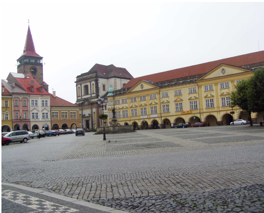
Valdštejnovo náměstí v Jičíně před rekonstrukcí
