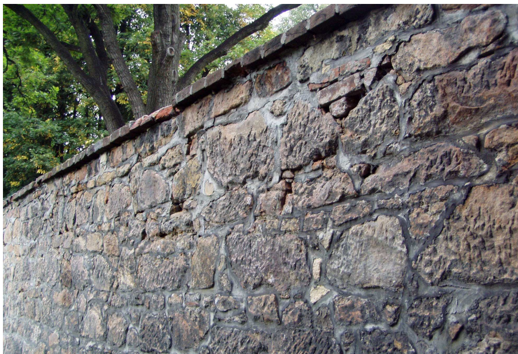
Městské hradby v Jičíně před rekonstrukcí
