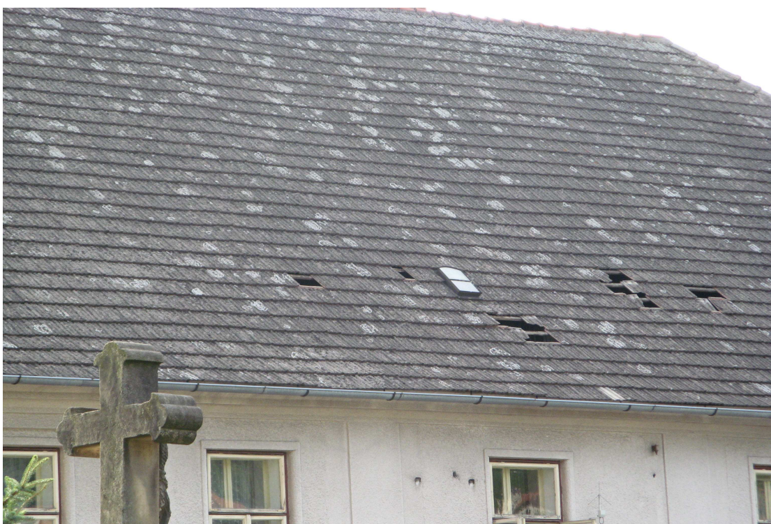
Úřad městyse Pecka, před rekonstrukcí střechy
