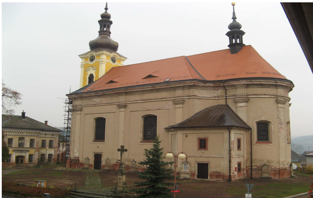
Kostel sv. Bartoloměje v Pecce, oprava fasády
