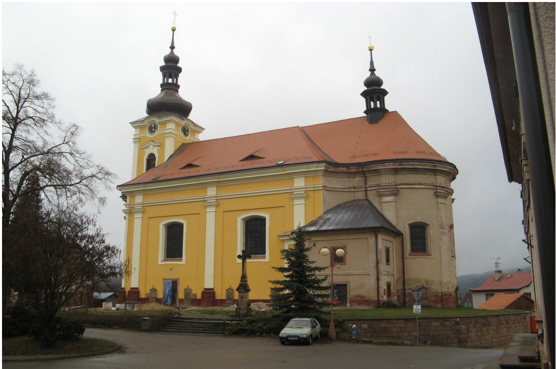
Kostel sv. Bartoloměje v Pecce, oprava fasády boční stěny
