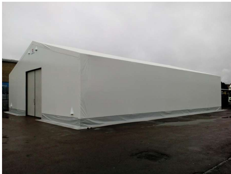
Obrázek 8 – Opláštění pomocí hi-tech membrány, vnější pohled
