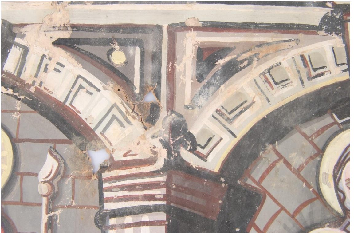
Obr. 68. Průběh restaurování, detail poškození, fotografie po suchém čištění, lícová strana.
