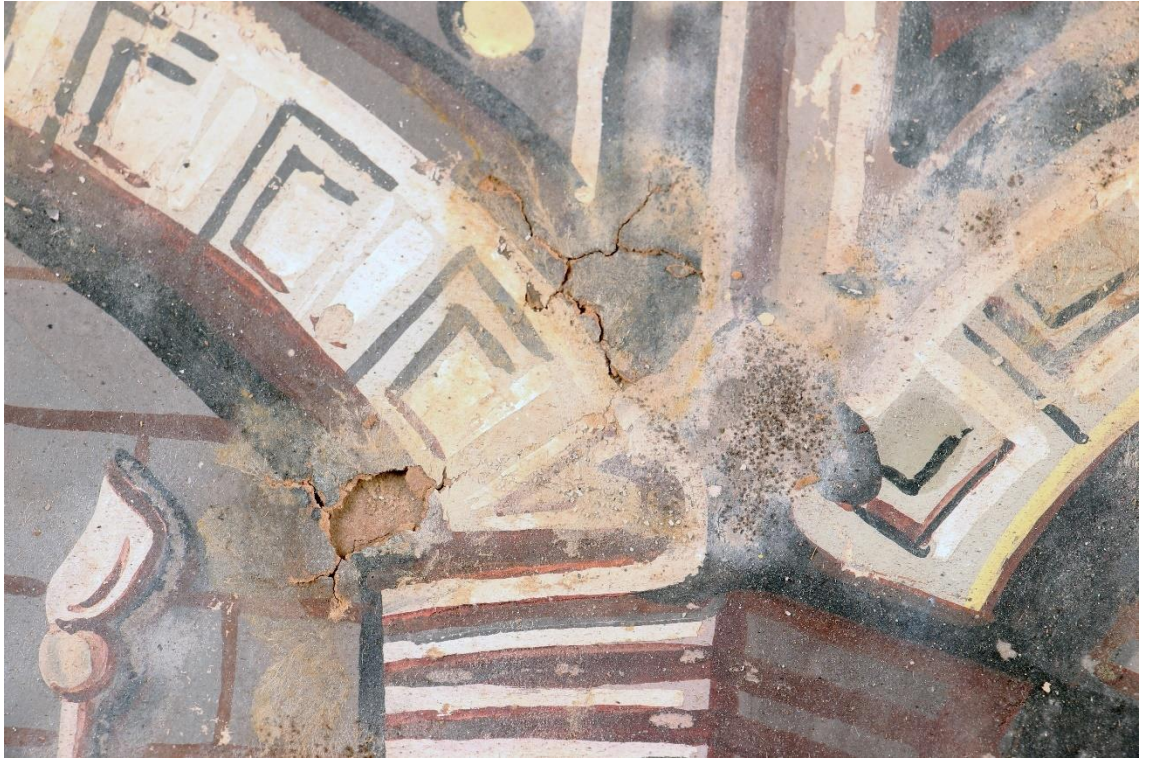
Obr. 63. Stav před restaurováním, detail poškození, denní rozptýlené světlo, lícová strana.
