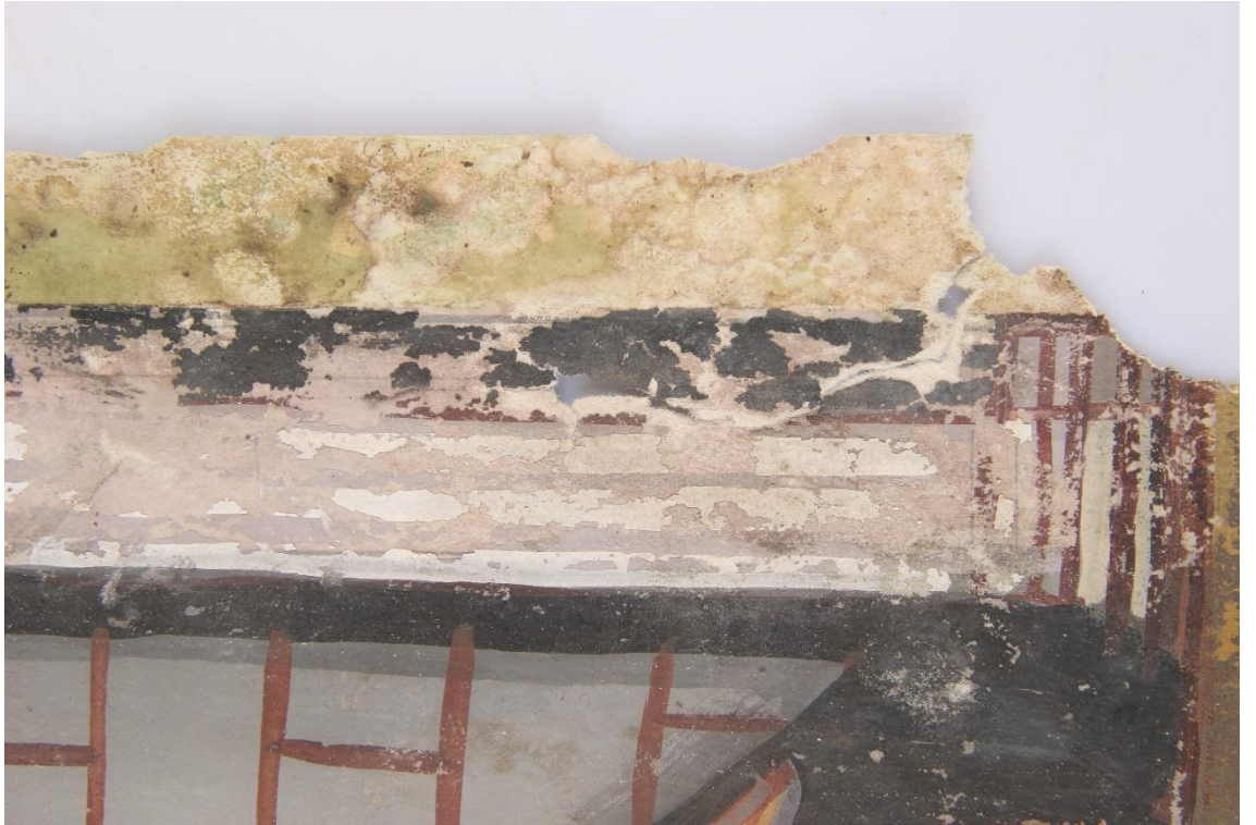
Obr. 71. Průběh restaurování, detail poškození, fotografie po suchém čištění, lícová strana.
