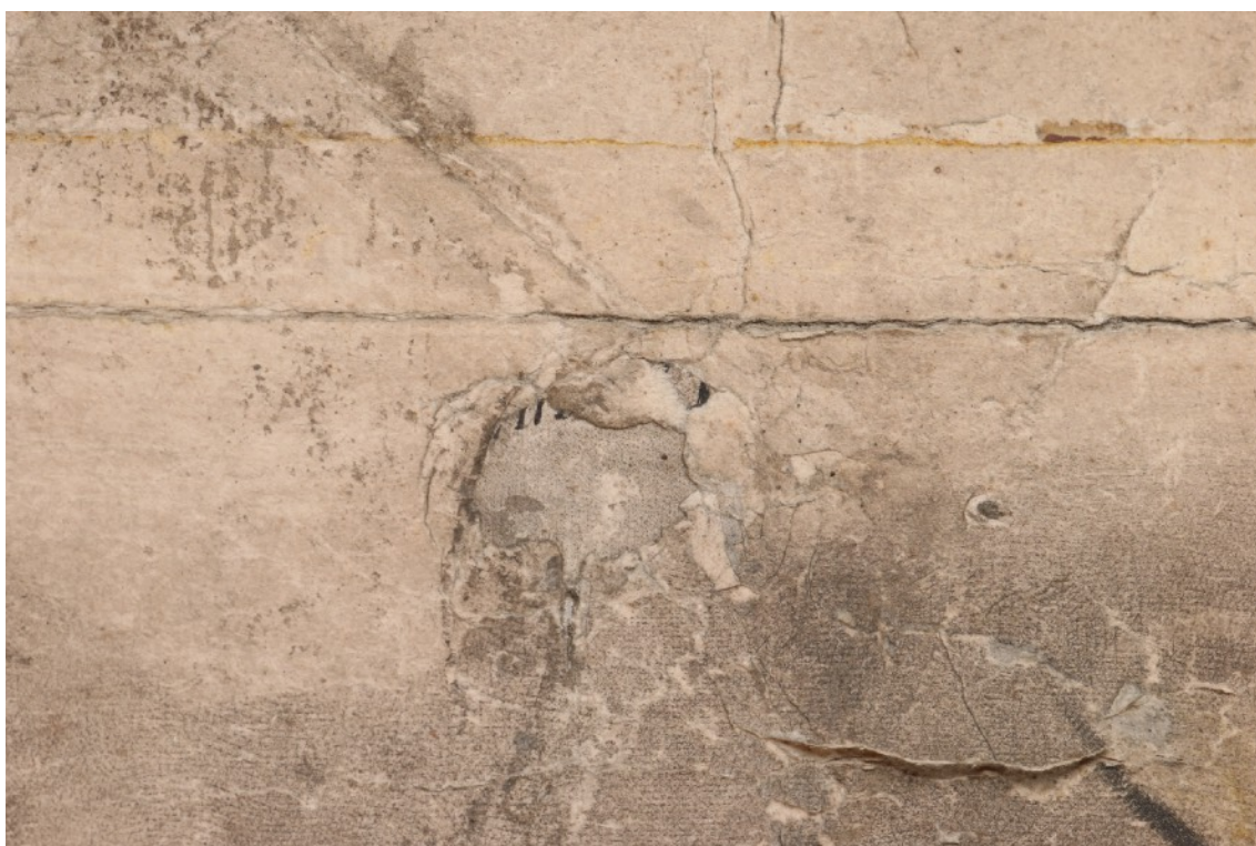
Obr. 14: Stav před restaurováním, rozptýlené světlo, detail druhotného doplňku a poškození, lícová strana
