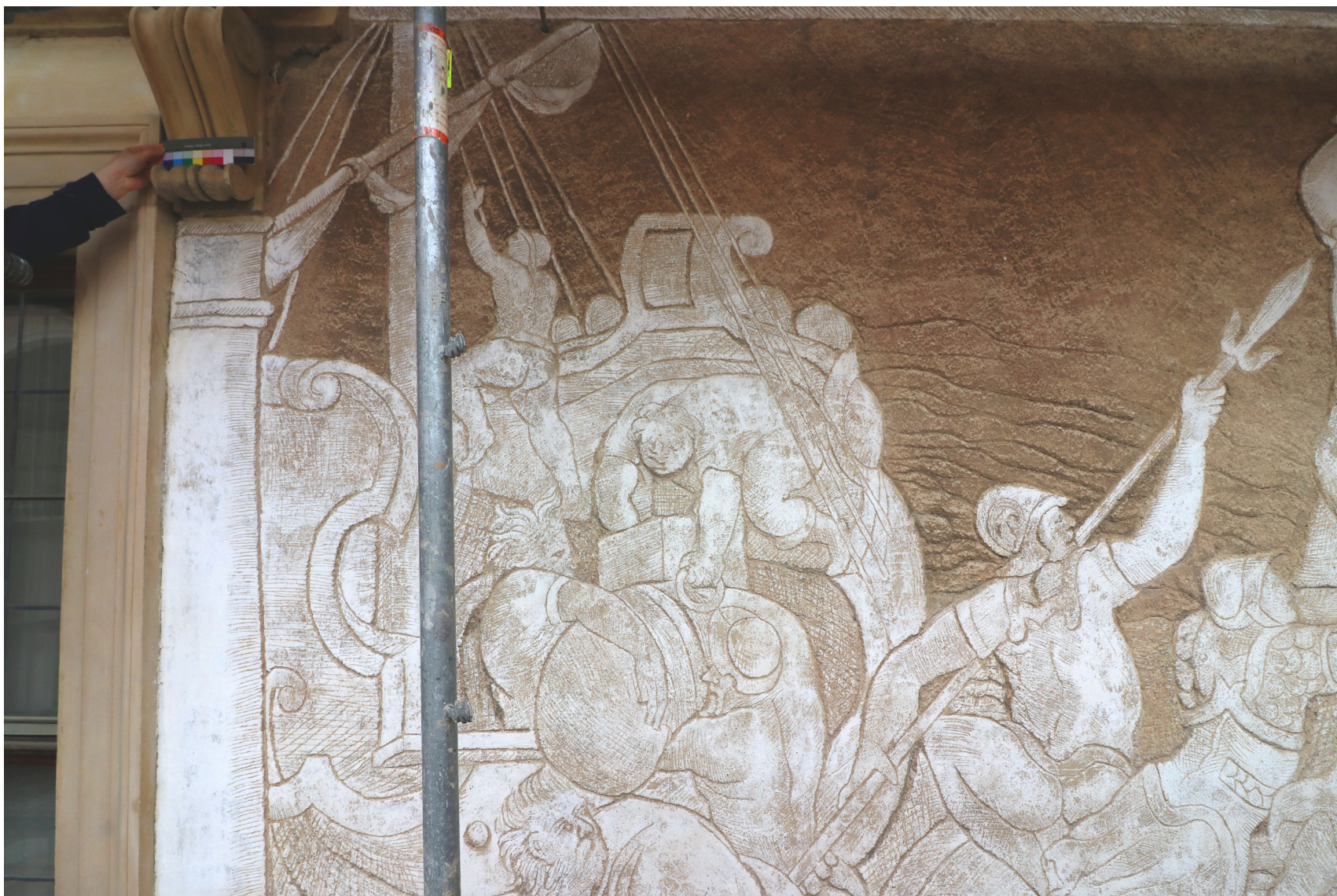
Obr. 31: Horní polovina restaurovaného úseku – Stav po čištění.
