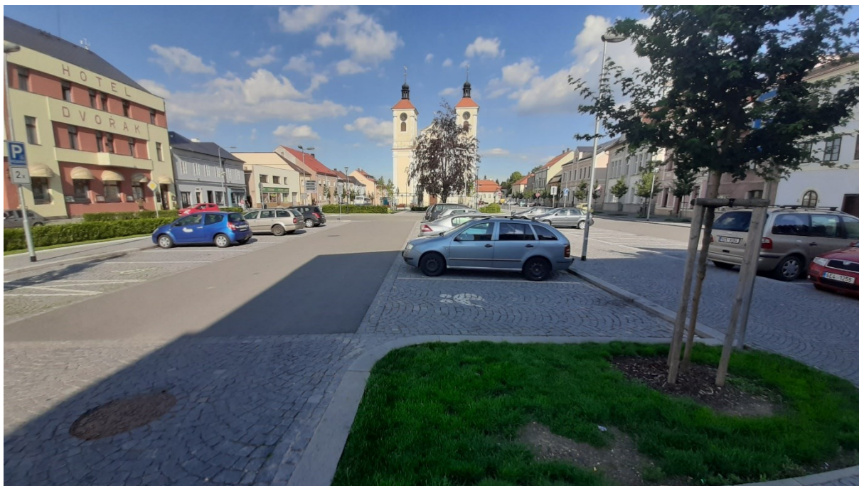
Obr. 32: Navazující zrekonstruované parkoviště před jednotou.
