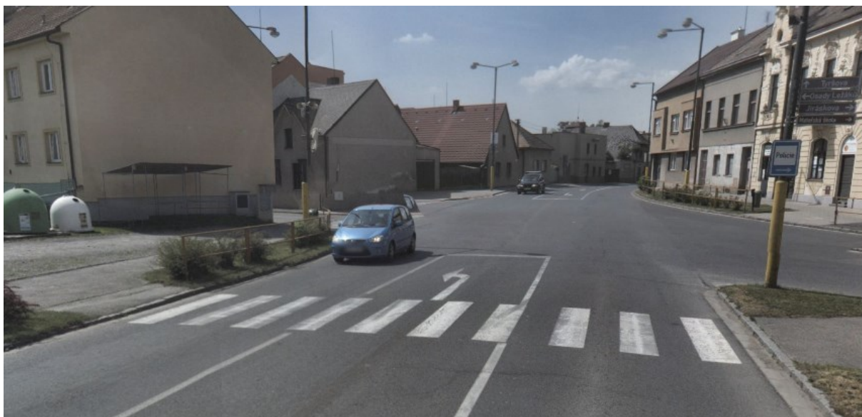
Obr. 7: Délkově nevyhovující současný přechod pro chodce paprsku C délky 10,5 m.
