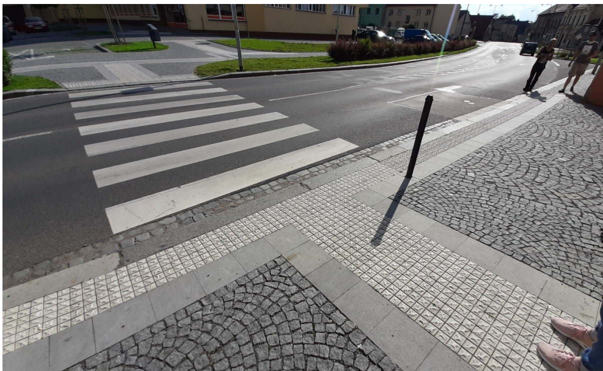
Obr. 24: Navazující zrekonstruovaný přechod východního paprsku.
