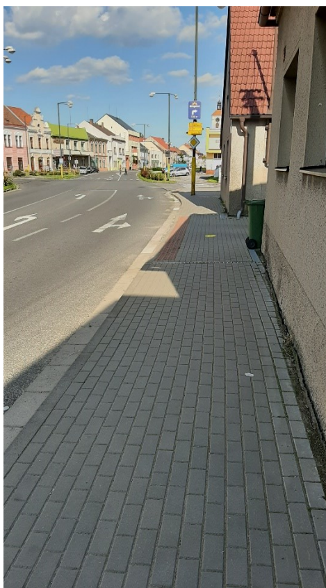
Obr. 27: Chodníková plocha z parketové betonové dlažby západního paprsku ve směru do centra, vzor pokládky 2.
