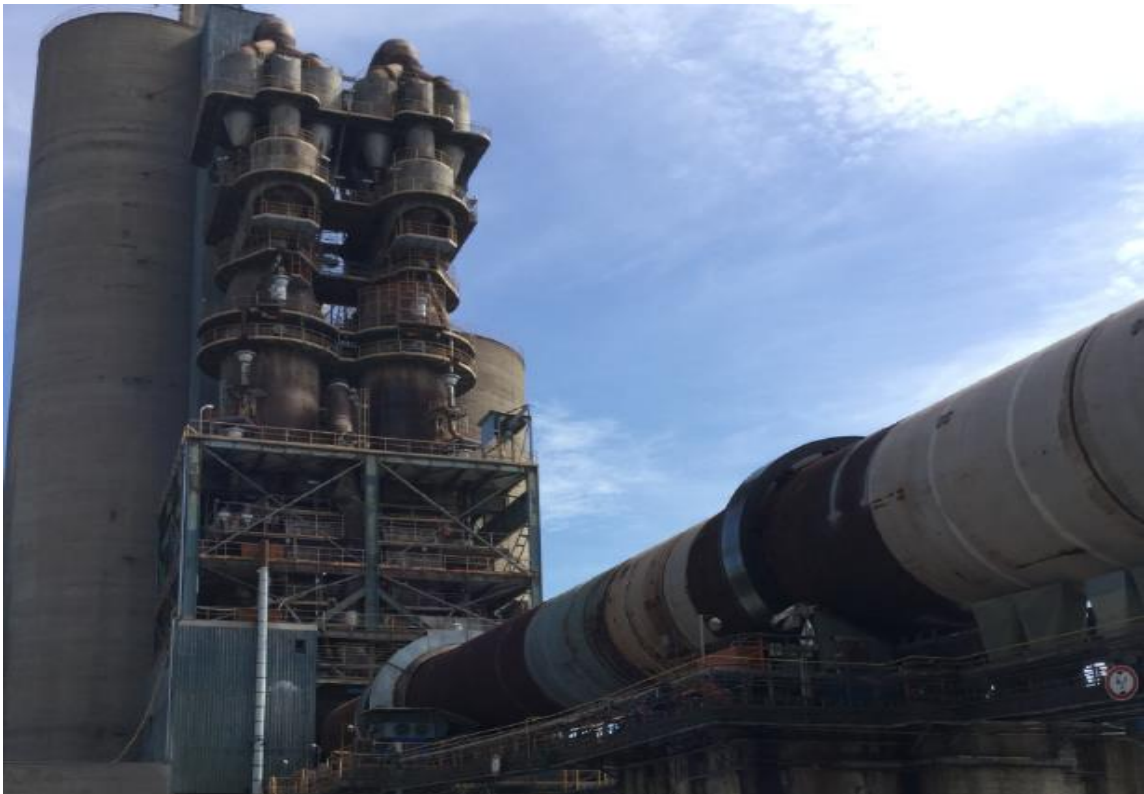
Obrázek 6: Rotační pec (90 m; Ø5,6 m) [9]
