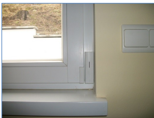
Obrázek 6: Příklad montáže magnetického kontaktu na okno
