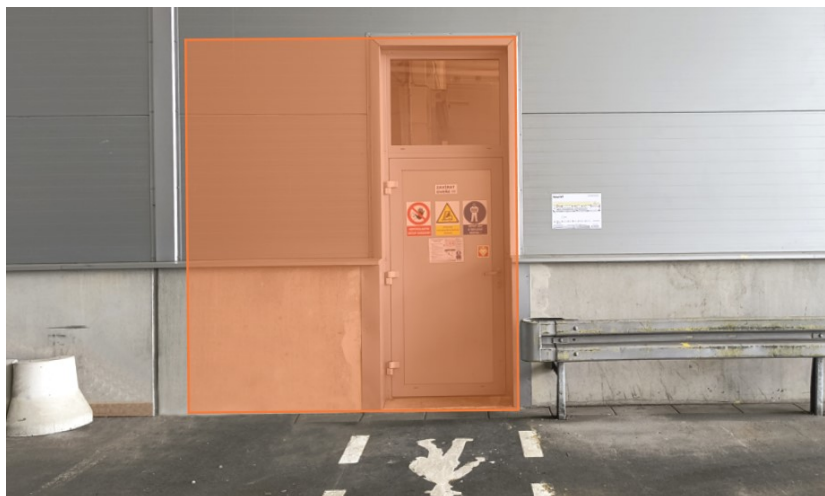
Obrázek 25 Úprava vstupních dveří do svařovny (autor, 2025)
