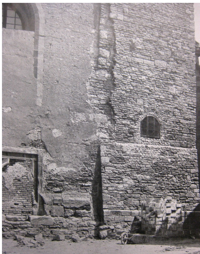
torzo románské věže kostela sv. Petra a Pavla v Mělníku před restaurací
