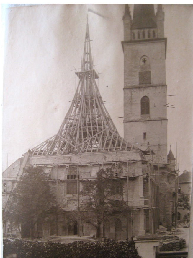
nový krov střechy kostela sv. Petra a Pavla v Čáslavi
