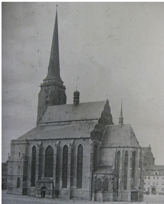
kostel sv. Bartoloměje v Plzni před restaurací
