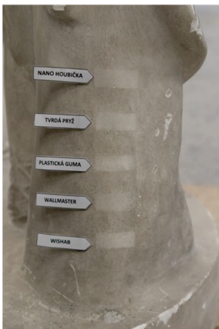
Obr. PR 13 Zkoušky suchého čištění
