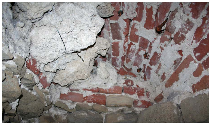
Obr. 118) Jean Baptiste Dieussard, Detail vnitřní výzdoby štoly, kde již v pravé části klenby chybí kamenný obklad. Stěny jsou z pískovcových kvádrů pojených maltou, klenba byla vynesena z cihel na dřevěném bednění, železné skoby byly umísťovány do spár ve zdivu a ty pak dále společně s měděnými dráty a maltou drží obložení kameny. Hornická grotta, sala terrena, AZ Kroměříž. 1686–1695.
