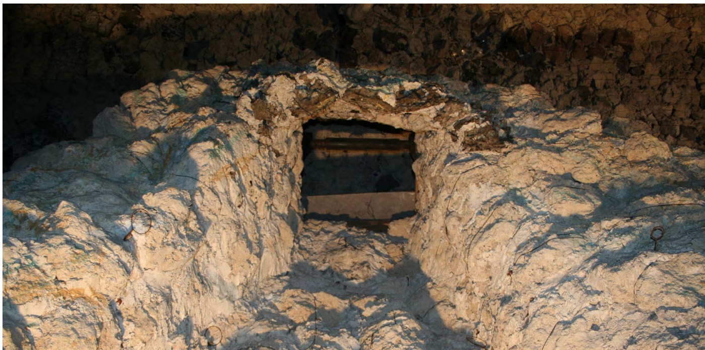
Obr. 136) Jean Baptiste Dieussard, Štola nad vchodem do grotty s umístěnými železnými drátěnými očky po stranách, sloužících k uchycení světla. Hornická grotta, sala terrena, AZ Kroměříž. 1686–1695.
