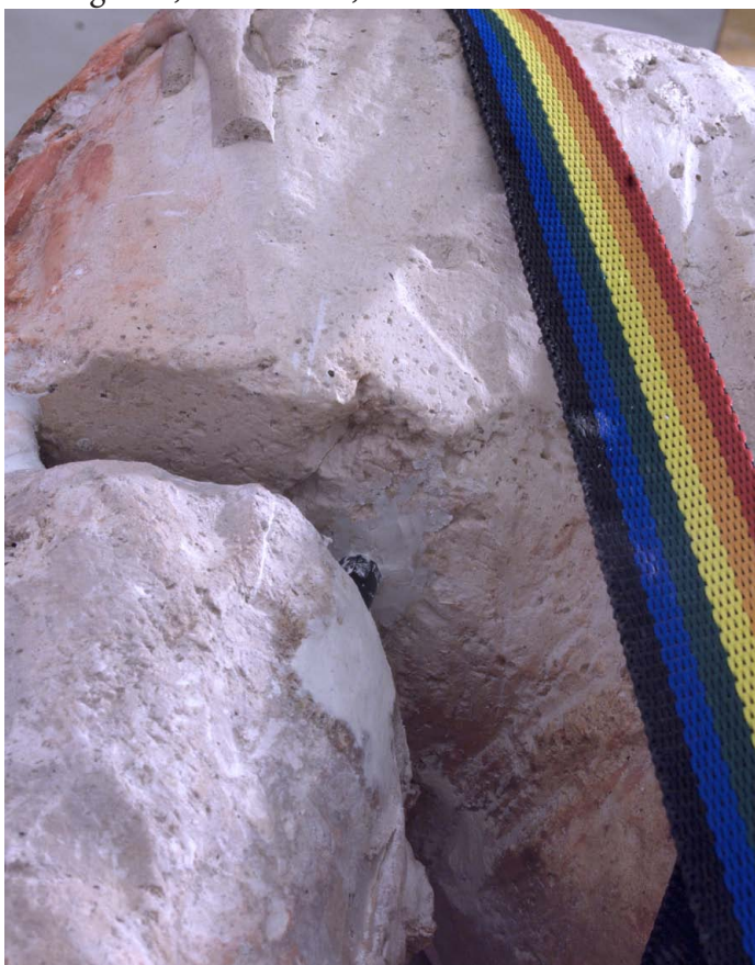
Obr. 175 a,b) Detail ramene po vytmelení dutiny vápenným tmelem. Detail ramene po vsazení čepu. Hornická grotta, sala terrena, AZ Kroměříž. 1686–1695.
