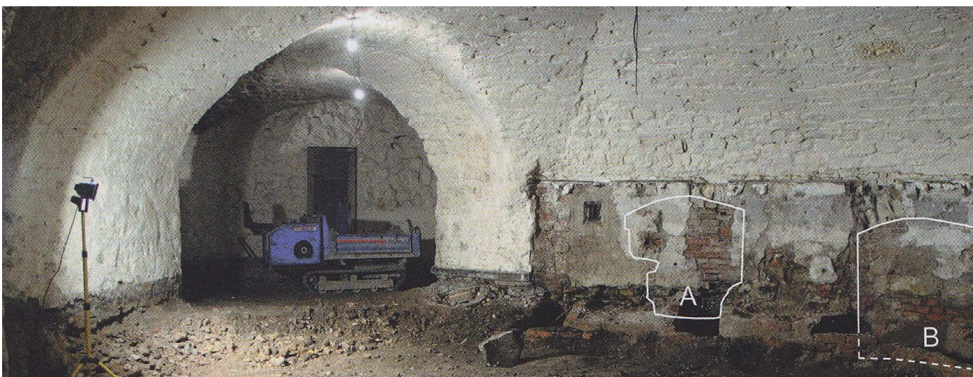
Obr. 39) Giovanni Battista Pieroni?, Velká grotta Valdštejnského paláce, stav v průběhu stavebních prací, detail původní podlahy grotty. Praha, Augustiniánský klášter, 20. léta 17. století. (Ibidem)
