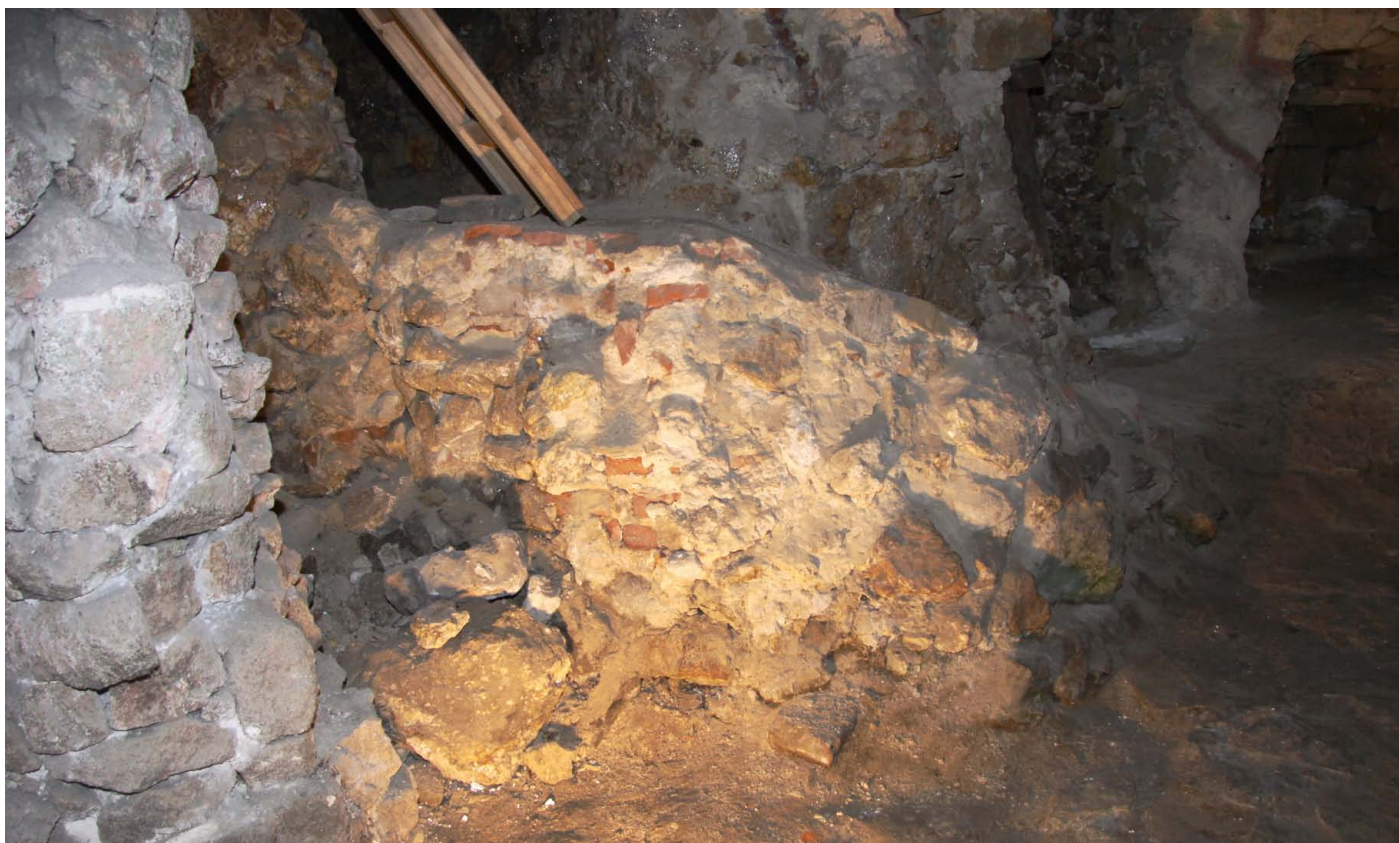
Obr. 149) Jean Baptiste Dieussard, Detail boku vyzděné stezky do štoly, která byla celá obložená kemeny, ale dnes je vidět jádrové zdivo. Hornická grotta, sala terrena, AZ Kroměříž. 1686–1695.
