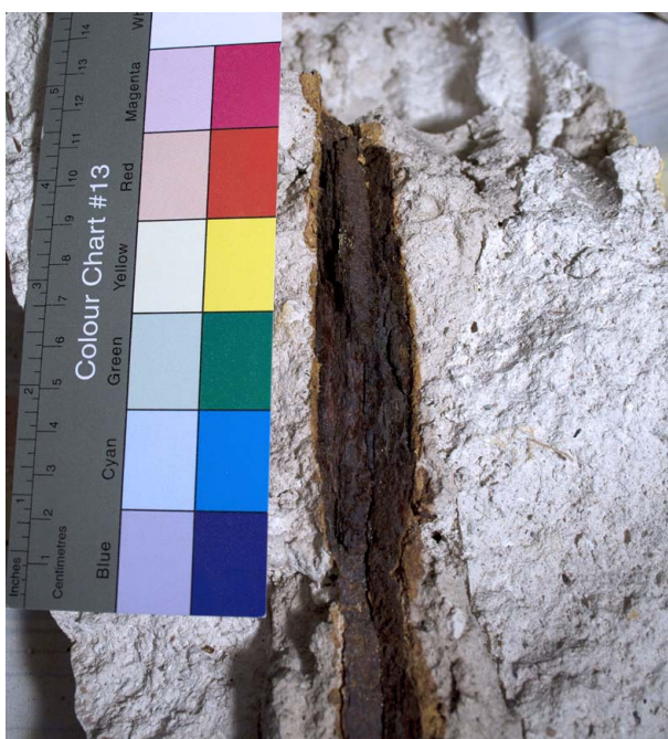
Obr. 171) Jean Baptiste Dieussard, Detail zdegradovaného železa, které zůstalo v lůžku přichycené ke štuku. Hornická grotta, sala terrena, AZ Kroměříž. 1686–1695.
