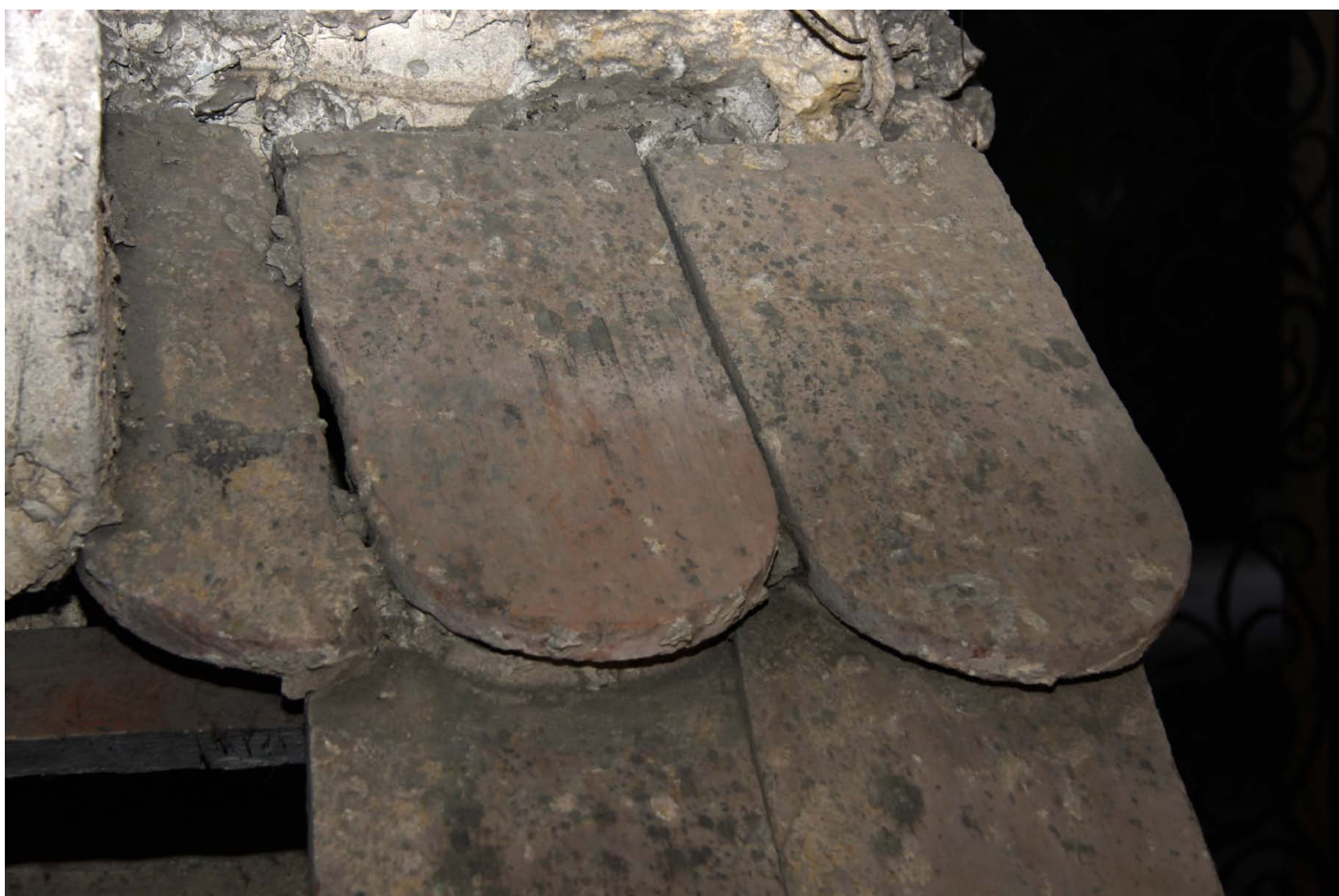
Obr. 142) Jean Baptiste Dieussard, Detail pravděpodobně původních keramických tašek tamtéž. Hornická grotta, sala terrena, AZ Kroměříž. 1686–1695.
