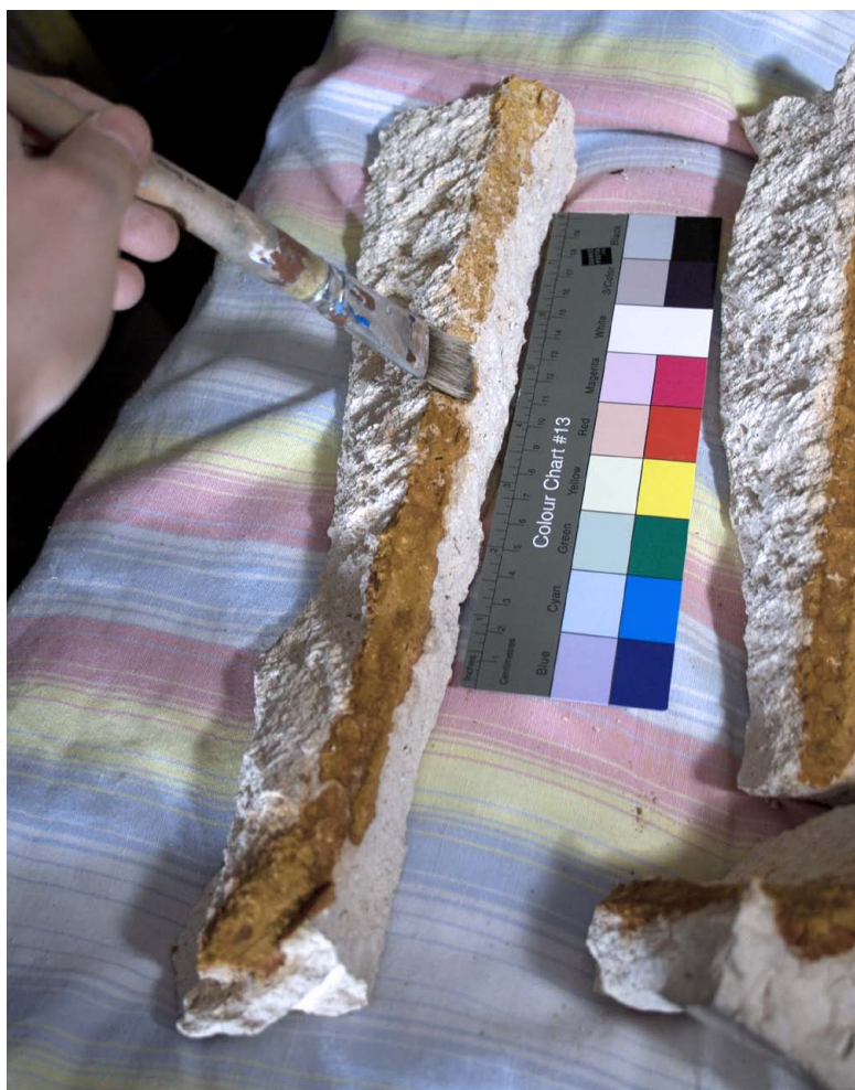
Obr. 170) Impregnace očištěných lůžek po čepech od rzi inhibitorem koroze. Hornická grotta, sala terrena, AZ Kroměříž. 1686–1695.
