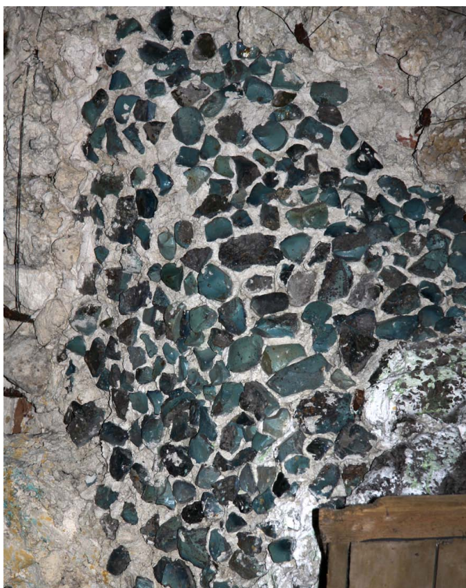
Obr. 131) Jean Baptiste Dieussard, Ukázka plochy na vybíhající klenbě, kde zhruba na 6m 2 plochy vyskládali pouze skelnou strusku vkládanou do ještě řídké malty. Hornická grotta, sala terrena, AZ Kroměříž. 1686–1695.
