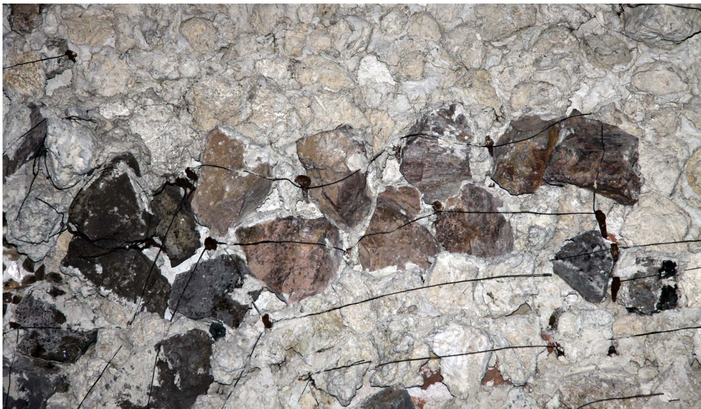
Obr. 133) Jean Baptiste Dieussard, Ukázka upevnění kamenů ke klenbě grotty po jednotlivých větších kusech i po rádcích několika menších kusů. Hornická grotta, sala terrena, AZ Kroměříž. 1686–1695.
