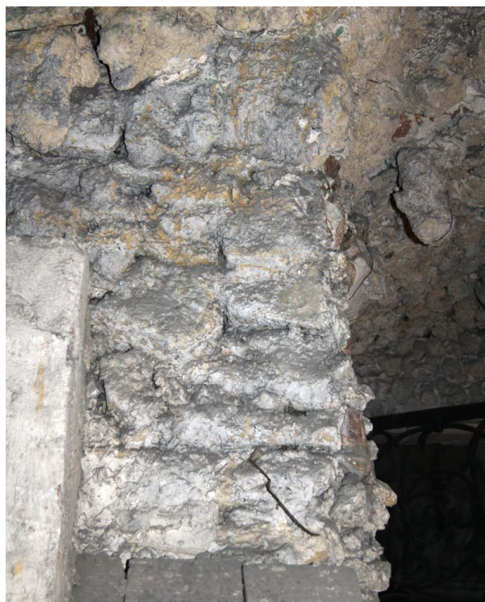
Obr. 132) Jean Baptiste Dieussard, Ukázka plošně nanesené pravděpodobně pozdější vysprávky, která je vápennocementová a obsahuje jako plnivo štěrk. Hornická grotta, sala terrena, AZ Kroměříž. 1686–1695.
