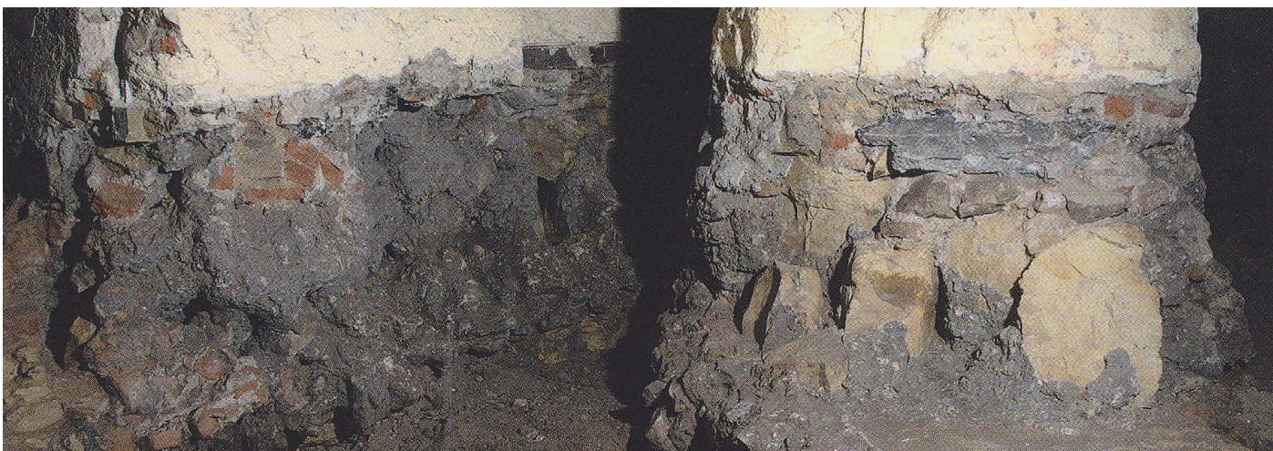
Obr. 40) Giovanni Battista Pieroni?, Velká grotta Valdštejnského paláce, stav v průběhu stavebních prací, detail dochovaného kamenného obkladu u pat stěn. Praha, Augustiniánský klášter, 20. léta 17. století. (Ibidem)
