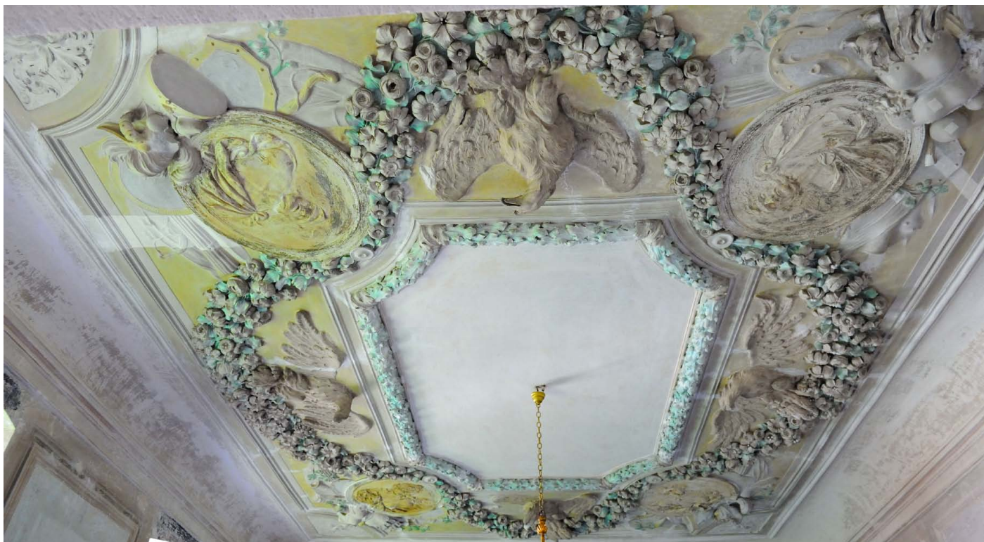
Obr. 74) Baldassare Fontana a jeho dílna, Výzdoba klenby divadelního sálu, nepůvodní povrchové úpravy, původně pravděpodobně bílý štuk se zlacenými medailony. Zámek Uherčice, 1697.
