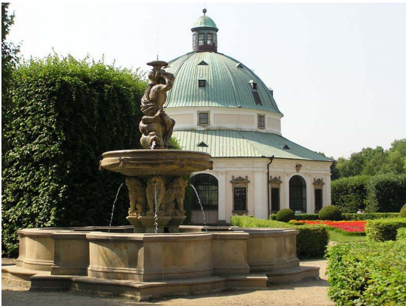
Obr. 50) Giovanni Pietro Tencalla, Rotunda v Květné zahradě, Kroměříž, pohled od Lví fontány. 1666–1668
