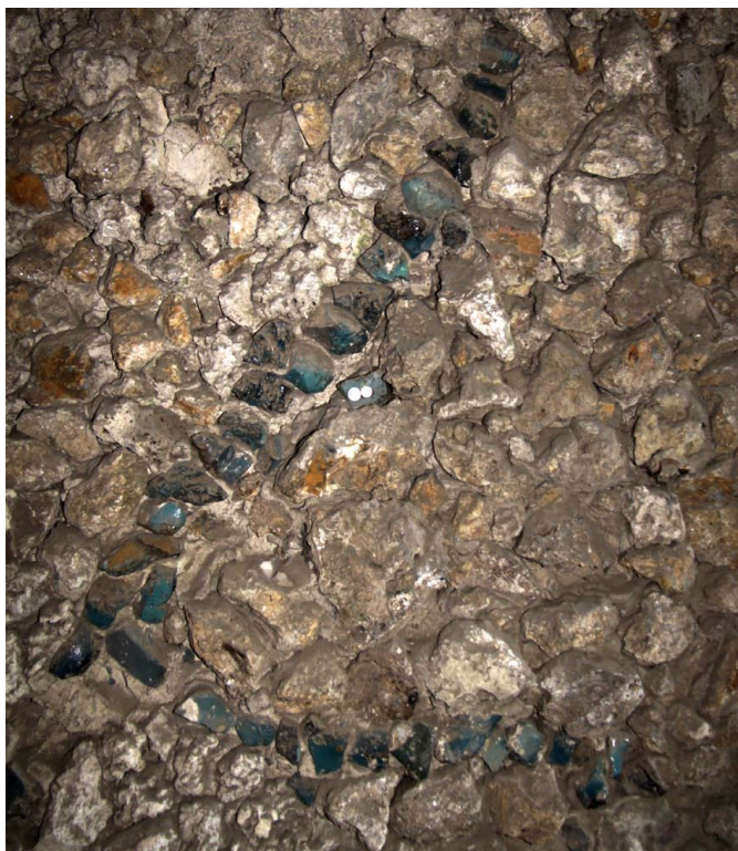
Obr. 143) Jean Baptiste Dieussard, Žíla zelené skleněné strusky má napodobit pravděpodobně malachyt. Hornická grotta, sala terrena, AZ Kroměříž. 1686–1695.
