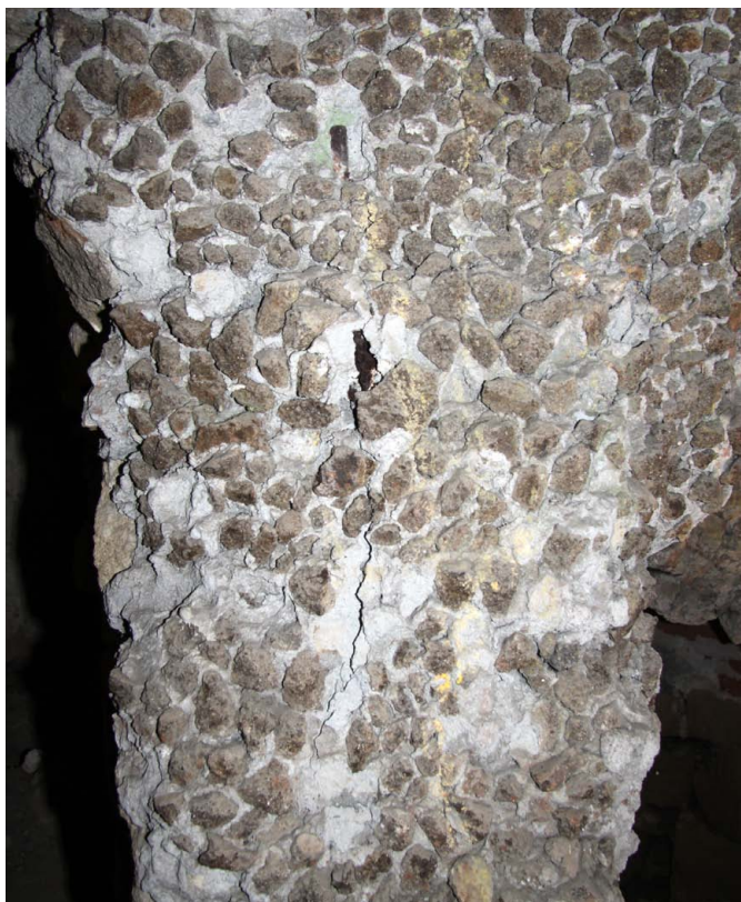
Obr. 147) Jean Baptiste Dieussard, Detail vyčnívajícího skaliska přidržovaného železným táhlem ke zdi za ním. V minulosti pravděpodobně došlo k plošnému druhotnému omítnutí a vtisknutí drobnějších úlomků horniny přes původní materiál umělého skaliska. Hornická grotta, sala terrena, AZ Kroměříž. 1686–1695.
