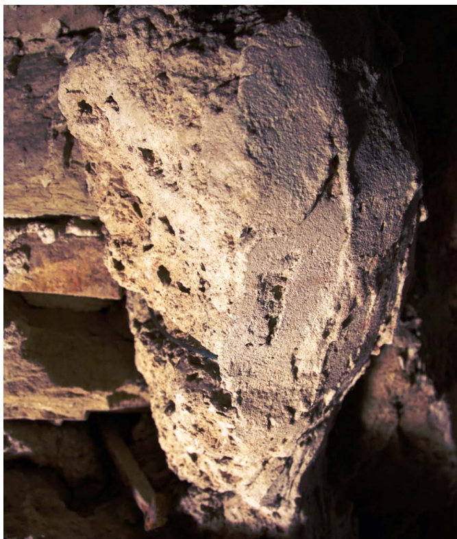
Obr. 150) Jean Baptiste Dieussard, Detail pórovitého kamene, který je z pravé strany otočené do grotty omítnut „francouzským“ štukem. Hornická grotta, sala terrena, AZ Kroměříž. 1686–1695.
