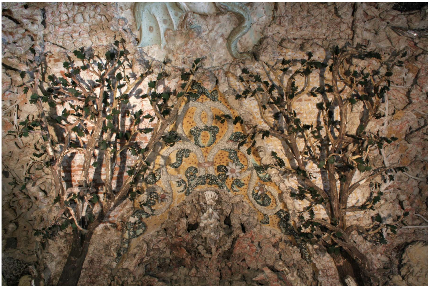
Obr. 60) Jean Baptista Dieussard, Detail výzdoby klenby Apollónovy grotty se štukovými větvemi dubu obalených skutečnou kůrou stromu a listím z plechu. Sala terrena Arcibiskupského zámku, Kroměříž, 1688–1692.
