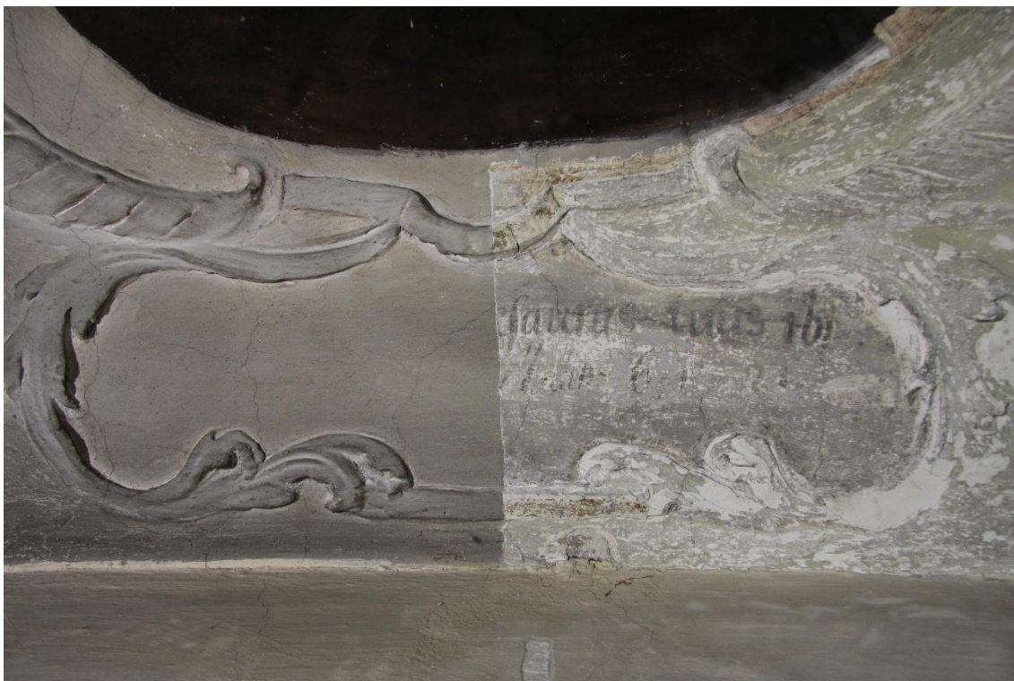
Obr. č. 49 Průběh mechanického čištění. Čištění bylo provedeno pomocí skalpelu.
