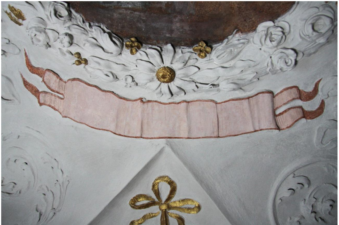
Obr. č. 28 Stav po rekonstrukci barevné vrstvy nápisové pásky.
