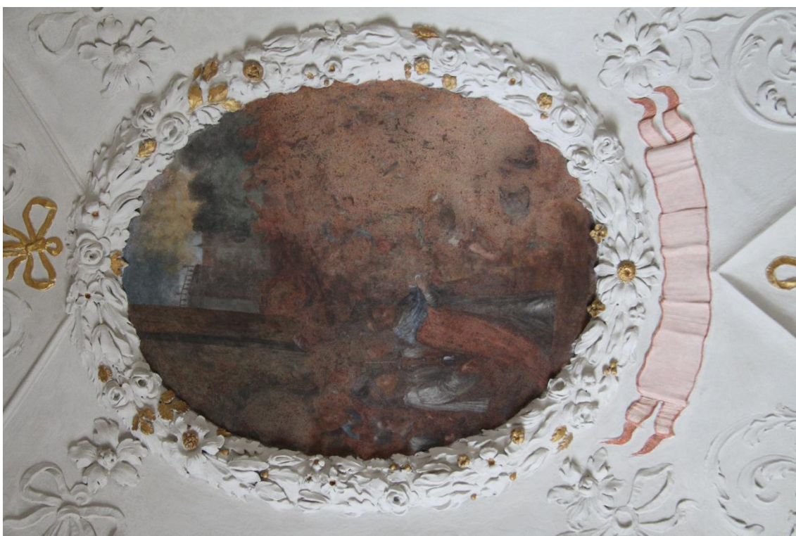
Obr. č. 21 Stav po restaurování, rekonstrukci první nejstarší vrstvy povrchové úpravy štukové výzdoby a barevné štukové nápisové pásy.
