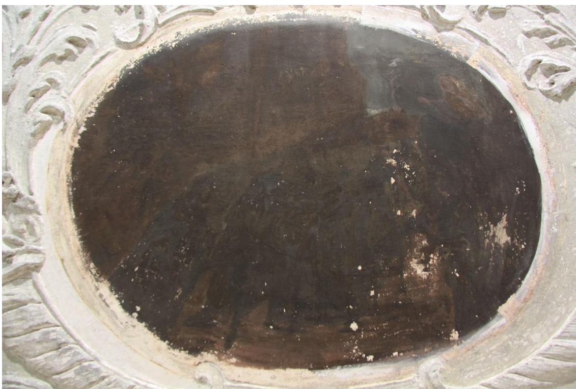
Obr. č. 37 Stav po dočištění pomocí čistící latexové houby Akapad . Okolí malby, které bylo překryto vápenným nátěrem odstraněno pomocí skalpelu.
