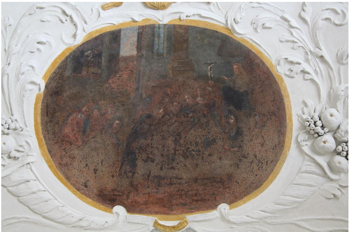
Obr. č. 45 Stav po restaurování. Zlacené partie, včetně štukových prvků byly retušovány slídovými pigmenty, pojenými v arabské gumě.
