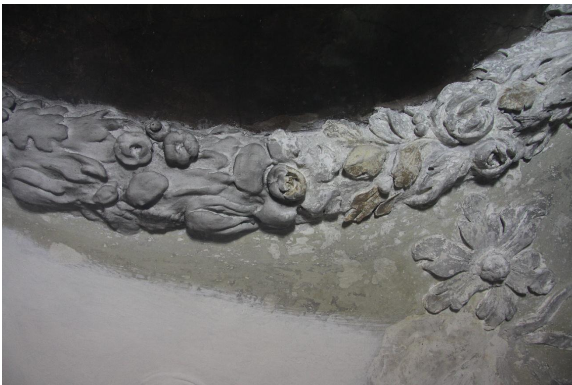
Obr. č. 24 Detail štukového věnce lemujícího centrální výjev. Levá část malby byla přetřena silným nátěrem, který deformoval modelaci štku, zatímco pravá část štku je očištěna mechanicky. Můžeme pozorovat detailnější modelaci štku a odhalující se pozlacené štukové prvky.
