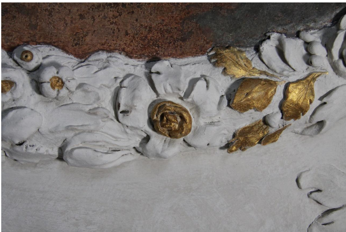
Obr. č. 25 Detail štukového věnce lemujícího centrální výjev. Zlacené partie, včetně štukových prvků byly retušovány slídovými pigmenty, pojenými v arabské gumě. Stav po restaurování.
