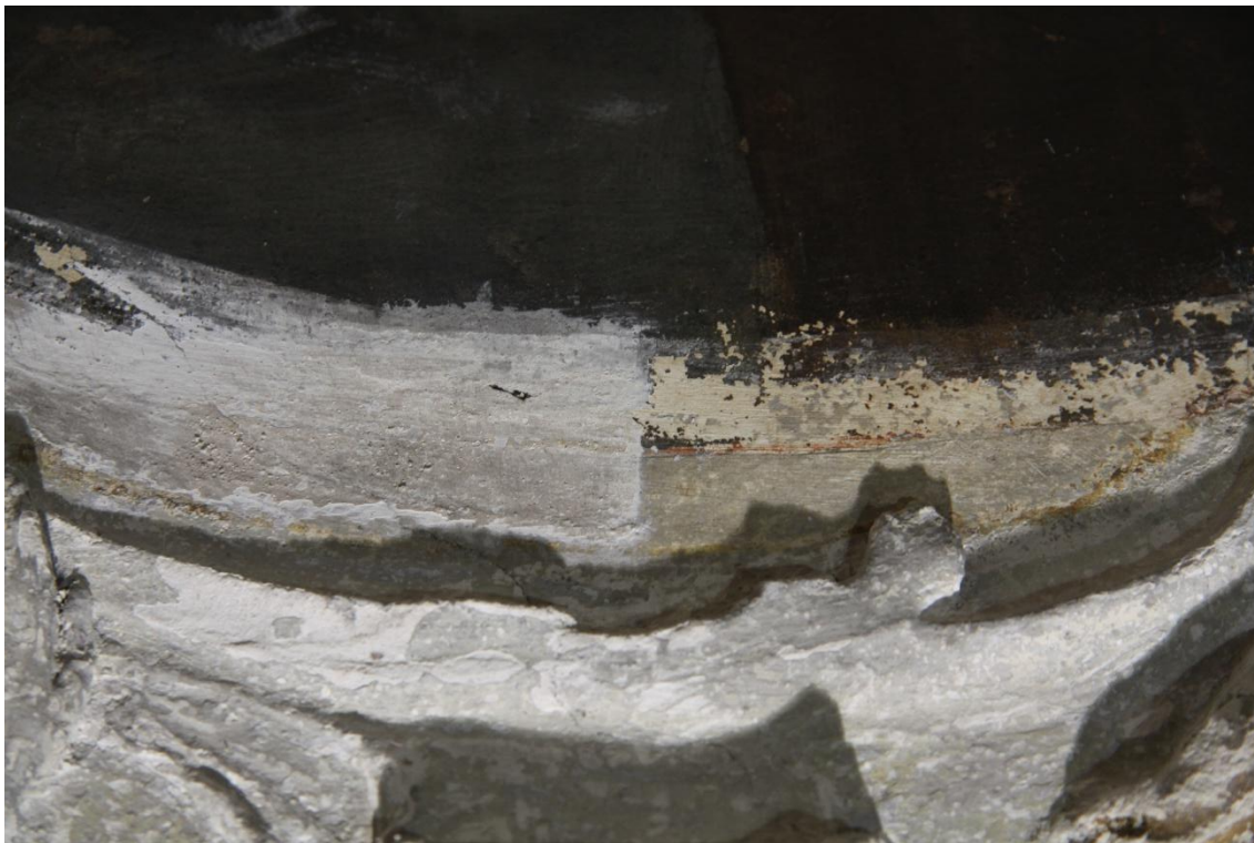
Obr. č. 36 Zkouška čištění okolí malby, které bylo překryto vápenným nátěrem pomocí skalpelu. Můžeme pozorovat zbytky zlacení v orámování malby.
