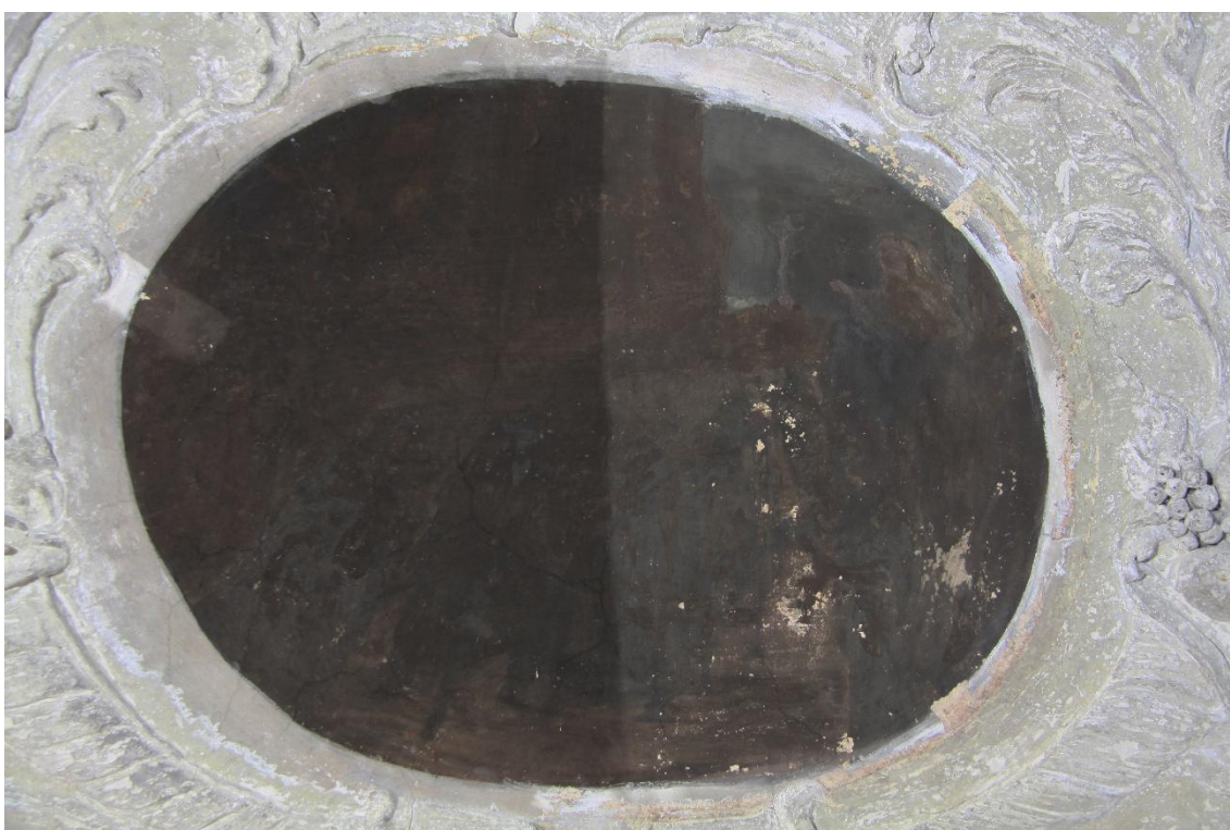
Obr. č. 35 Průběh mechanického čištění. Čištění bylo provedeno pomocí čistící latexové houby Akapad .
