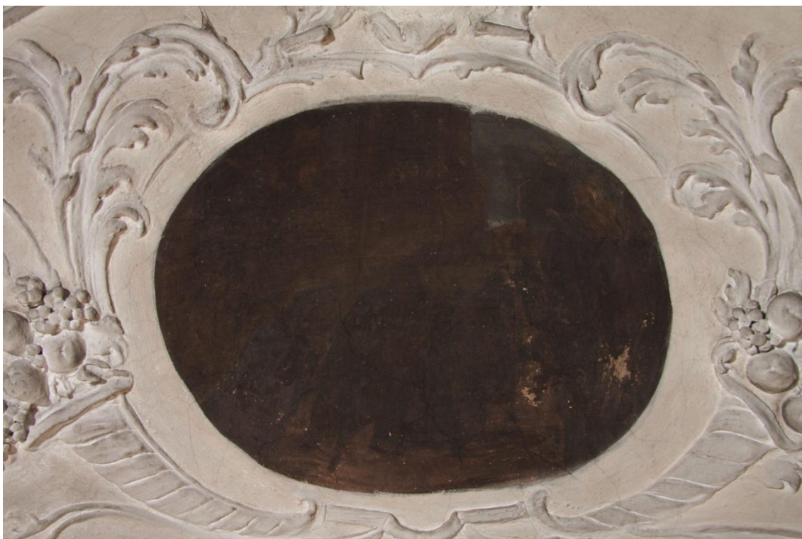
Obr. č. 30 Malba je pokryta pavučinami, vrstvou prachového deponátu (sazí). Jsou patrné praskliny a části opadané barevné vrstvy. Stav před restaurováním.
