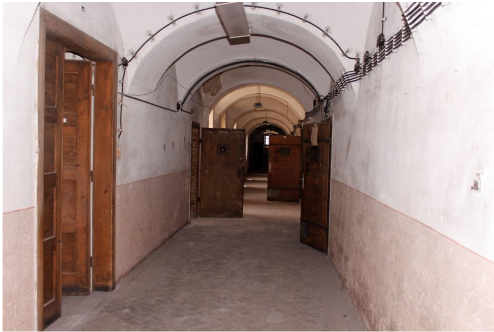
Věžeňská chodba (archiv autorky)
