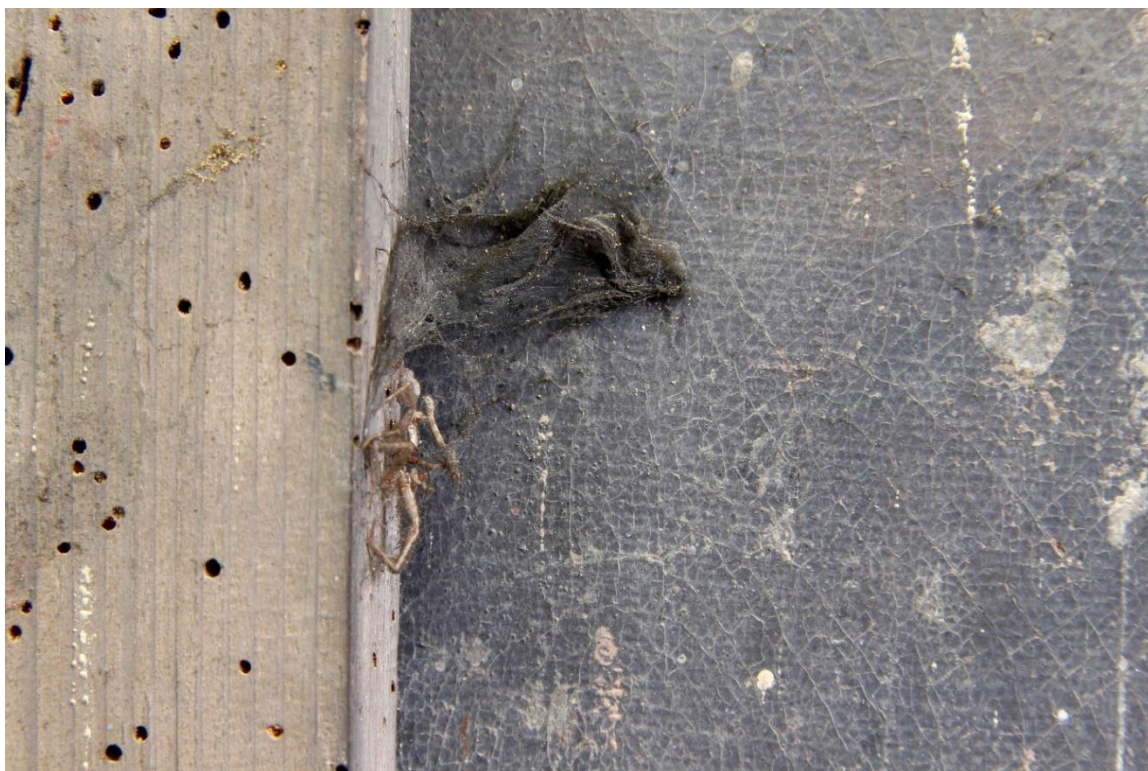
Obr. 64: Stav před restaurováním, líc, detail poškození, znečištění prachovým depozitem včetně uhynulého hmyzu.
