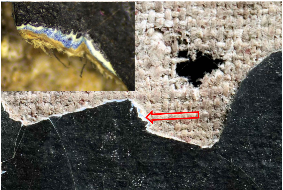
Obr. 18: Stav před restaurováním, líc, detail poškození, trhlina v barokní textilní podložce, pod svrchní tmavou malbou prostupuje spodní světle modrá vrstva (ultramarín).
