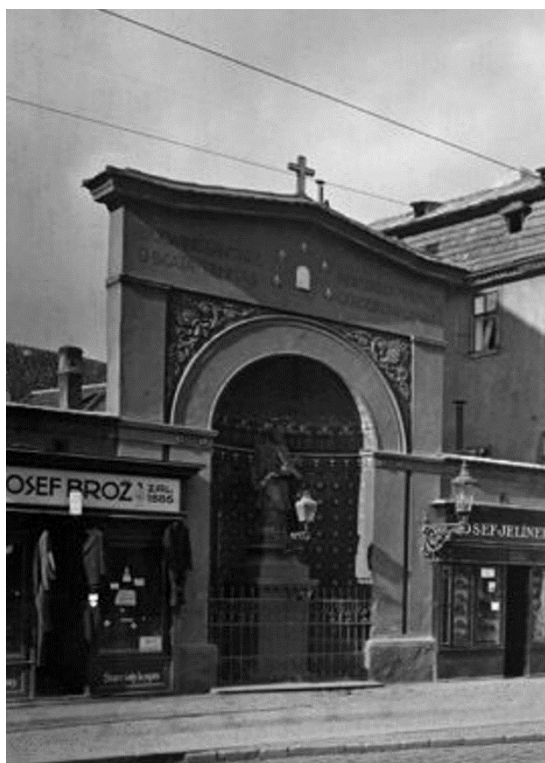
obr. 4. Výklenková kaple domu U Šálků
