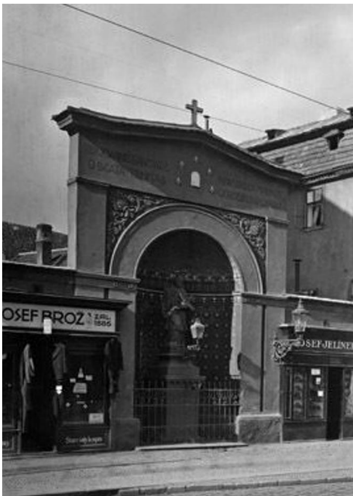
obr. 78. Původní umístění sochy ve výklenkové kapli na Karlově náměstí před demolicí budovy a fotografie po demolici s novou výstavbou. Dostupné z: http://www.promenyprahy.cz/karlovo-namesti-u-salku/
