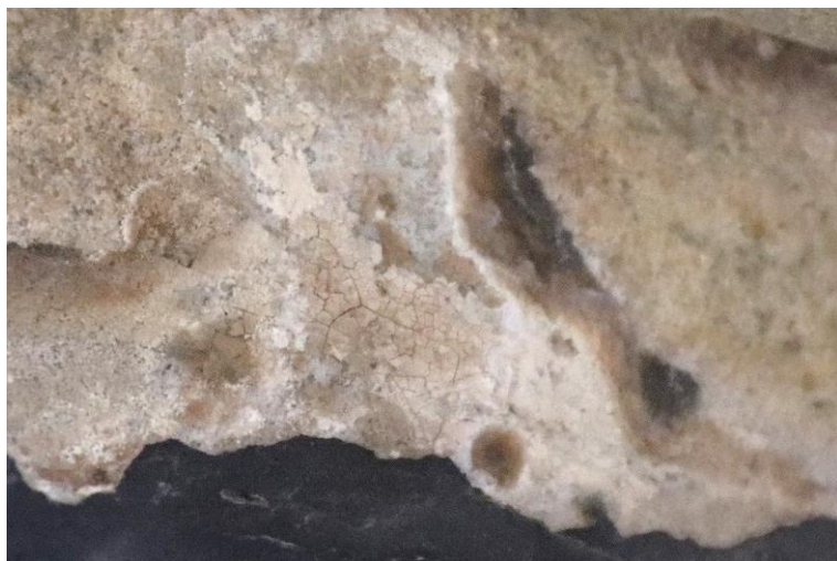
obr. 85. Fragment povrchové vrstvy rukávu
