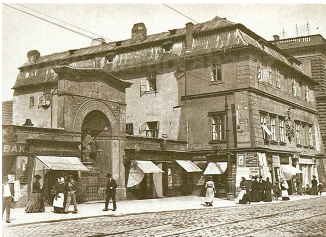
obr. 76. Původní umístění – výklenková kaple na Karlově náměstí
