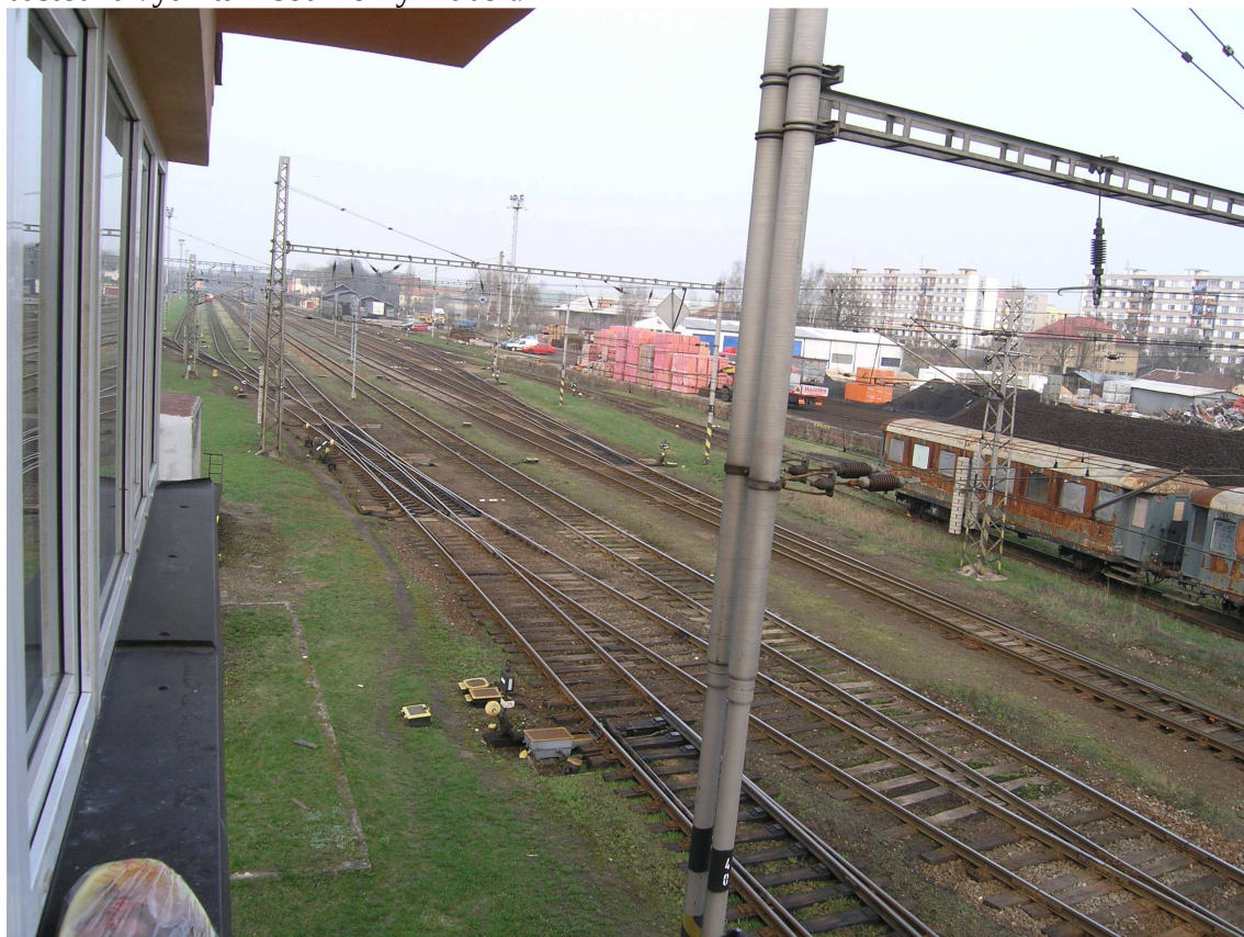
Snímek č. 24 – km 40,150 Pohled ze stavědla č. 2 na část královédvorského zhlaví, část v oblouku a část v přímé
