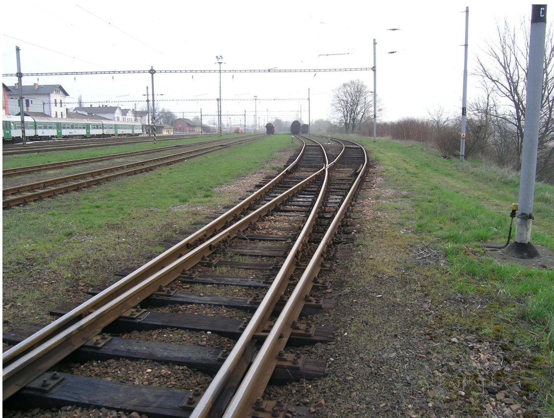
Snímek č. 13 – Zprava manipulační koleje č. 16 a č. 14, zvětšená osová vzdálenost 9,41 m, následují manipulační koleje č. 12 a č. 10 a zvětšená osová vzdálenost 9,95 m
