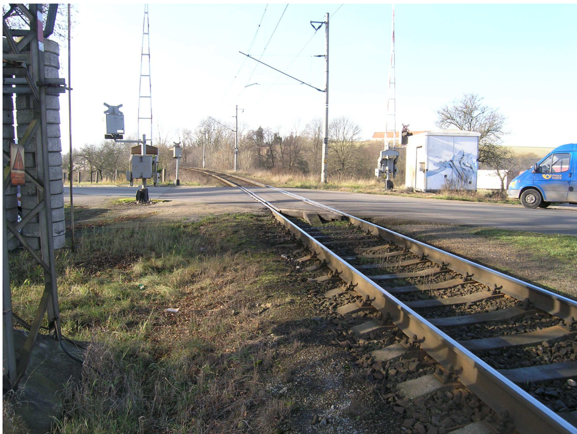
Snímek č. 3 – km 39,087 Železniční přejezd Hradecká ul., silnice I. třídy Jaroměř – Jezbiny, závislý s vjezdovým a odjezdovými návěstidly
