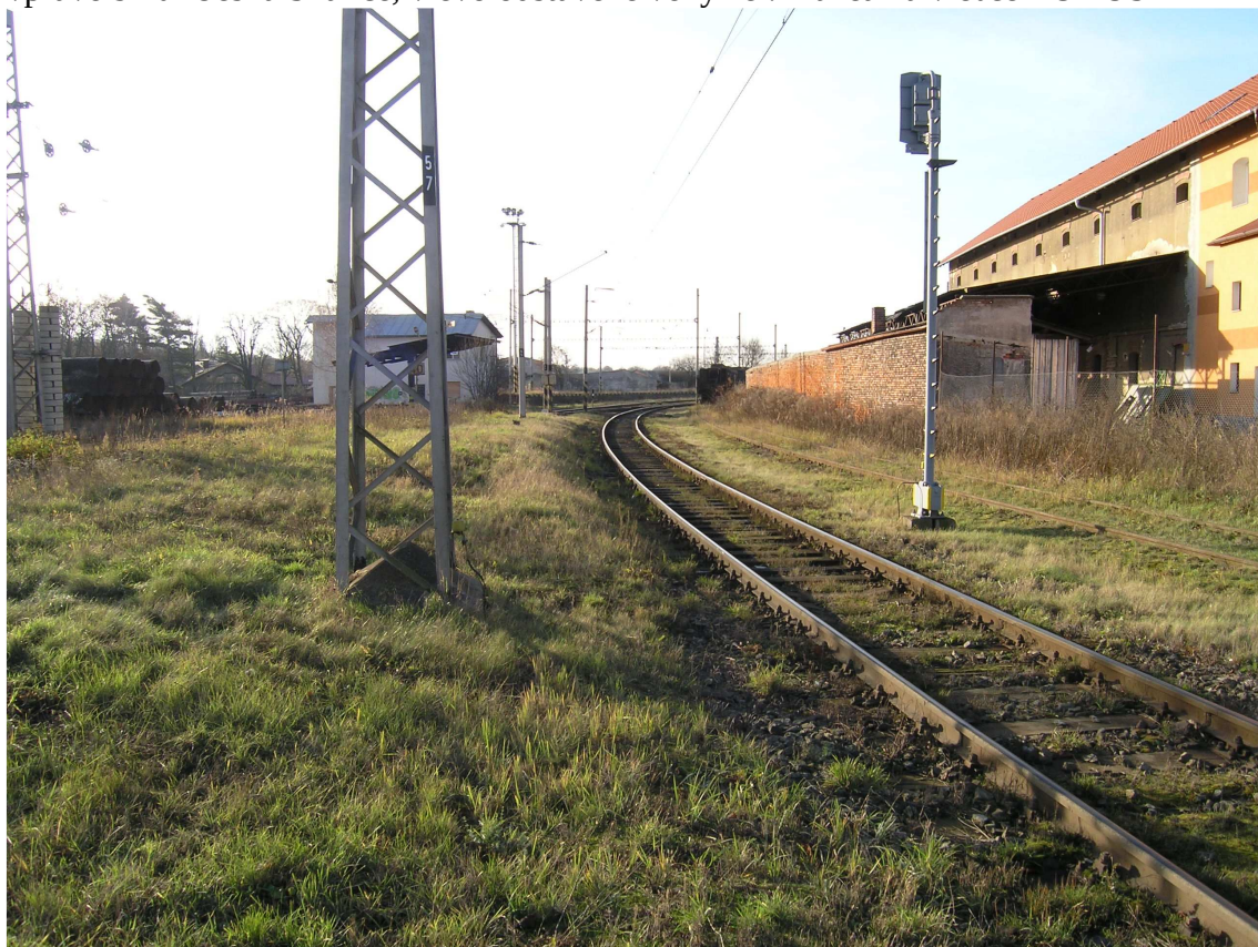
Snímek č. 28 – Pohled směrem do stanice na kolej od Dvora Králové, vpravo od ní návěstidlo Se33 pro posun a nepoužívaná část vlečky TONUS
