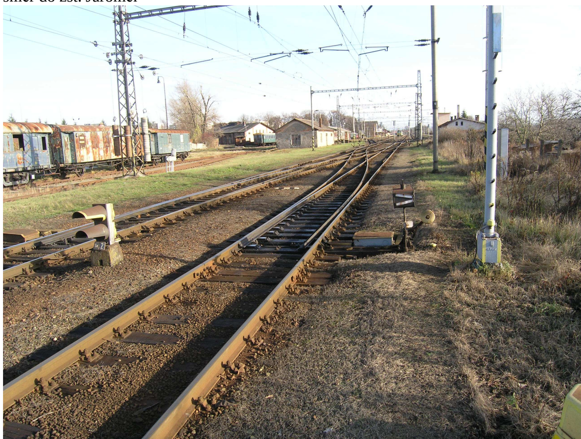
Snímek č. 6 – Dvojitá kolejová spojka v pohledu do žst. Jaroměř, přestavník výhybky č. 2
