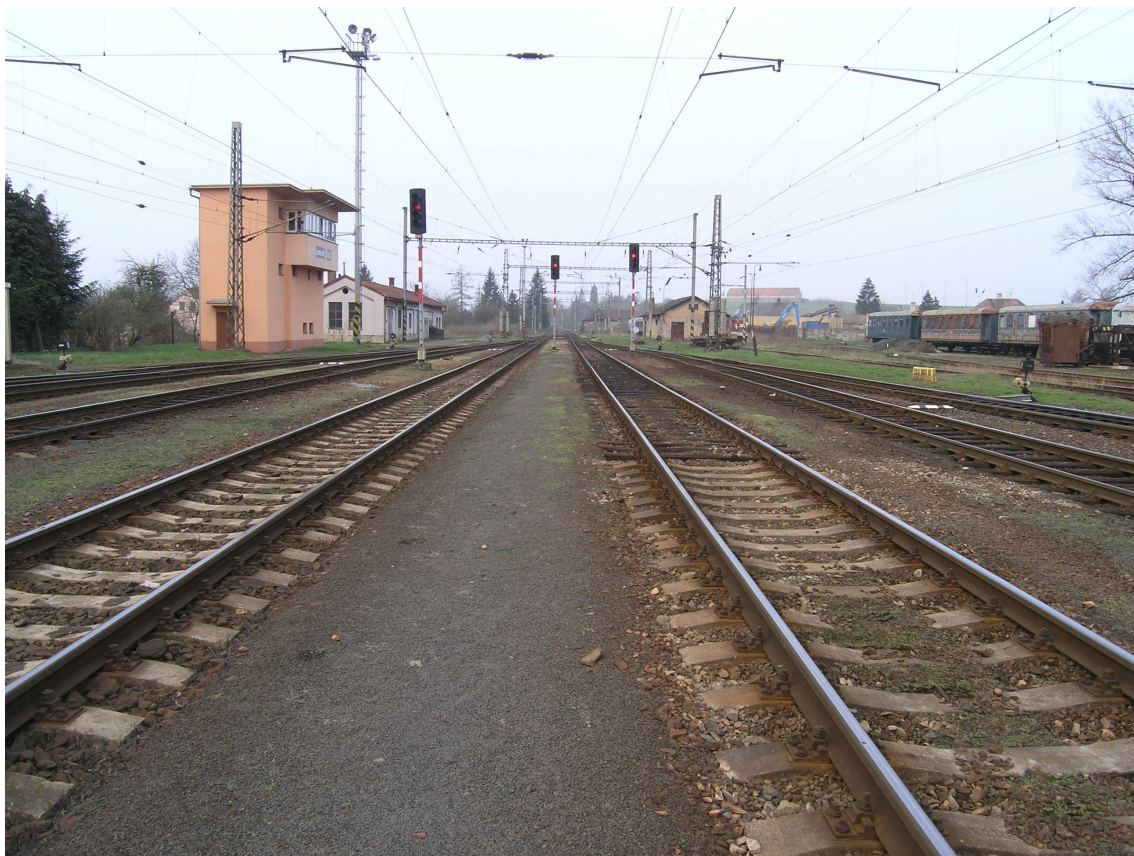
Snímek č. 11 – Umístění návěstidel ve smičickém zhlaví, vlevo stavědlo č. 1
