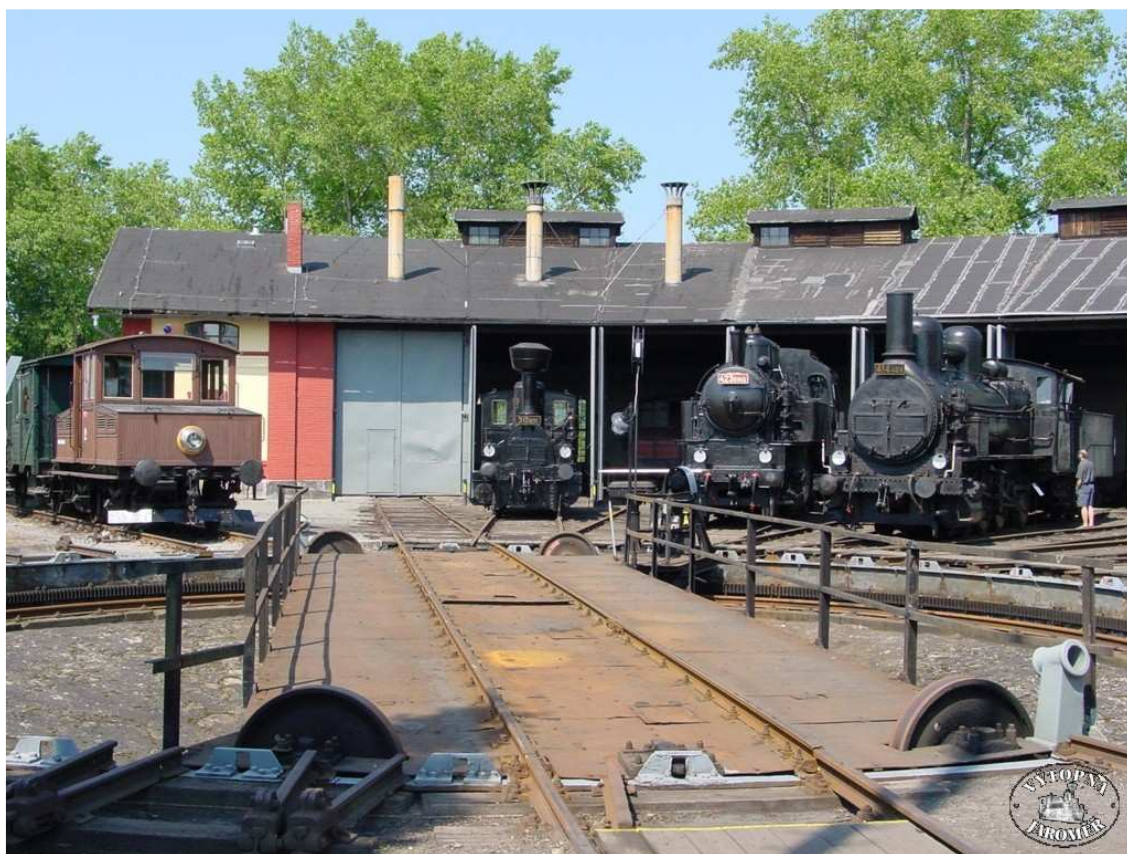
Snímek č. 9 – Budova rotundy výtopny parních lokomotiv s točnou v prostorách muzea (zdroj: http://www.spolecnost-zeleznicni.cz/ )
