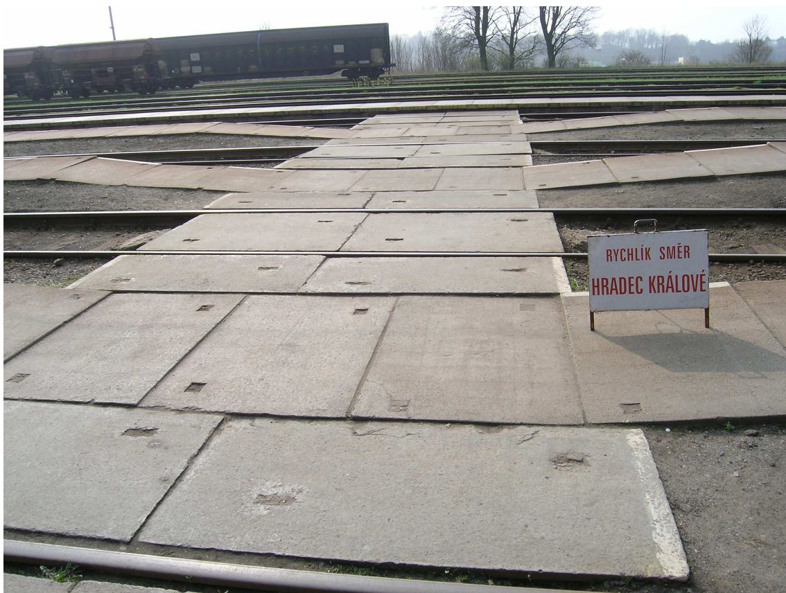
Snímek č. 17 – Úrovňový přechod pro cestující před výpravní budovou tvořený nástupištními deskami
