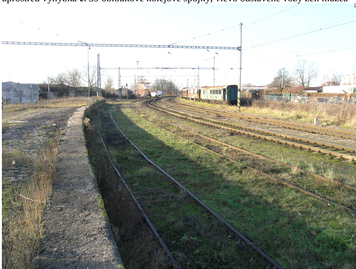
Snímek č. 26 – Pohled z boční rampy u koleje č. 20
