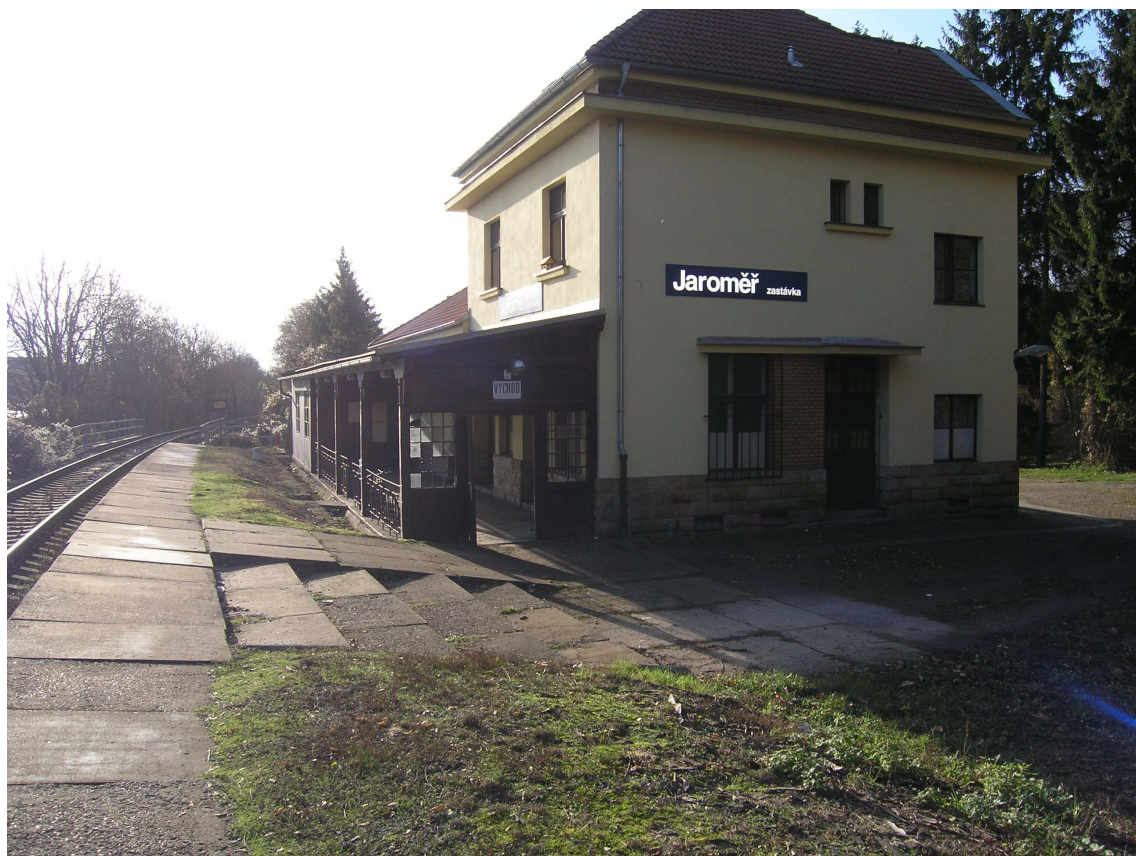
Snímek č. 37 – km 41,904 Budova Jaroměř zastávka
