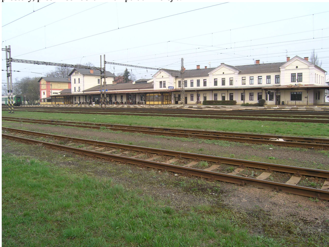
Snímek č. 20 – Pohled na kompletní výpravní budovu přes kolejiště
