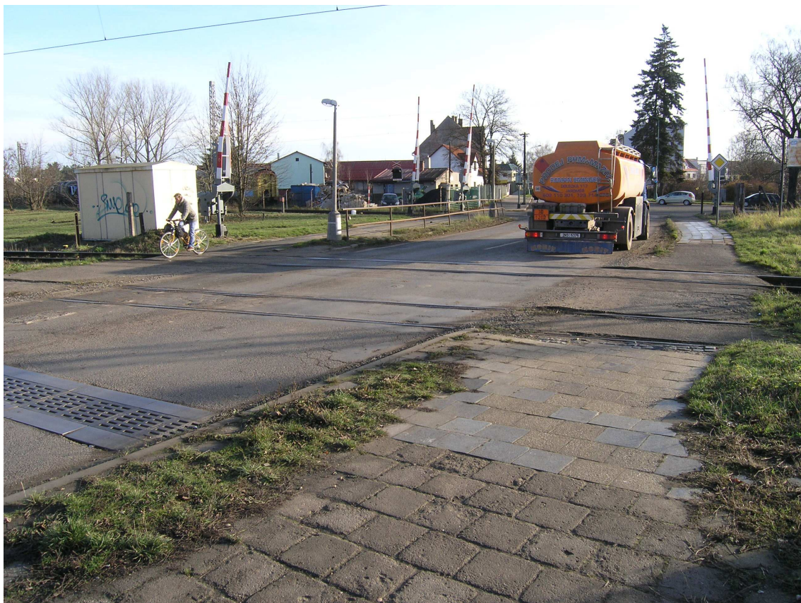
Snímek č. 29 - km 40,463 resp. km 0,283 Dva železniční přejezdy v ul. 5. května, silnice II. třídy Jaroměř – Josefov, závislé s vjezdovými a odjezdovými návěstidly
