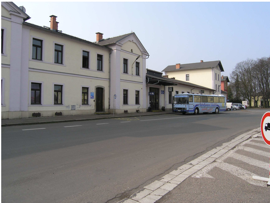
Snímek č. 31 – Pohled na výpravní budovu z prostoru přednádraží
