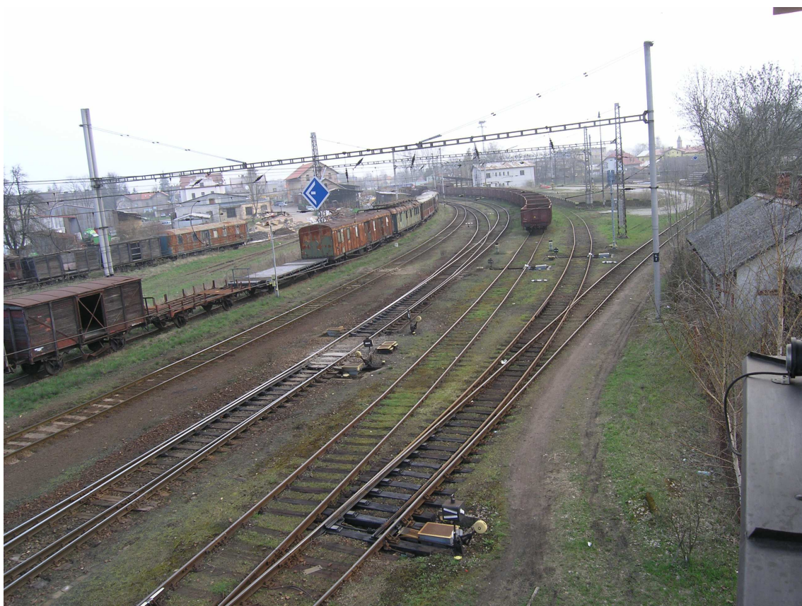
Snímek č. 25 – km 40,150 Pohled ze stavědla č. 2 na část královédvorského zhlaví v oblouku, uprostřed výhybka č. 39 obloukové kolejové spojky, vlevo odstavené vozy žel. muzea
