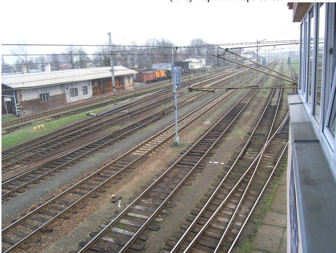
Snímek č. 10 – km 39,387 Pohled ze stavědla č. 1 na kolejiště žst. Jaroměř, vlevo sklad
