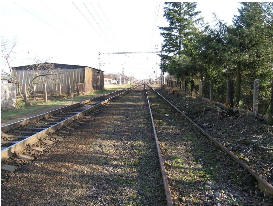
Snímek č. 5 – Vlevo hlavní staniční kolej č. 1, vpravo výtažná kolej pro posun č. 2a, směr do žst. Jaroměř
