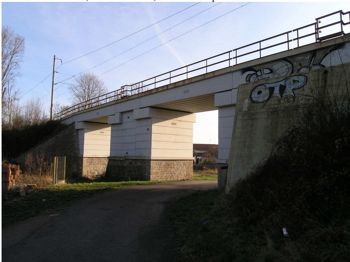
Snímek č. 2 – km 38,887 Most SO 06, přemostění délky 22,7 m, použito 93 prefabrikátů
