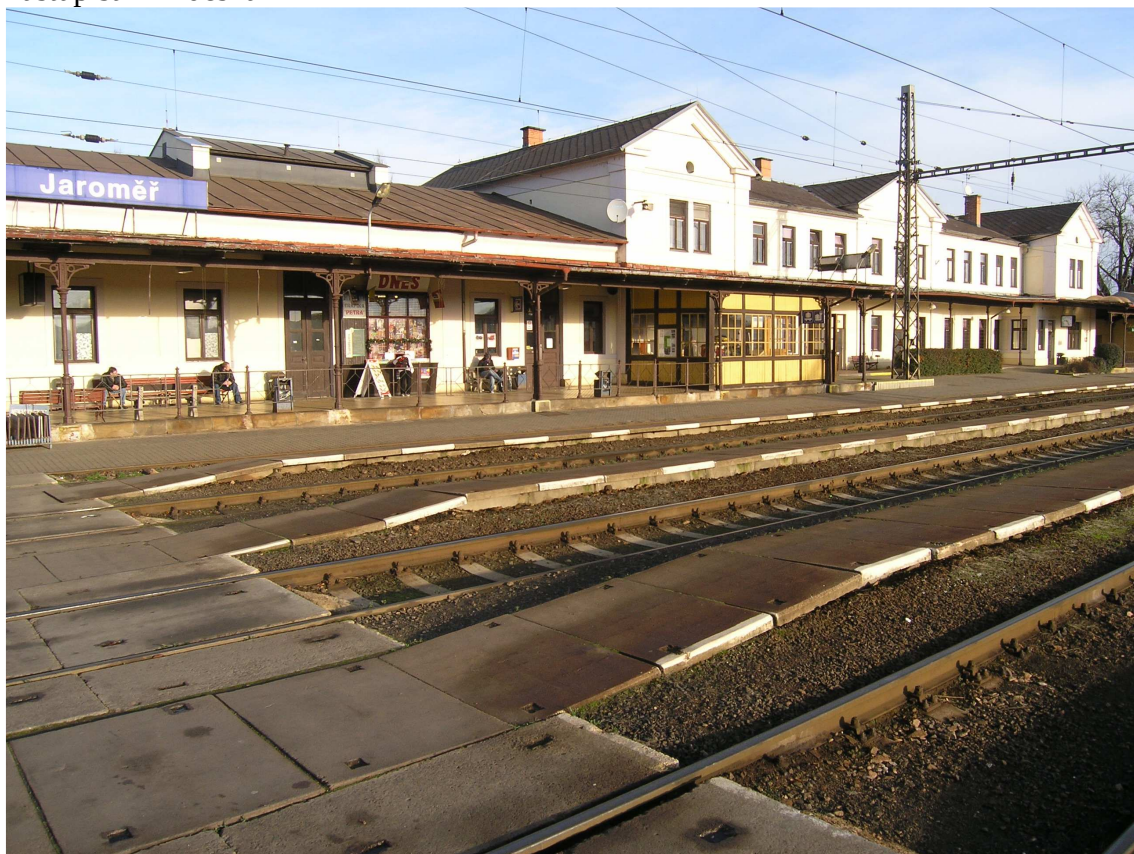
Snímek č. 18 – Dveře vpravo slouží jako hlavní vchod k nástupišťům a na zastřešené podloubí u výpravní budovy
