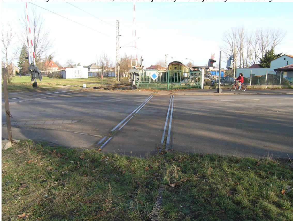
Snímek č. 30 – Vlečka PÁBL Uhlénné sklady v pokračování koleje č. 20 za železničním přejezdem v km 0,283
