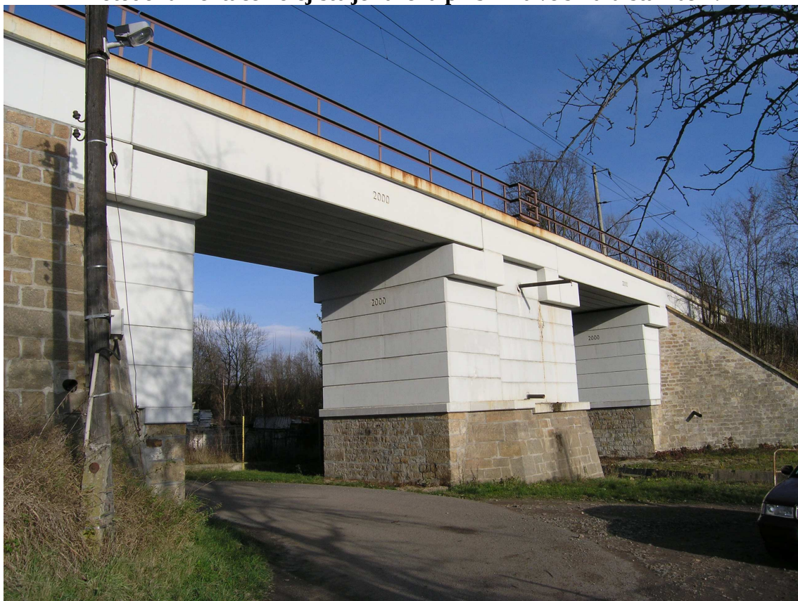
Snímek č. 1 – km 38,887 Most SO 06, rekonstrukce provedena v roce 2000
