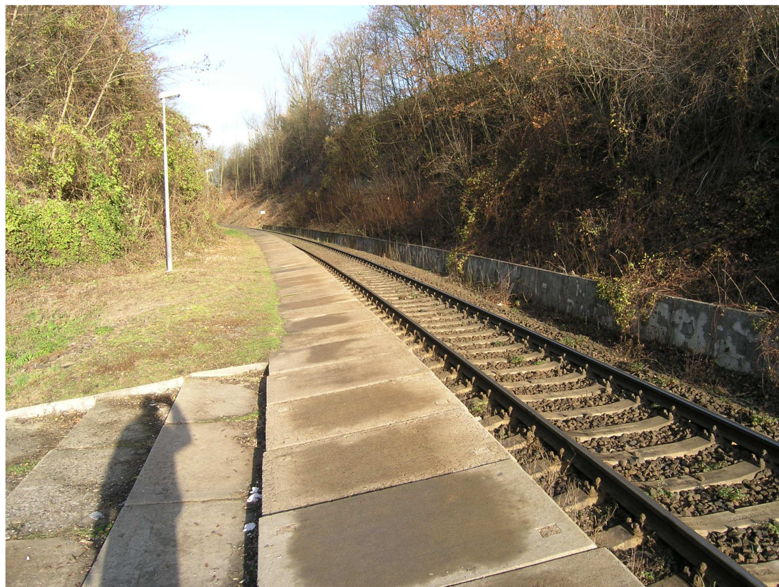
Snímek č. 38 – km 41,904 Jaroměř zastávka, nástupiště v oblouku
