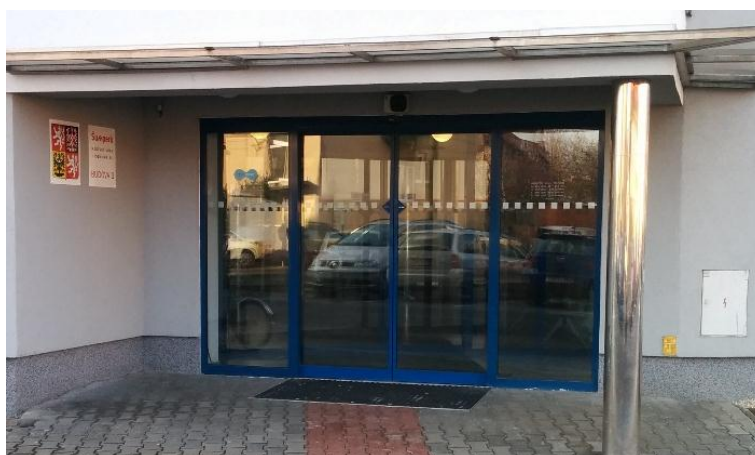
Obrázek 9 Boční vstup do budovy Městský úřad Šumperk
