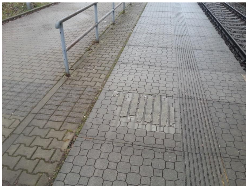
Obrázek 14 Chybně provedená odbočka SP na VLVP v Česká Lípa – Holý vrch
