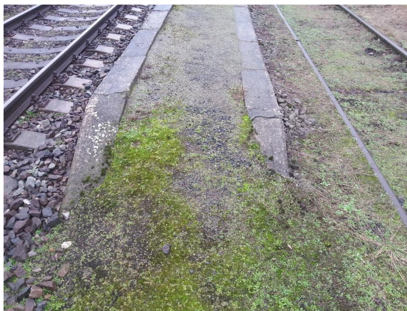
Obrázek 13 Konec nástupiště ve stanici Stružnice
