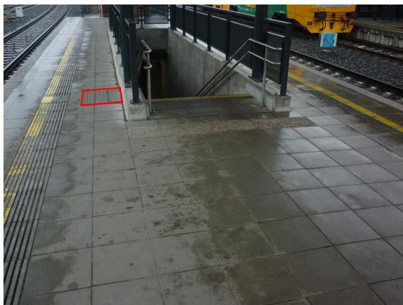
Obrázek 15 Schodiště do podchodu z nástupiště v České Lípě hl. n.
