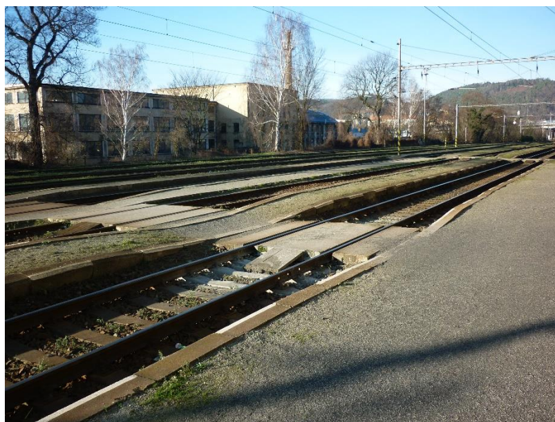
Obrázek 5 Úrovněm přechod přes koleje v Děčín východ bez hmatných prvků
