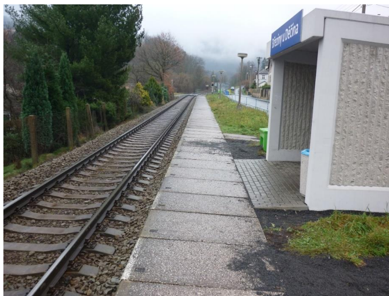
Obrázek 6 Nástupiště bez VLVP a SP na zastávce Březiny u Děčína
