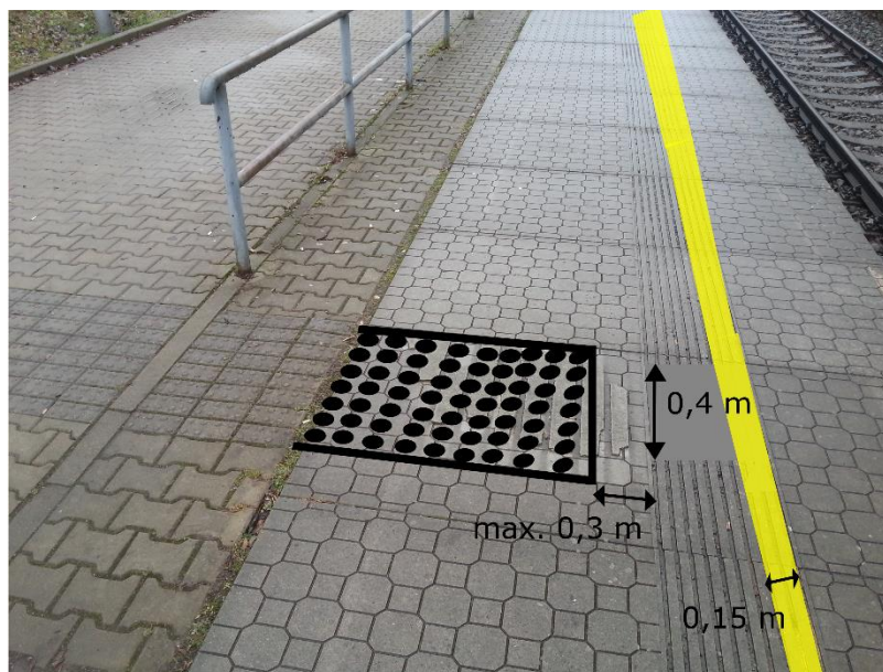
Obrázek 26 Návrh na opravu odbočky SP na VLVP
