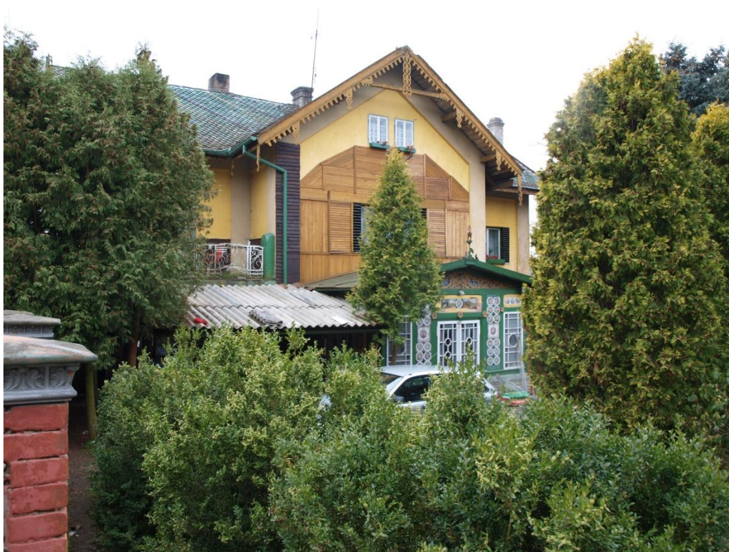
Obrázek 19 – zadní strana vily s původním dřevěným vestibulem, v popředí detail keramické hlavice plotového sloupku
