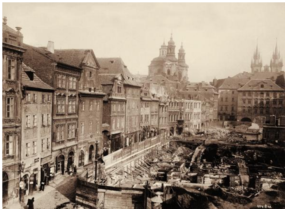
Obrázek 15 – průběh bourání staré zástavby v rámci asanace, Somerschuhův závod (zcela vlevo) byl zbořen také
