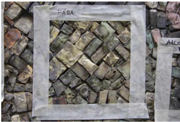
Obr. 24: Zkoušky čištění mozaiky v Praze-Vršovicích. Zkouška čištění pomocí parního čističe za současného mechanického namáhání čistícími kartáčky.
