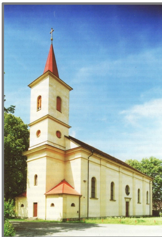
Obr. 5: Pohled na kostel sv. Václava od severovýchodu – současný stav (zdroj: HORYNA M. – REMLOVÁ M., SHP ).
