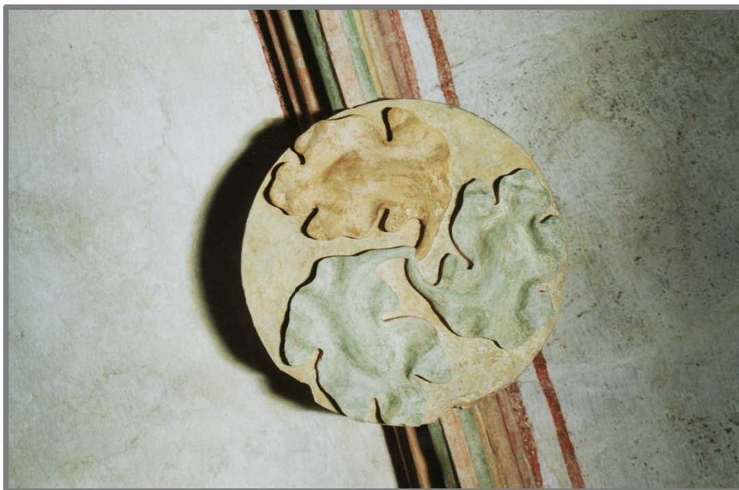
Obr. 35: Třetí z klenebních svorníků v presbytáři kaple dekorují tři vířící dubové listy (foto: E. Vymětalová).
