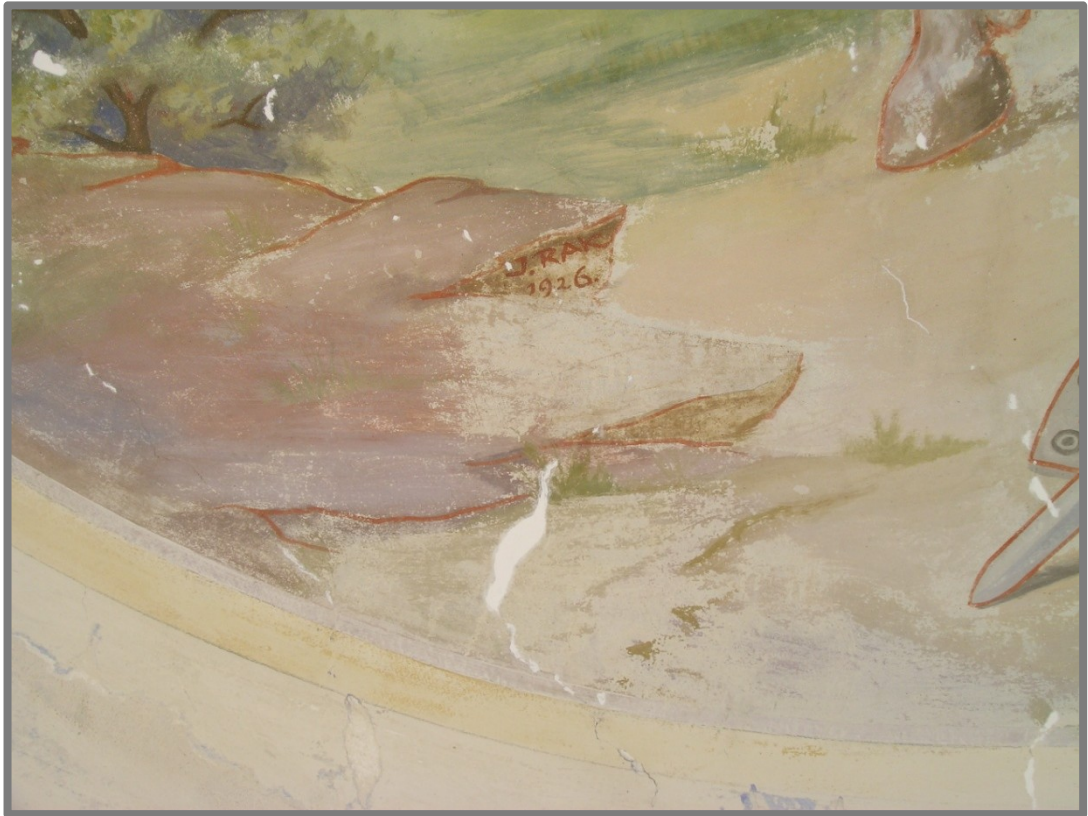
Obr. 50: Část dolní partie malby. Stav po tmelení (foto: E. Vymětalová).
