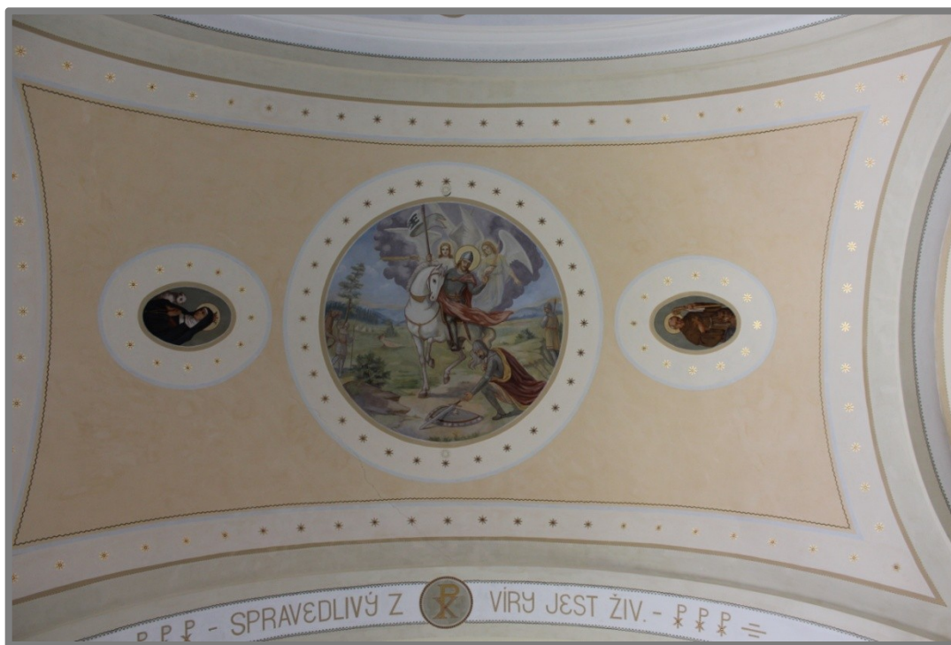
Obr. 93: Celkový pohled do třetího klenebního pole. Stav po restaurování (foto: E. Vymětalová).
