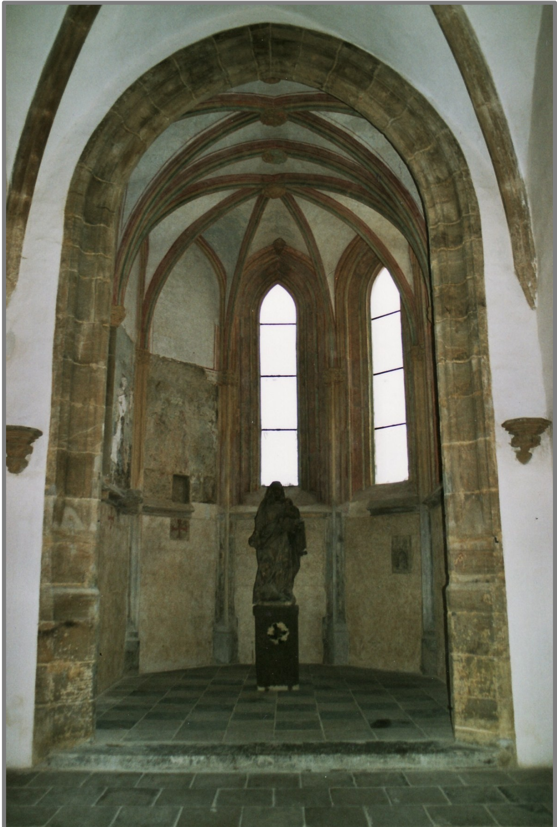
Obr. 18: Stav presbytáře kaple po ukončení restaurátorských prací v roce 2002 (foto: E. Vymětalová).
