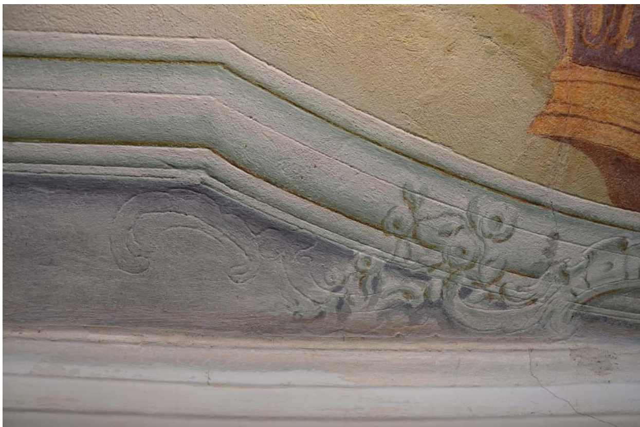
Obr. 21: Detail ryté kresby provedené do čerstvé omítky v oblasti malované architektury. Linie jsou ostré a hluboké. Ve figurální části je rytá kresba vynechaná nebo dodatečně zahlazena. Foto v ostrém bočním světle.
