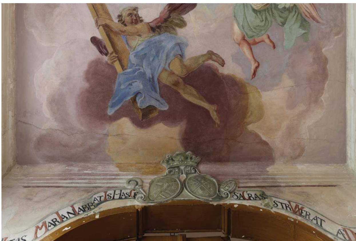
Obr. 25: Praskliny v pravém postranním výjevu vedoucí příčně přes celou šíři malby. Praskliny se nacházejí v pozadí nad hlavami postav, dále v postavách Krista a Boha Otce a pod nimi. Foto z roku 2021, Martin Mádl. V současnosti je malba v těchto místech provizorně zajištěna.
