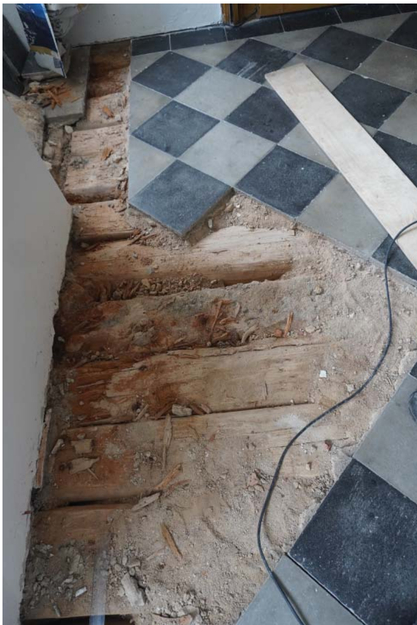
Obr. 13: Část stropu odhalená pro posouzení stavu konstrukce statikem.
