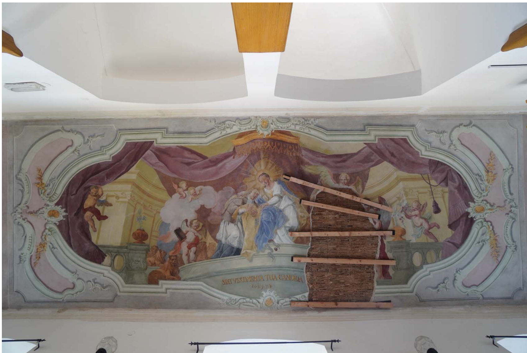
Obr. 06: Hlavní scéna po provedení dočasného zajištění, současný stav.
