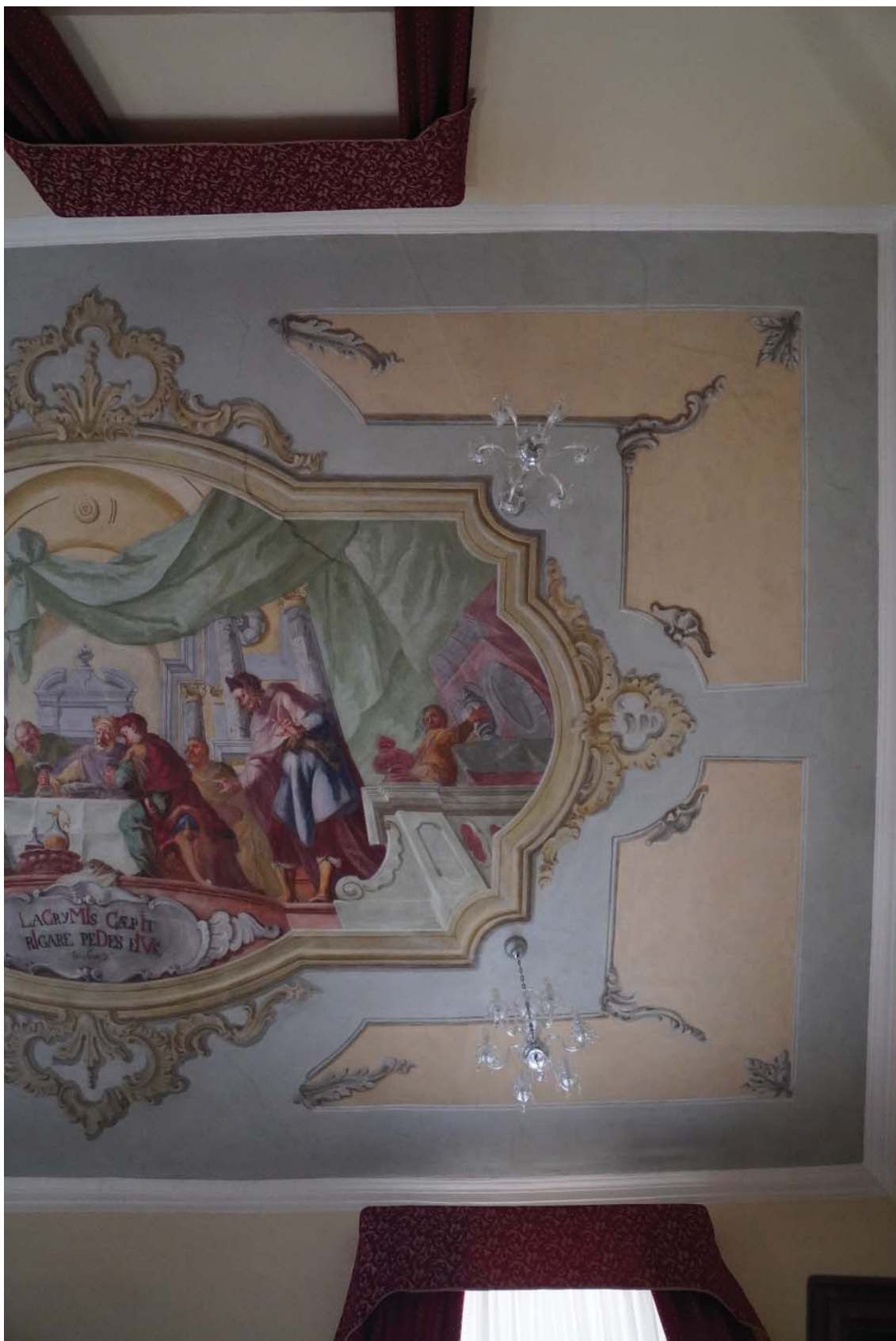
Obr. 48: Pravá část nástropní malby v sále. Dekorativní rámování včetně šedých a okrových ploch je druhotně přemalované a rekonstruované (patrně bylo v minulosti překryté celoplošným nátěrem).
