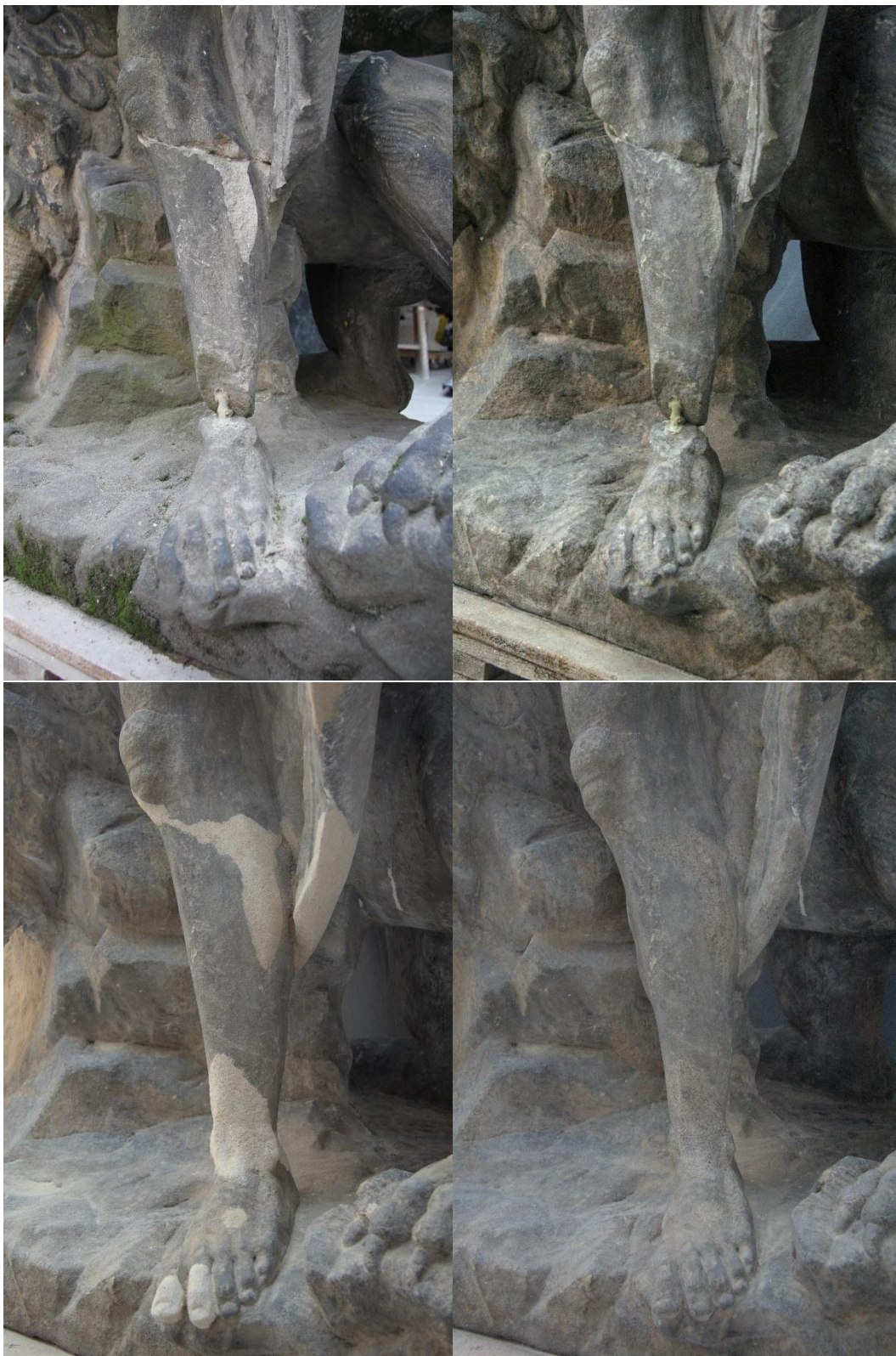
Obrázek 28 pohled na nohu skulptury průběh restaurování, nahoru zleva, stav před restaurováním, po očištění, po doplnění a po restaurování
