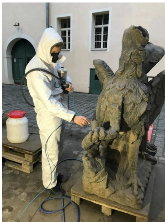
Obrázek 36 vlevo čištění skulptury od biologického napadení, vpravo redukce sčernalé krusty
