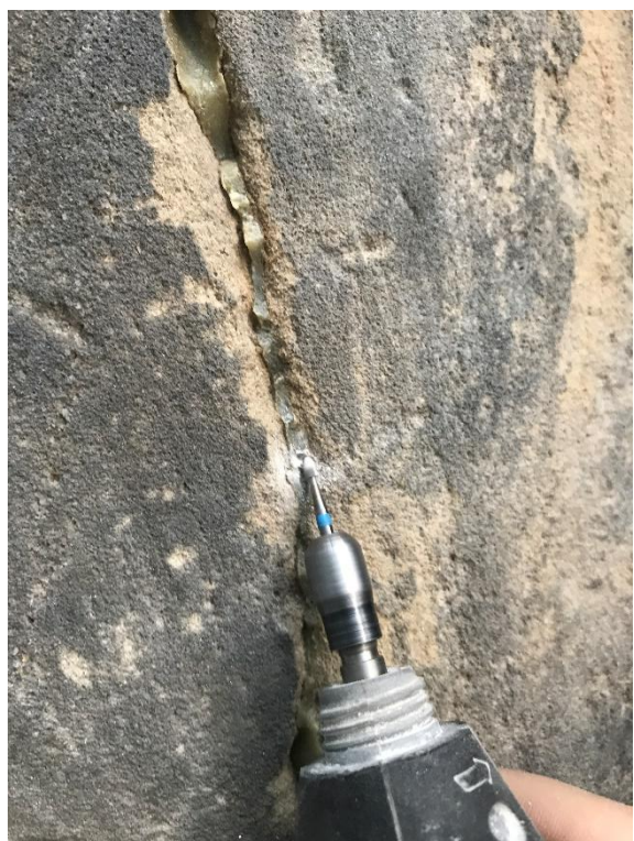
Obrázek 41 vlevo injektáž trhlin, vpravo odstraňování vystouplého epoxidu z lepených spojů pomocí mikro-brusky
