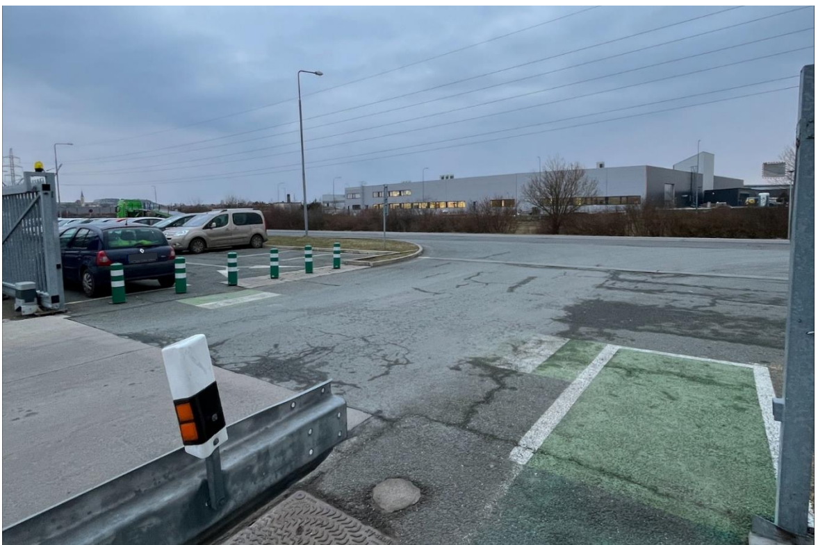
Obrázek 5: Nedostatečně viditelný přechod
