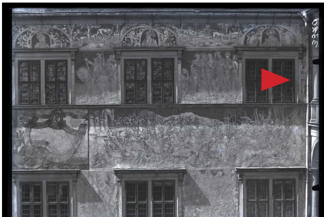
Obr. 01: PODHAJSKÝ, Jos. a MAYERDER J. (1885). Sgraffitová fasáda II. nádvoří zámku v Litomyšli , rytina. Místo: SOA Zámorsk, fond Velkostatek Litomyšl, Wiener Bauhutte XVIII, 1891, tab. 14-18, inv. č. 384.
