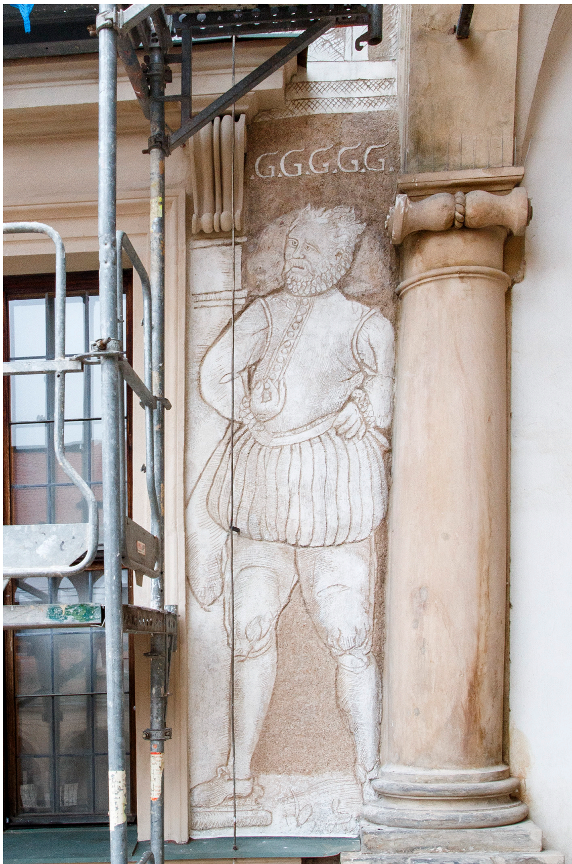
Obr. 67: Celkový pohled na restaurovaný úsek Rytíře s pěti G . Stav po restaurování.
