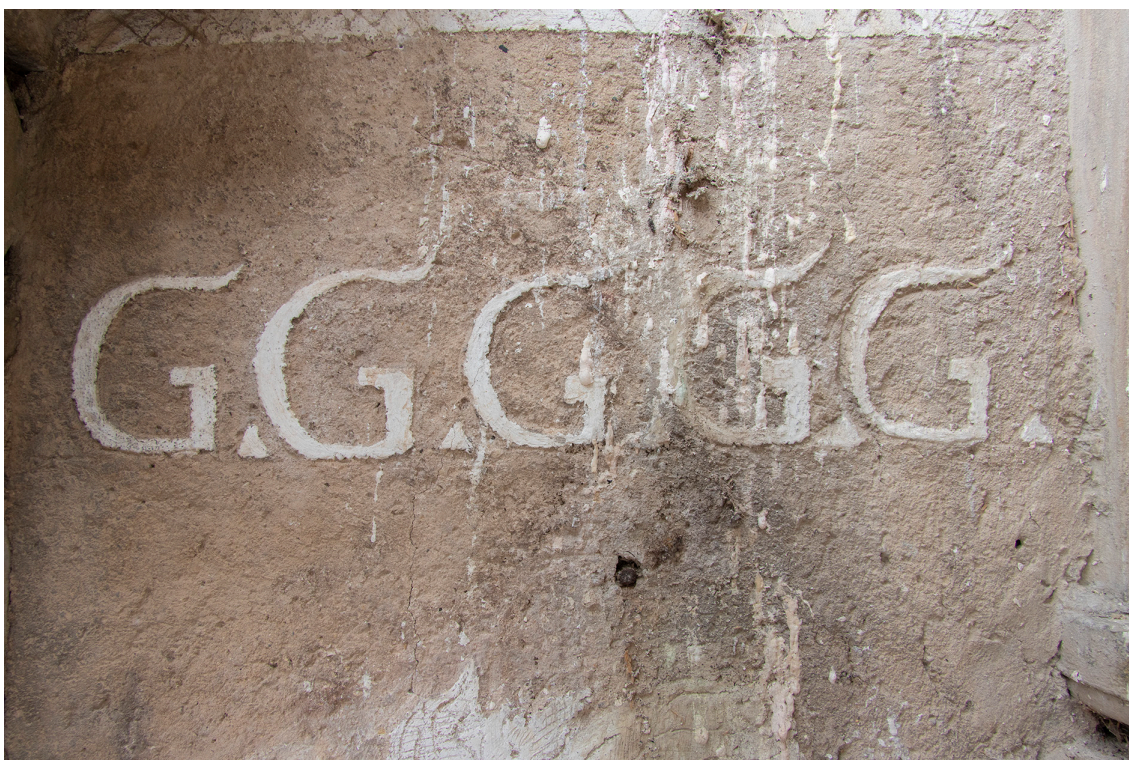
Obr. 31: Detail horní části úseku s druhotně provedenou rytou římsou. V tomto místě se zalamoval okapní svod ze střechy ke stěně, v zákrytu zde usedalo ptactvo. Místo bylo silně poškozeno ptačími exkrementy.
