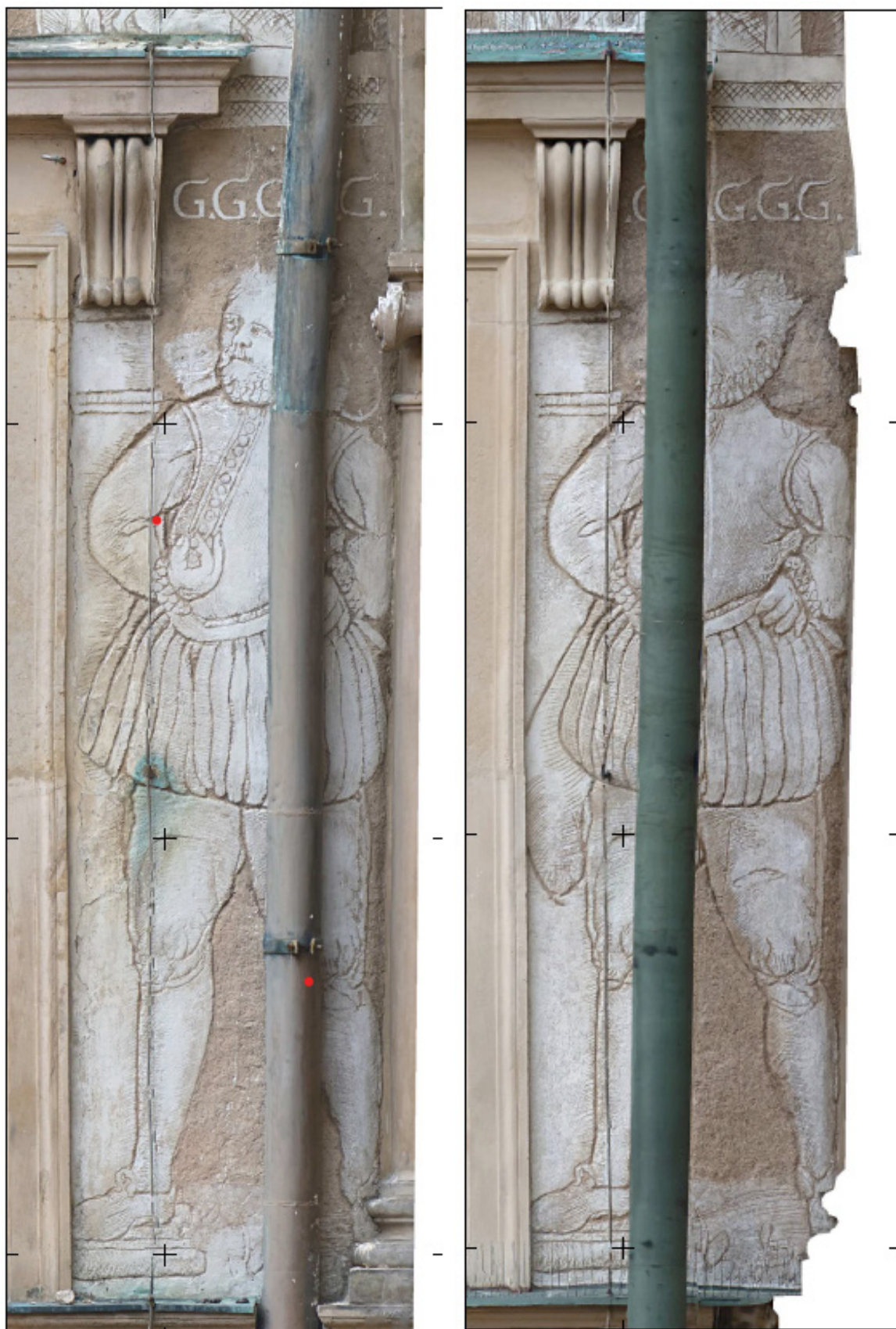
Obr. 68: Srovnání stavu před a po restaurování. Během prací v roce 2024 bylo rozhodnuto o umístění okapu dále od stěny, nicméně stále je vedeno před sgrafitovou výzdobou. Zdroj: VIDMAN, Jiří. Výjev B6 [Rytíř s pěti G] . Fotogrametrická dokumentace (ortofotoplán), stav ke dni 29.02.2024 (vlevo) a ke dni 26.11.2024.
