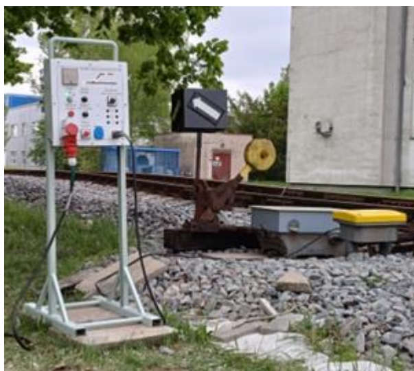
Obr. 12 - ovládací jednotka s připojeným přestavňákem, VVCD Doubravice
