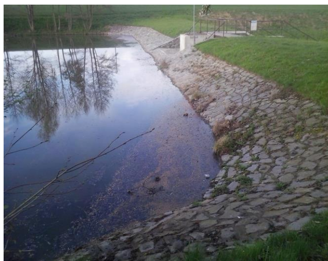
Obrázek 24: Stav hráze po opravě
