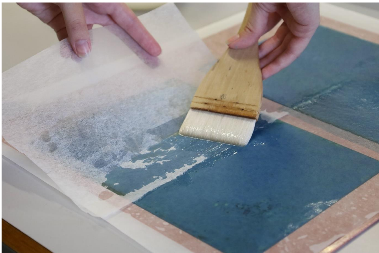
Obrázek 253 Podlepení předsádek japonským papírem
