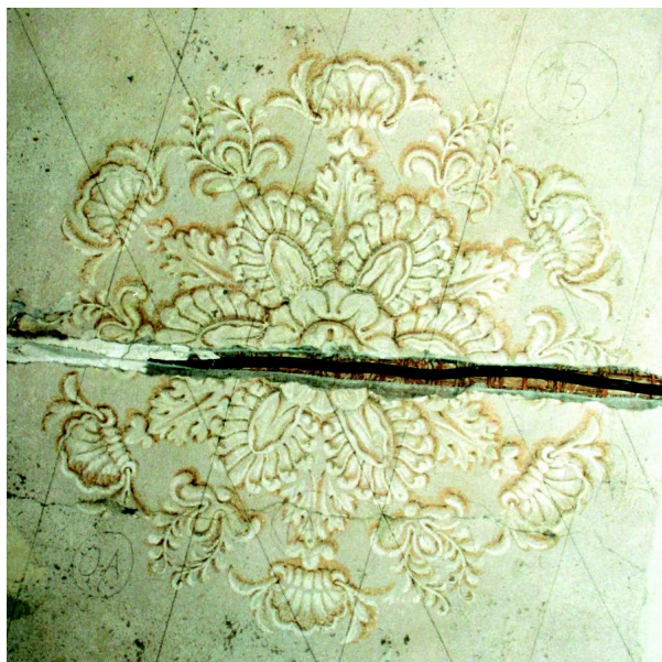
Obr. III/4-5: dvě rozety nalezené ve velkém sále 2. NP, proveden transfer
