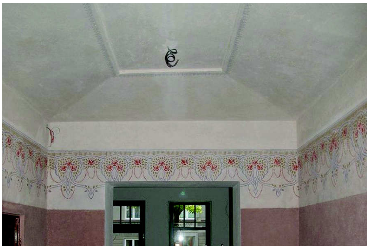
Obr. X/3-4: dům čp. 297 – místnost s okny do dvora
