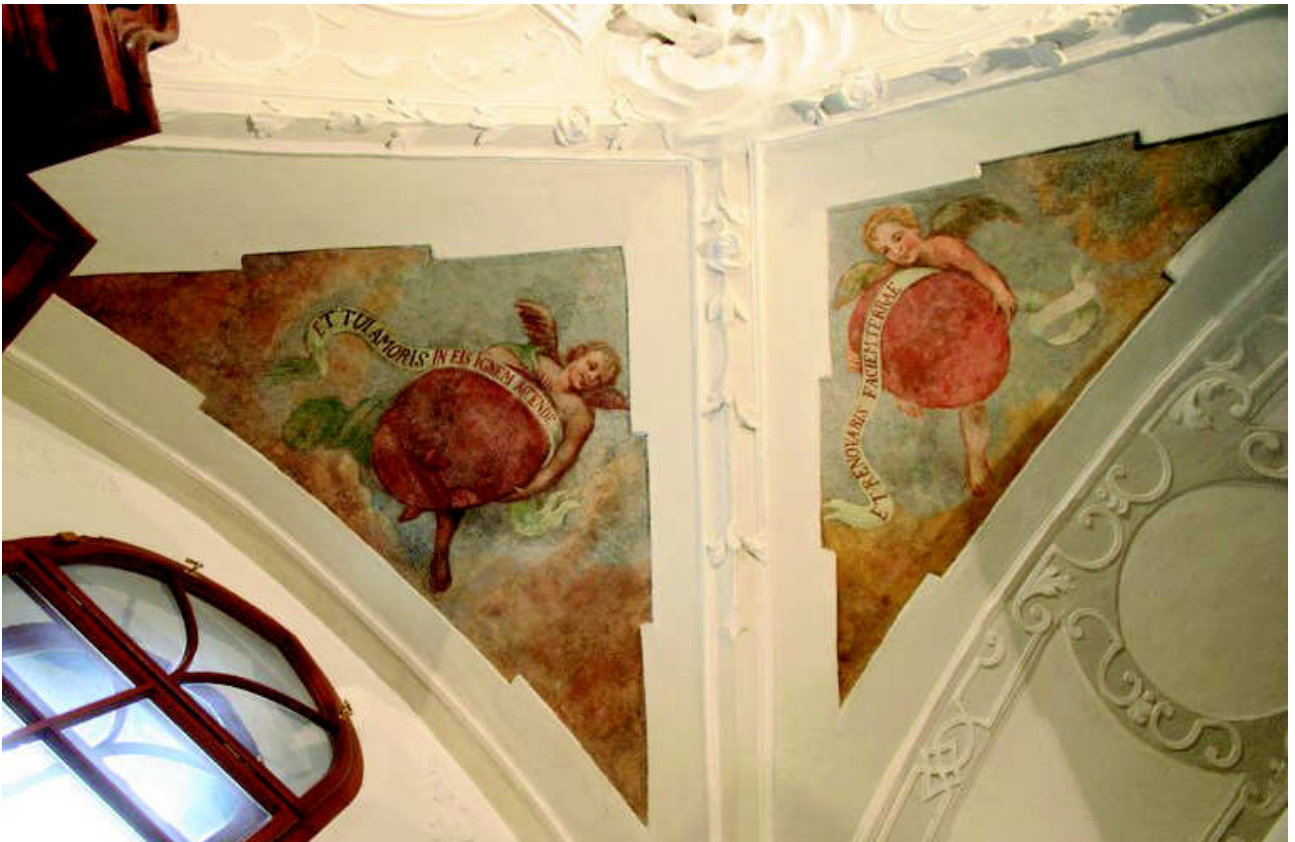
Obr. I/5: kaple sv. Michala – JV koutová výseč
