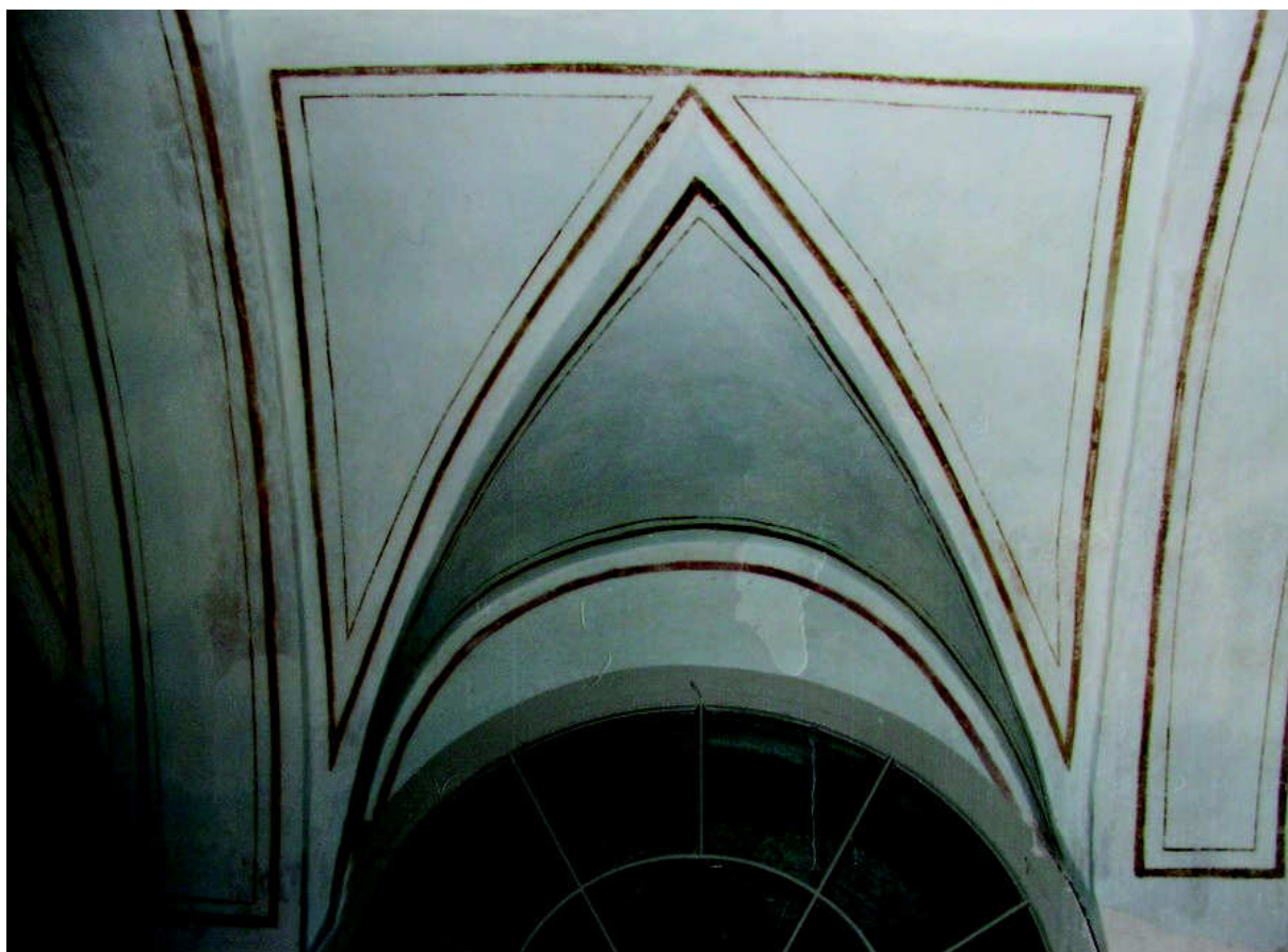
Obr IV/13: dům čp. 46 - lineární rámování na klenbě chodby a schodiště
