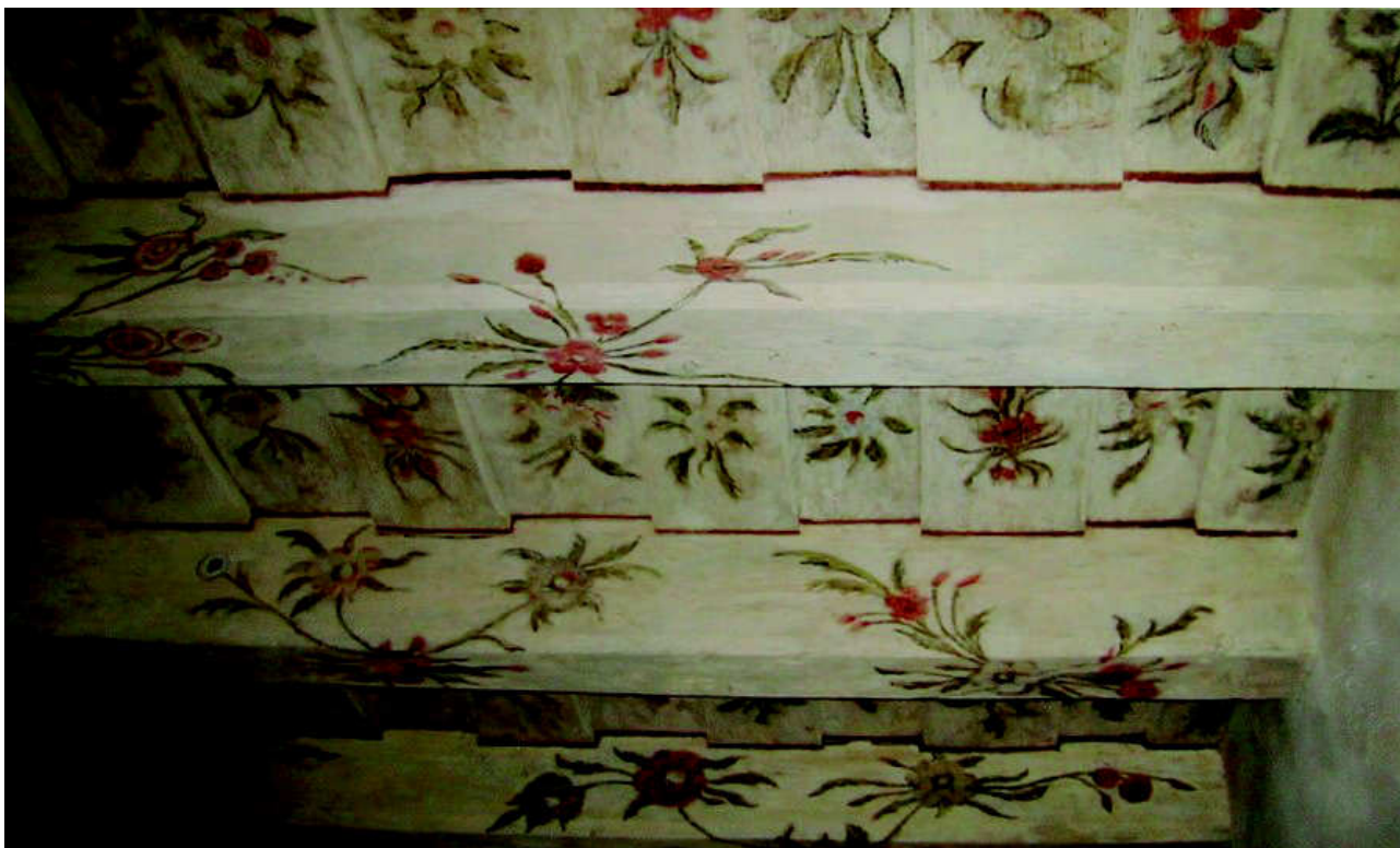
Obr. IV/1: dům čp. 11 - druhý pohledový dřevěný trámový strop s překládaným deskovým záklopem s malovanou dekorativní úpravou
