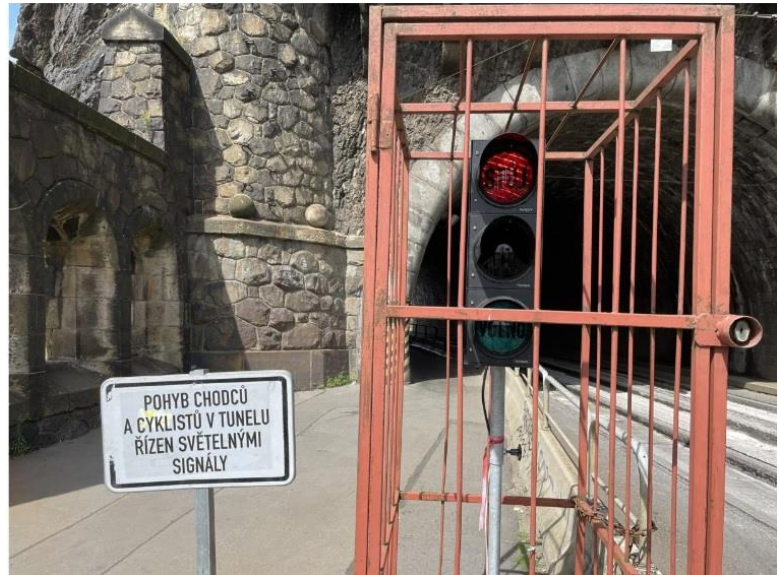
Obr. C2 Semaforové řízení chodců ve Vyšehradském tunelu
