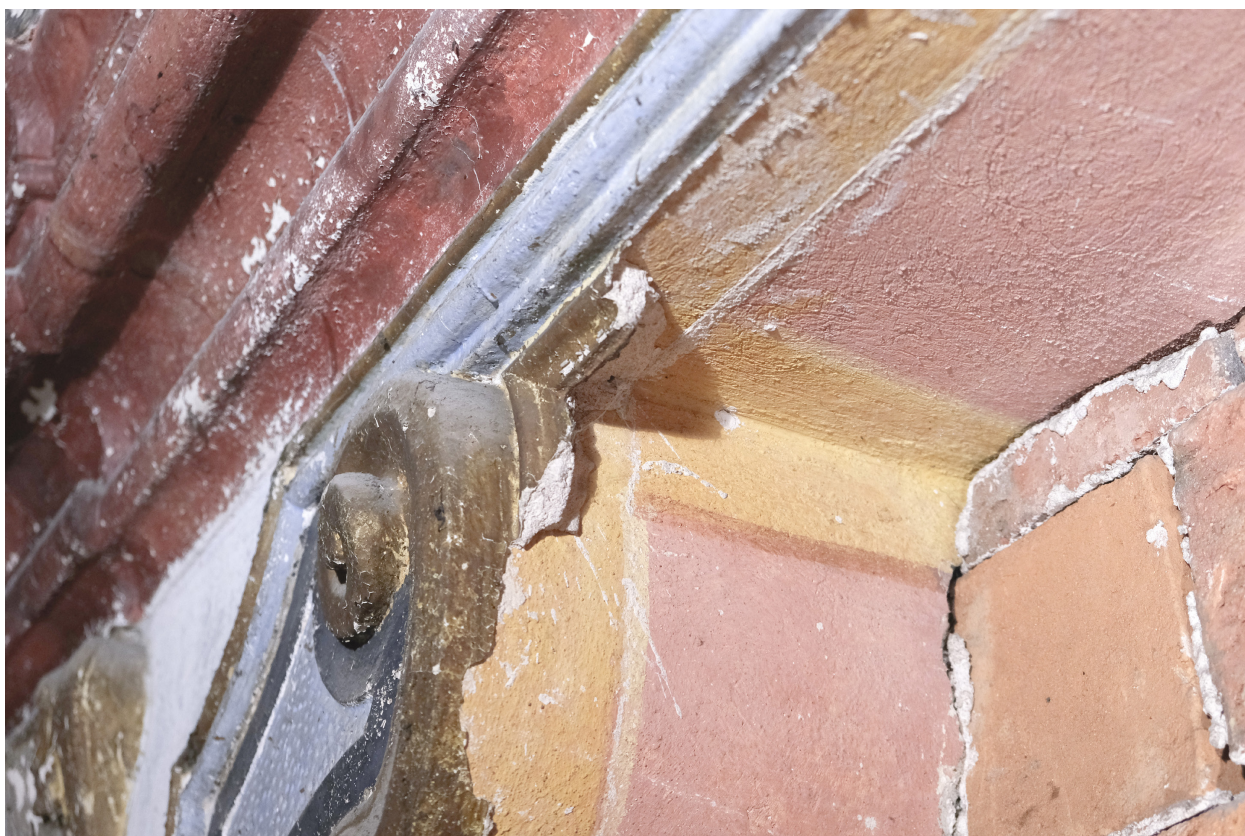
Obr. 51: Druhotně zazděná oratoř s původní výmalbou ve špaletách. Jižní stěna zámecké kaple.
