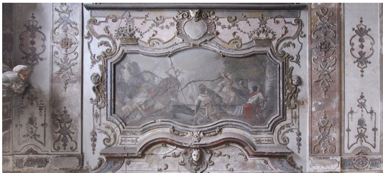
Obr. 06: Pohled na horní část severní stěny. Interiér zámecké kaple barokního zámku v Kácově.
