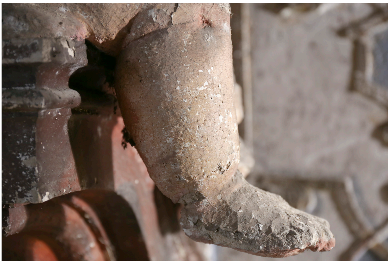
Obr. 91: Snímek většího detailu nohy anděla. Na snímku lze pozorovat ztrátu adheze barevné vrstvy k podkladu. Stav před zajištěním barevné vrstvy.
