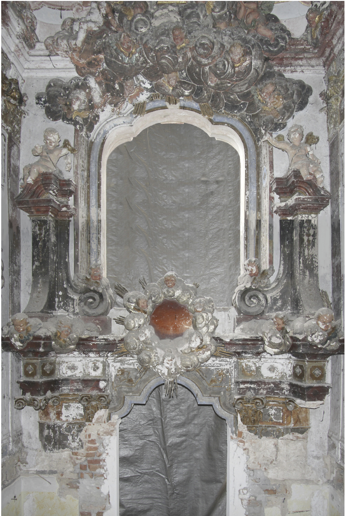
Obr. 05: Celkový pohled na západní stěnu. Interiér zámecké kaple barokního zámku v Kácově.
