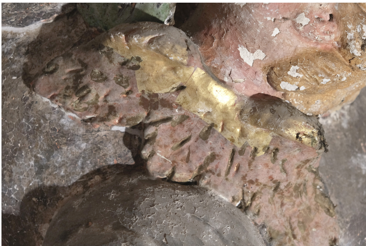
Obr. 23: Detail hlaviček andělů. Na snímku lze vidět kombinaci různých typů technik. Jedná se o zlacení stříbrem s následující lazurní vrstvou, zlacení plátkovým zlatem a polychromie štuku na křídovém podkladu. Západní oltářní stěna v zámecké kapli.
