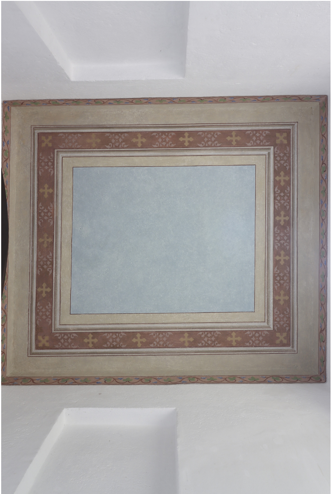
Obr. 38: Celkový pohled na nástropní malbu v kapli č. VIII. Stav po restaurování.
