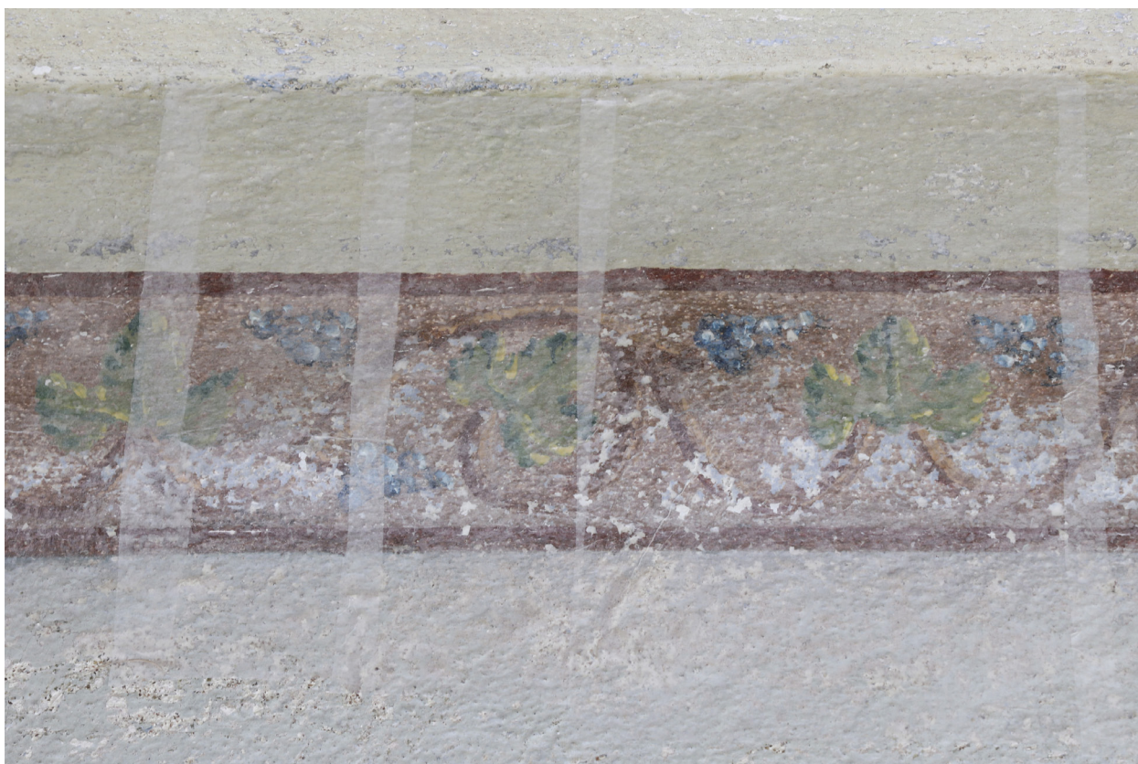
Obr. 47: Snímek dokumentující stav omítkové a barevné vrstvy po odkryvu. Na snímku lze pozorovat, že ohrožené nesoudržné části omítky byly zajištěné přelepy z japonského papíru.
