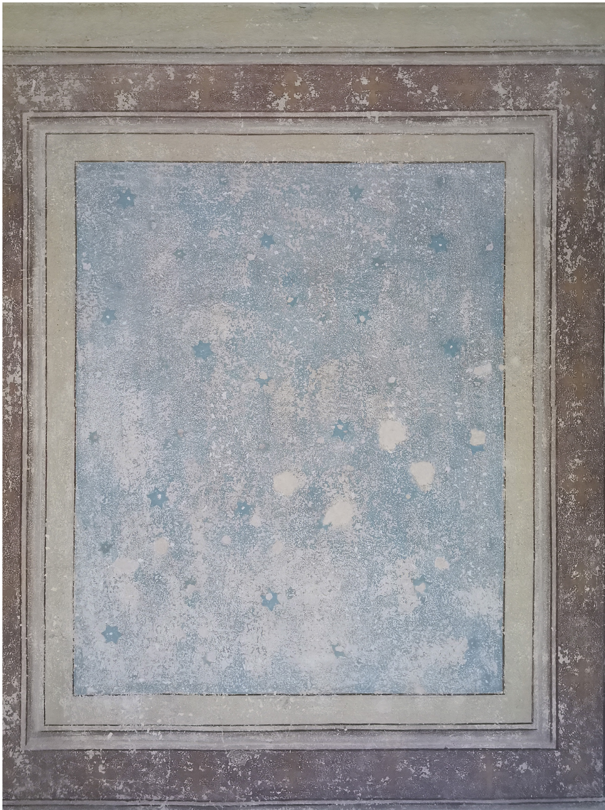
Obr. 64: Pohled na strop v kapli č. X. Stav po vytmelení.
