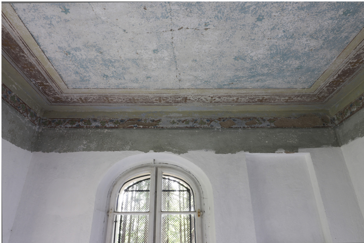
Obr. 81: Pohled na strop a horní část východní stěny v kapli č. XI. Stav po odkryvu.
