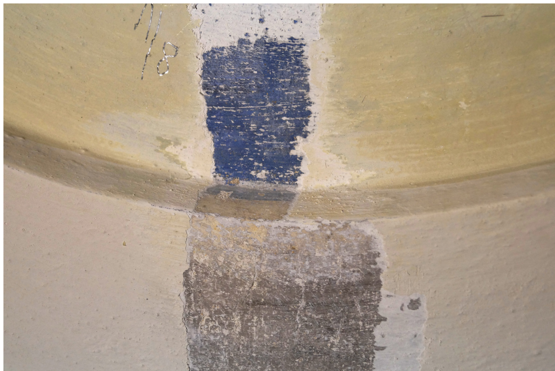
Obr 22 Sonda č. 1/8 - výmalba zrcadla a rám - detail.
