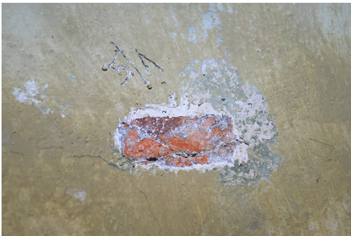
Obr 60 Sonda č. 5/1 - výmalba zrcadla a rám. 1. barokní malba (rumělka?, hnědočervená) 2. bílá (podkladová), 3. šedá, 4. zelená, 5. okrová hlinka.
