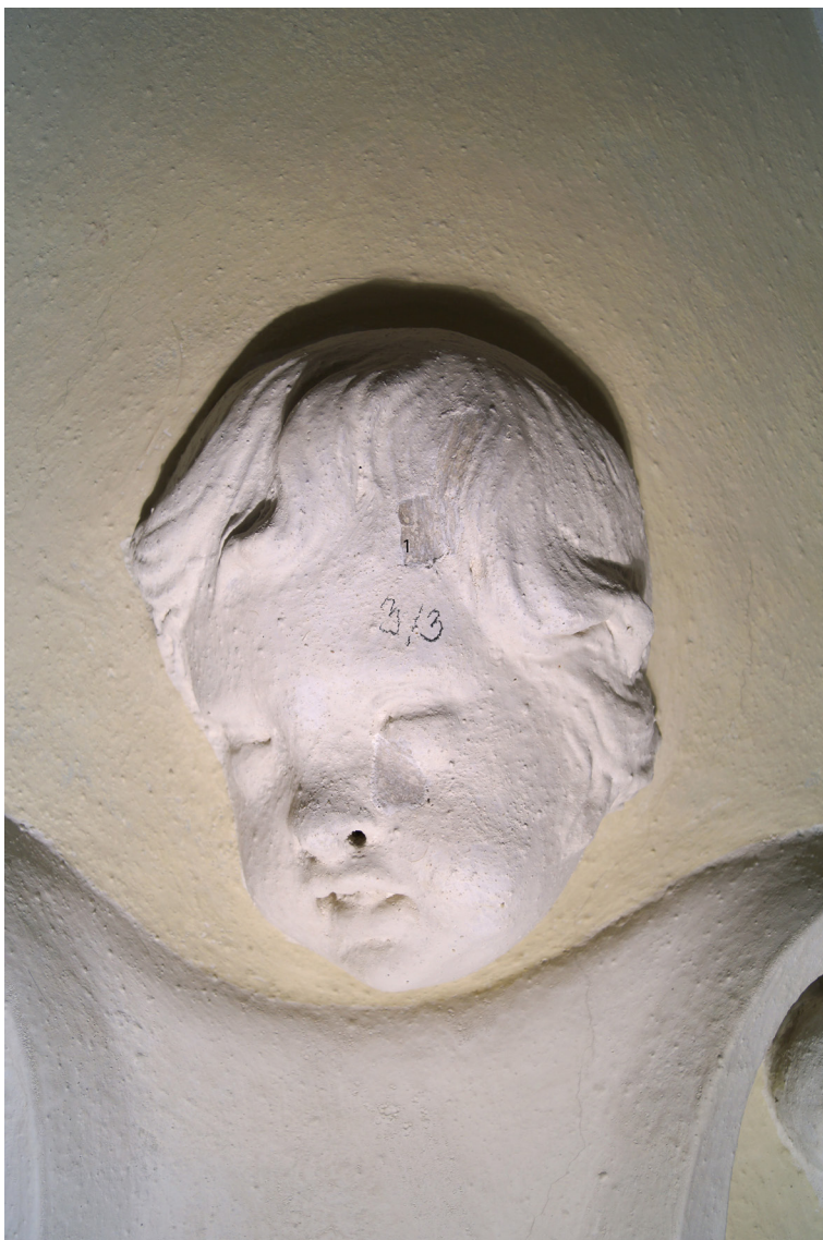
Obr 34 Sonda č. 3/3 na hlavičce pole nad kartuší s malbou - č. 1. šedookrový hladký povrch štuky se třema bílými nátěry.
