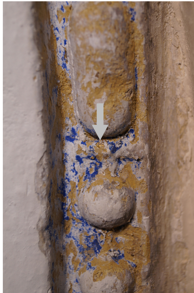
Obr 47 Sonda Ž4/1 - detail. zřetelný podkladový bílý nátěr pod modrou, šipkou označený fragment zlacení, který není na bílé podkladové vrstvě, tj. mohlo by jít o starší zlacení (náález však není průkazný). Modré pozadí má odstín ultramarínu.
