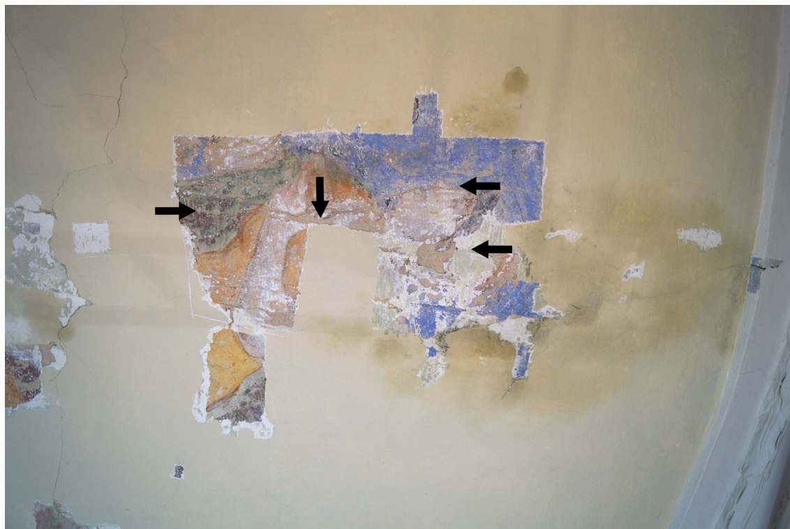
Obr 14 Rozšířená sonda z předchozího průzkumu poli č. 1. (profil postavy s helmicí, ramena s pláštěm). Středem postavy probíhá statická trhlinka, již v minulosti vytmelená.
