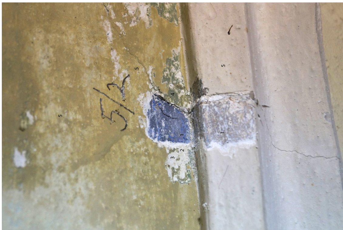
Obr 61 Sonda č. 5/2 - výmalba zrcadla a rám. 1. barokní malba (modrá), rám šedodokrová 2,3. bílá, 4. zelená, 5. okrová hlinka v polích a bílá hlinka na rámu.
