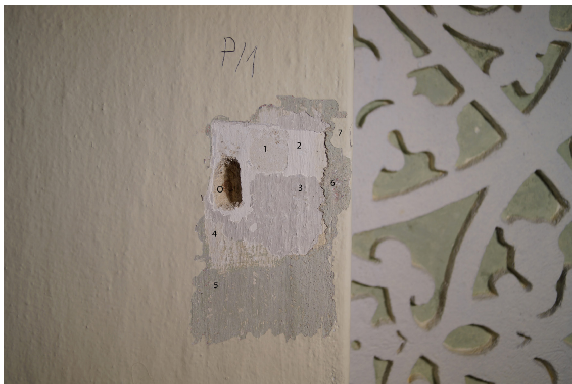
Obr 68 Sonda P/1 - pilastr pod náběhem klenby vlevo od okna O tmavší omítka sokrovým nádechem 1. světle okrový povrch omítky 2. bílá 3. šedá 4. světle šedá 5. zelená 6. šedá se stříkanci červené (nápodoba žuly). 7. okrová hlinka
