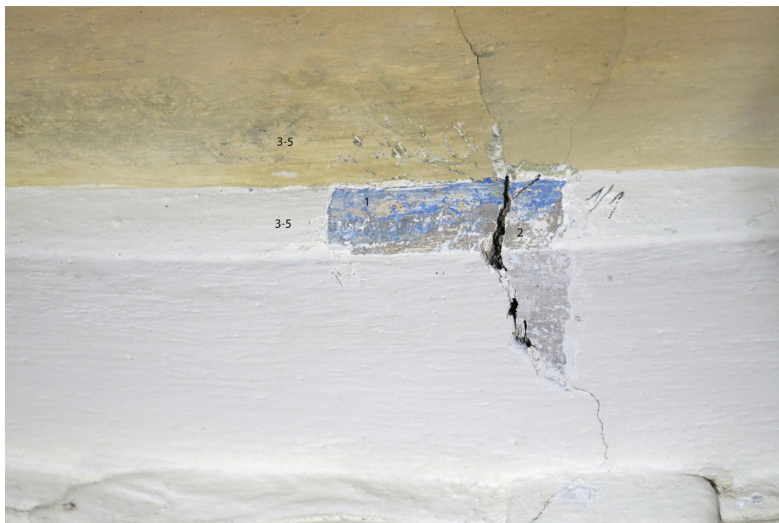
Obr 15 Sonda č. 1/1. na rámu zrcadla s malbou. 1. tmavší barokní malba (modré pozadí) se přelévá na vnitřní hranu rámu, dále na rámu pokračuje šedookrová 2. tvamší šedá; 3-5 vrstva bílé na rámu zrcadla, uvnitř zelená a okrová.
