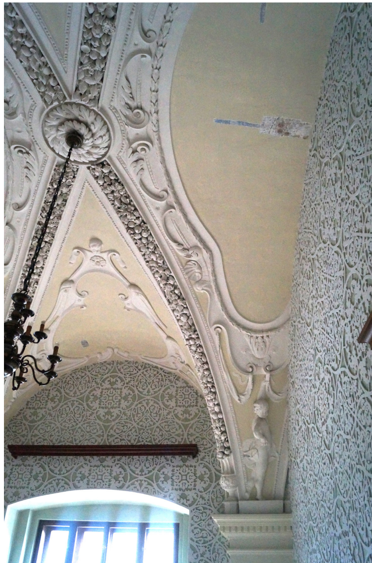
Obr 6 Celkový pohled na náběh klenby napravo od okna.
