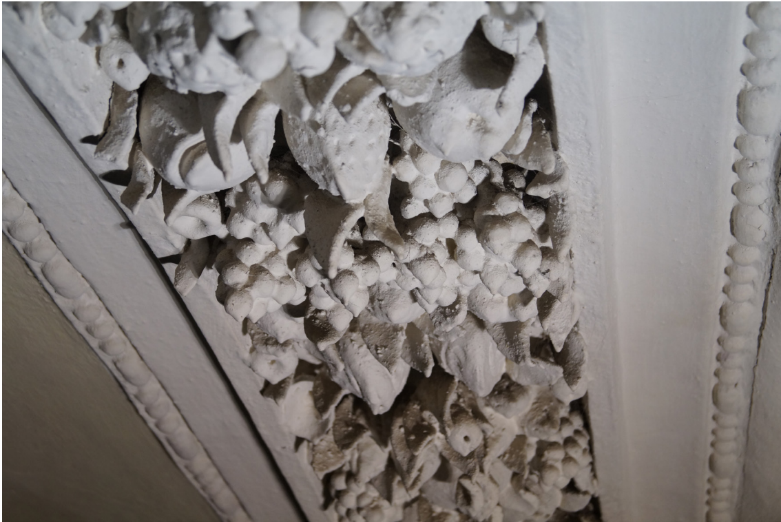
Obr 58 Poškození štuky - zalití modelací, v bočním světle zřetelná hrubost nátěru.
