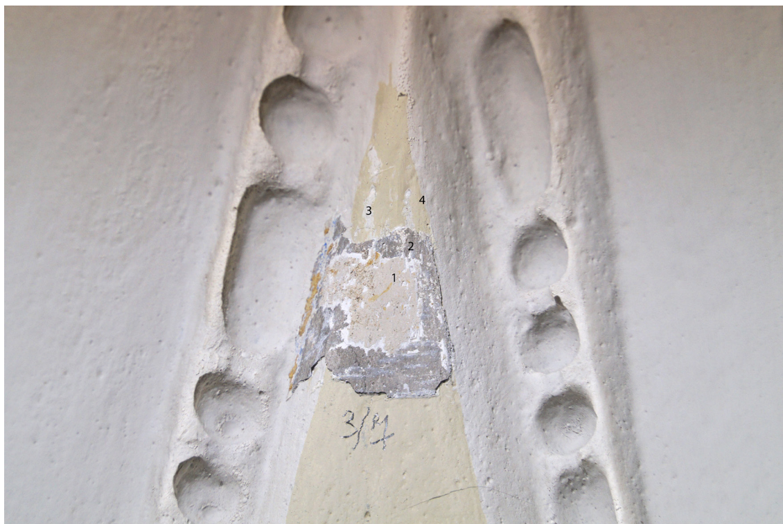
Obr 39 Sonda č. 3/7 v ploše ve špičce středu klenby mezi perlovci. 1. smetanový hlad- ký povrch štku, fragmenty okrového podkladu na perlovci 2. šedá na bílém podkladu 3. bílá, 4. okrové hlinky.
