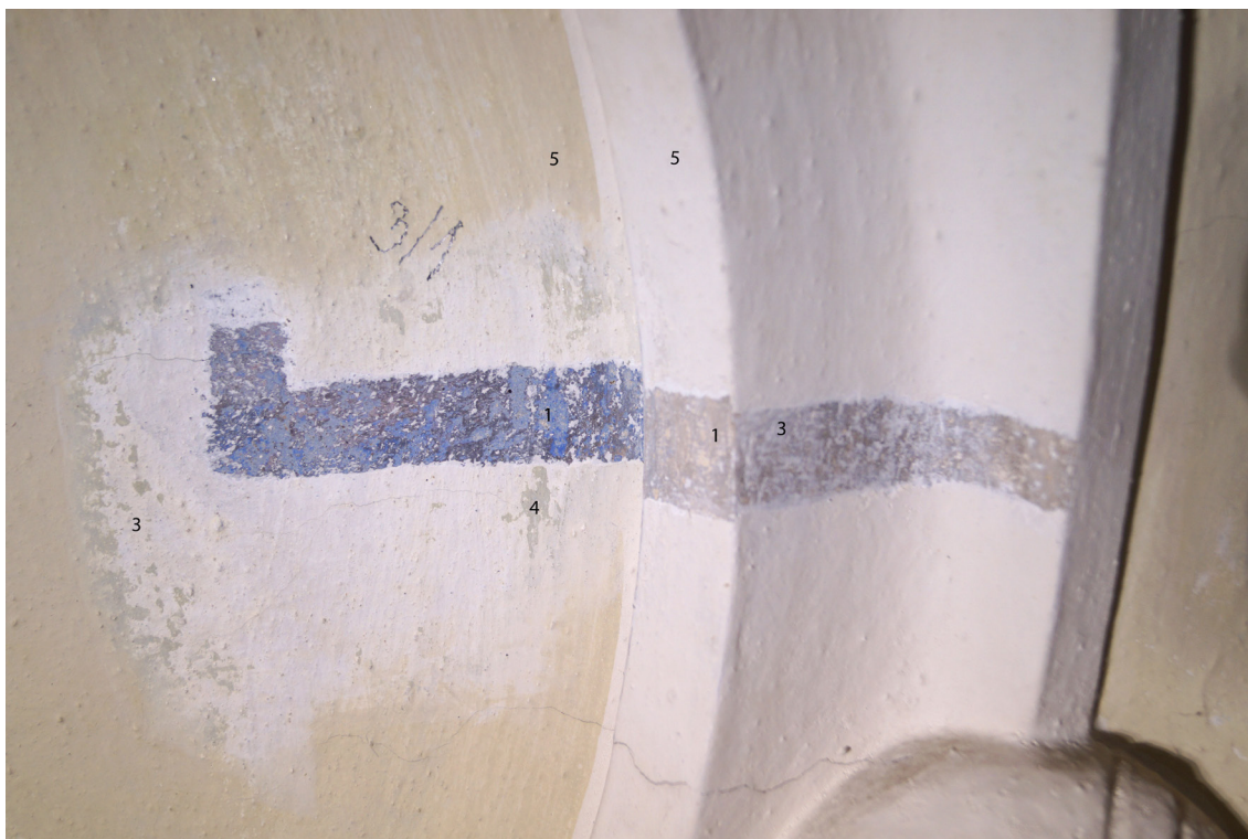
Obr 32 Sonda č. 3/1 - výmalba zrcadla a rám. 1. barokní malba (modrá) rám šedá 2. bílá v ploše; 3. bílá v ploše, šedá na rámu 4. zelená fragmenty, 5. okrová hlinka.
