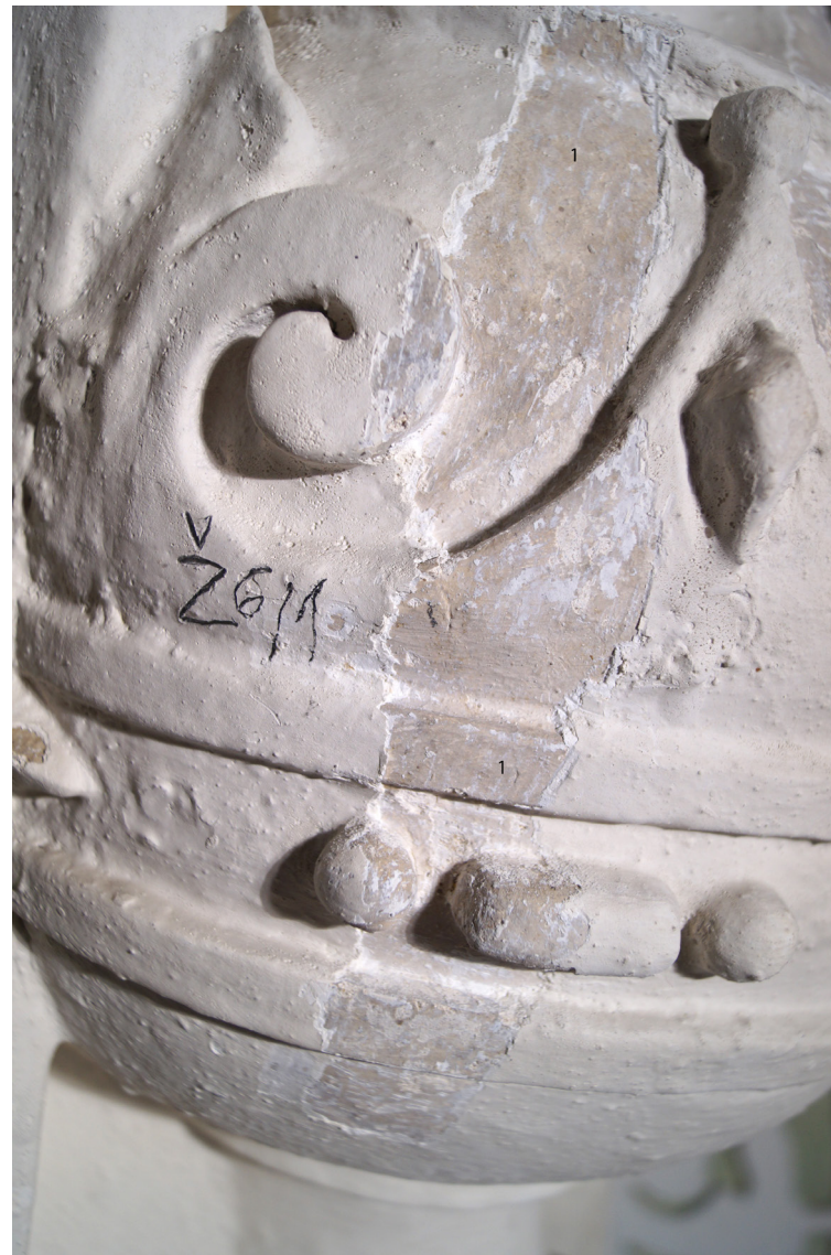
Obr 65 Sonda Ž6/1 - zkouška odkryvu na váze -původní povrch štuk hladký, světle okrový, místy mírně našedlý.
