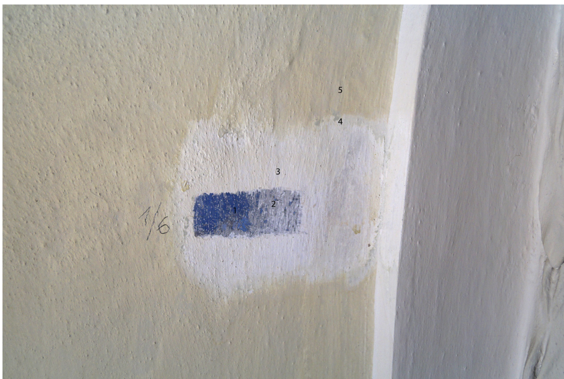
Obr 19 Sonda č. 1/6 - výmalba zrcadla. 1. barokní malba (modrá) 2. bílá; 3. bílá, 4. fragmenty zelené, 5. okrová.
