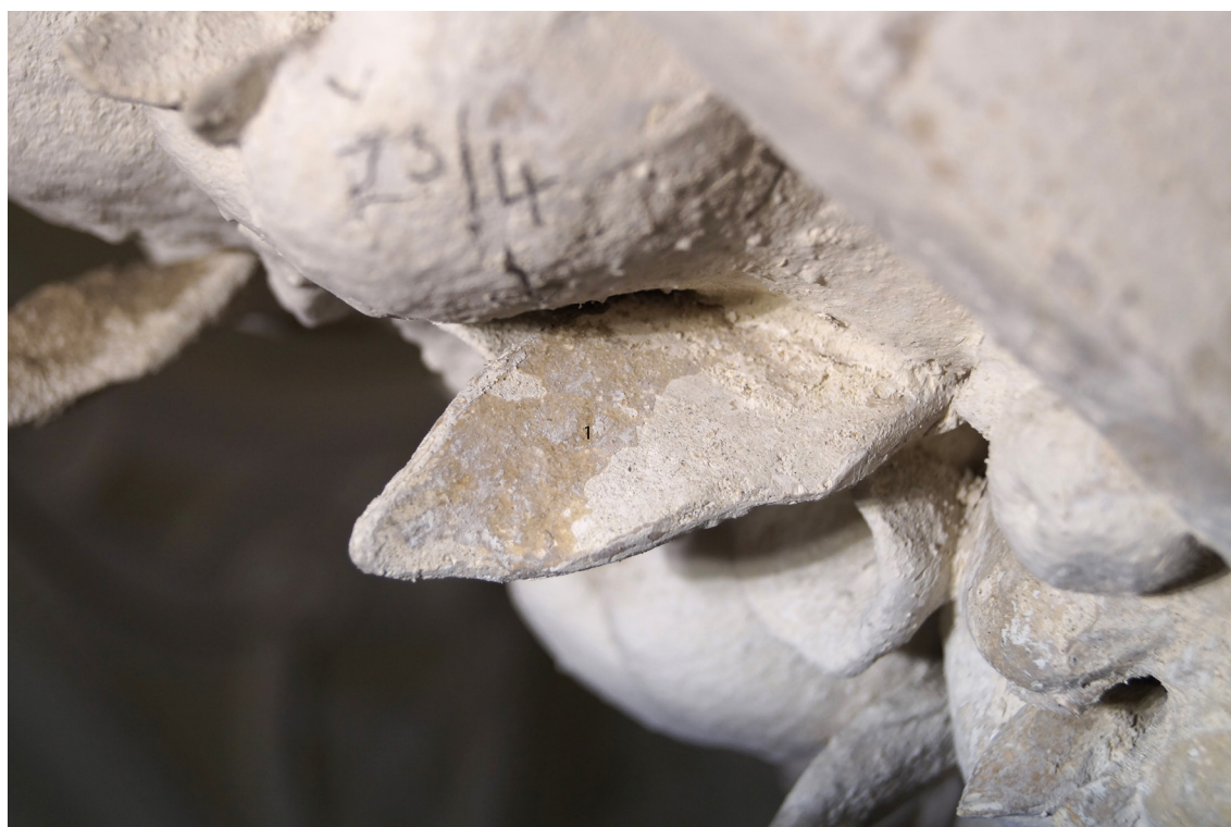
Obr 30 Sonda č. Ž3/4 - 1. šedookrový hladký povrch světlého štku; následují 2-3 vrstvy bílé (první vápenné, poslední stříkaná hlinka)
