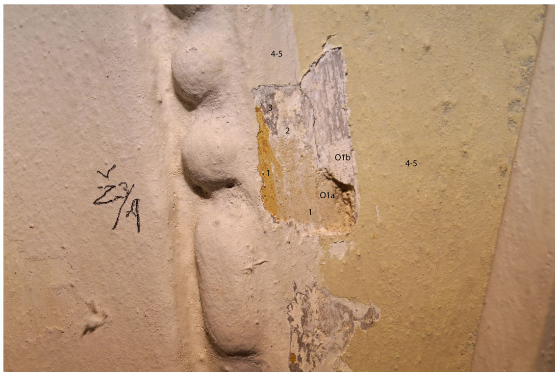
Obr 27 Sonda č. Ž(žebro) 3/1: O1a - okrovorůžový tmavší štuk konstrukčních prvků a perlovce, zabíhá pod světlejší štuk výplně náběhů O1b (pravděpodobně řemeslný postup při kterém uplatňovali rozdílné technologie pro jednotlivé části a typy výzdoby typické pro techniku tzv. bílého římského štuk).
