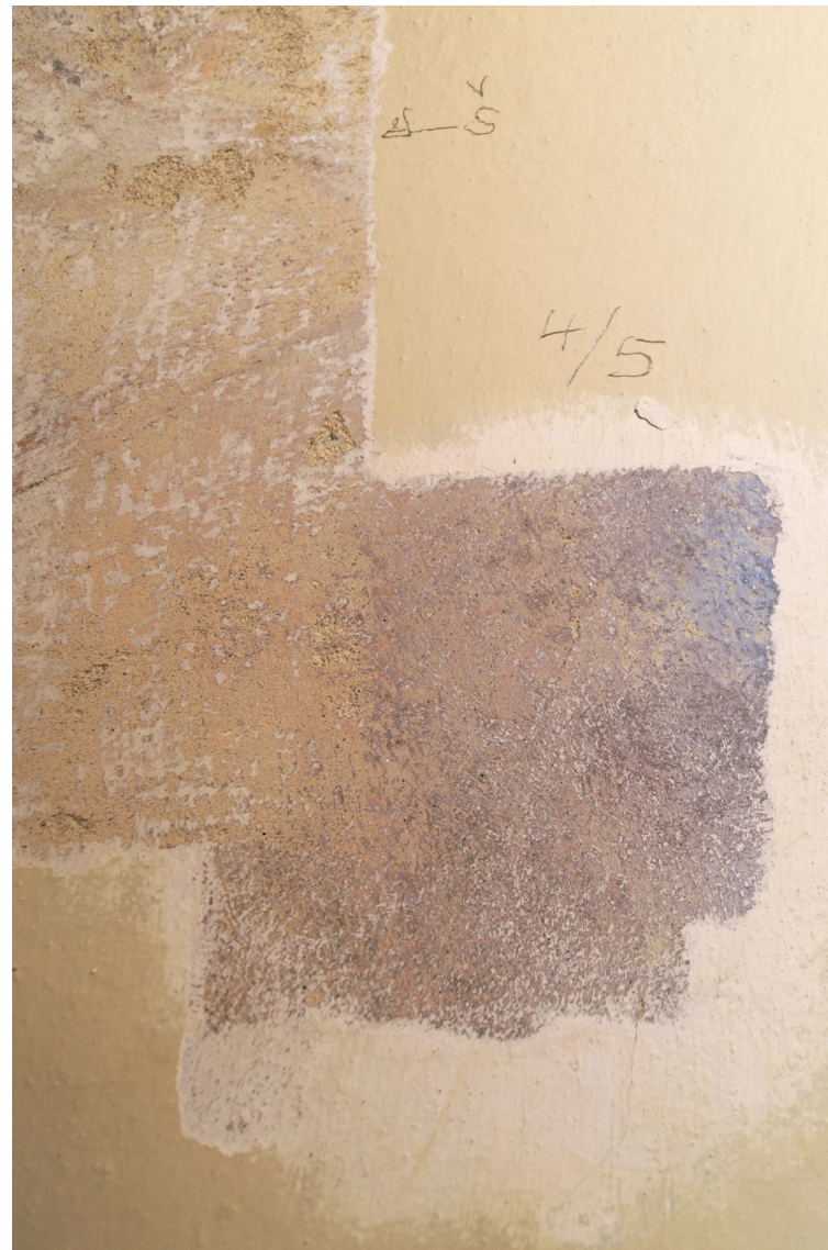
Obr 45 Sonda č. 4/5 - výmalba zrcadla, barokní malba (podklad velmi poškozený, na modré tmavší fragmenty kaput mortuum a fialové, je možné, že jde o pozdější barokní přemalbu nebo autorské korektury).
