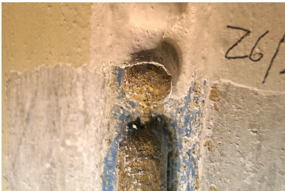
Obr 67 Sonda Ž6/2 - detail zlatých akcentů. Z vizuálního průzkumu se zdají dvě vrstvy - nutné doložit mikroskopicky.
