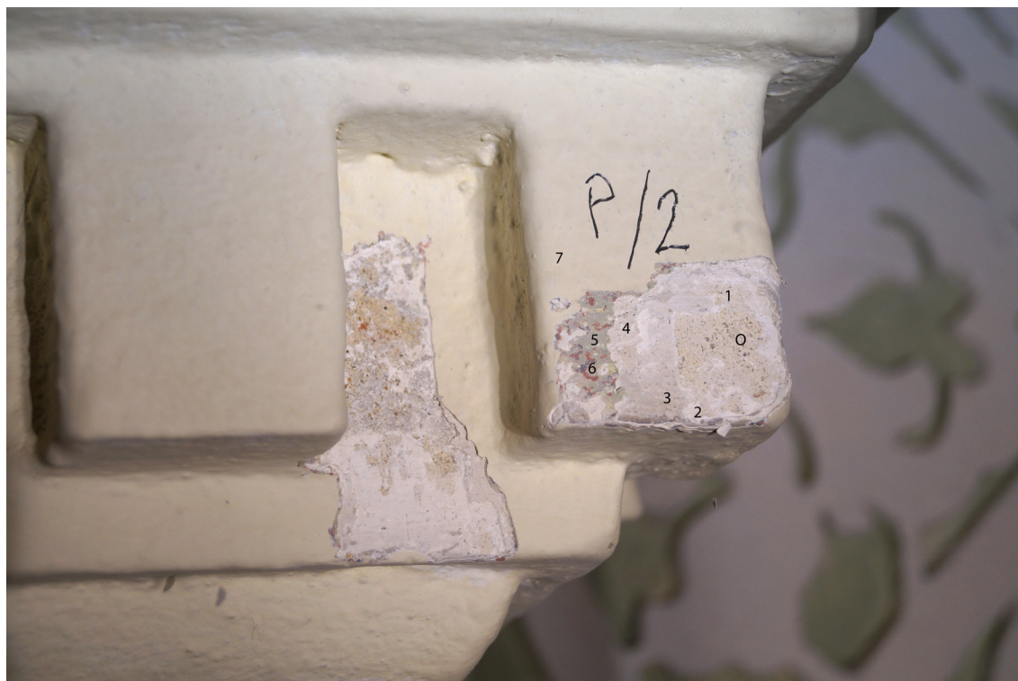
Obr 69 Sonda P/2 - hlavice pilastru pod náběhem klenby vlevo od okna O světlá omítka s tmavou kamennou drtí 1. světle okrový povrch omítky 2. bílá 3. šedá 4. světle šedá 5. zelená 6. šedá se stříkanci červené (nápodoba žuly). 7. okrová hlinka
