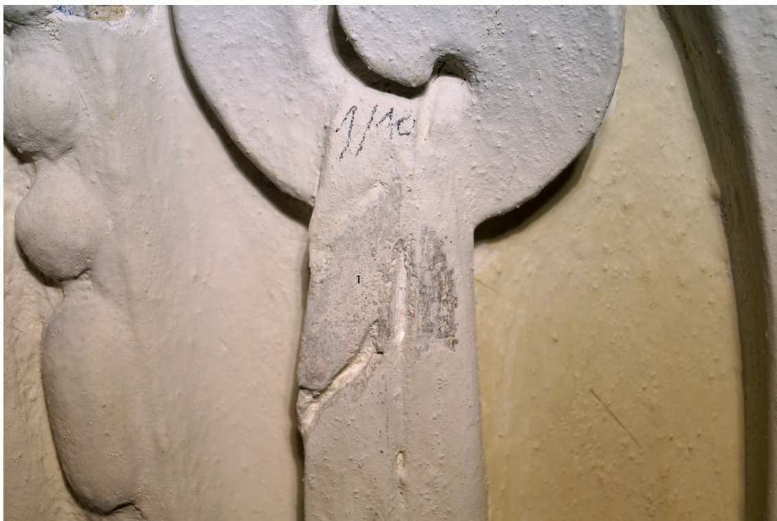
Obr 24 Sonda č. 1/10 - listovec na rámu zrcadla 1. „režný“ šedookrový povrch štku na něm 3 vrstvy bílé, poslední je stříkaná hrubá (plněná).
