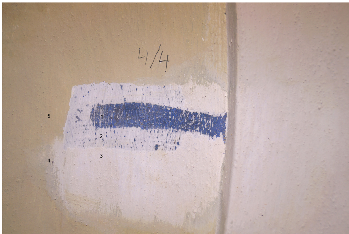
Obr 43 Sonda č. 4/4 - výmalba zrcadla 1. barokní malba (modrá) 2. bílá tenká vápenná; 3. bílá silnější, 4. zelená vodorozpustná, 5. okrová vodorozpustná.
