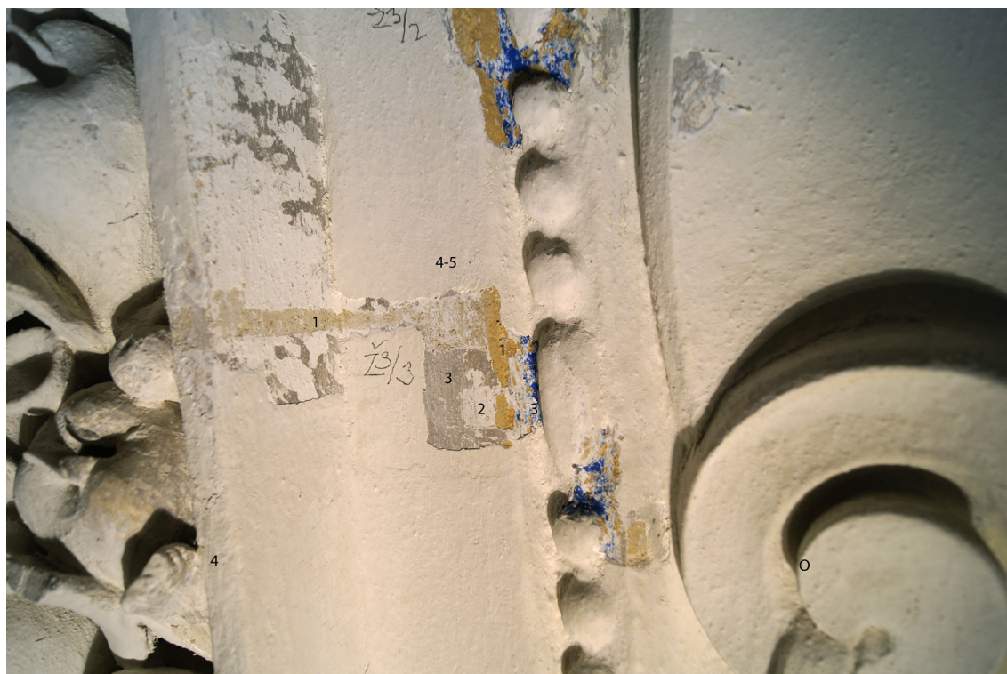
Obr 29 Sonda č. Ž3/3 - O1 - okrovorůžový tmavší štuk konstrukčních prvků a perlovce, zabíhá pod světlejší štuk výplní náběhů 1. okrová podklad pod zlacení (přebíhá přes cca 0,5 cm přes hrany), ostatní plochy šedookrový hladký povrch 2. bílá - podklad (přes všechny vrstvy) 3. modrá v pozadí perlovce, dále na žebro šedá, 4-5 bílé
