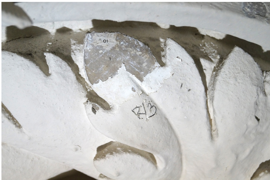
Obr 55 Sonda č. R/3 na středové rozetě - O1 světlý bílý štuk 1. šedookrový hladký povrch štuk s bílými nátěry.
