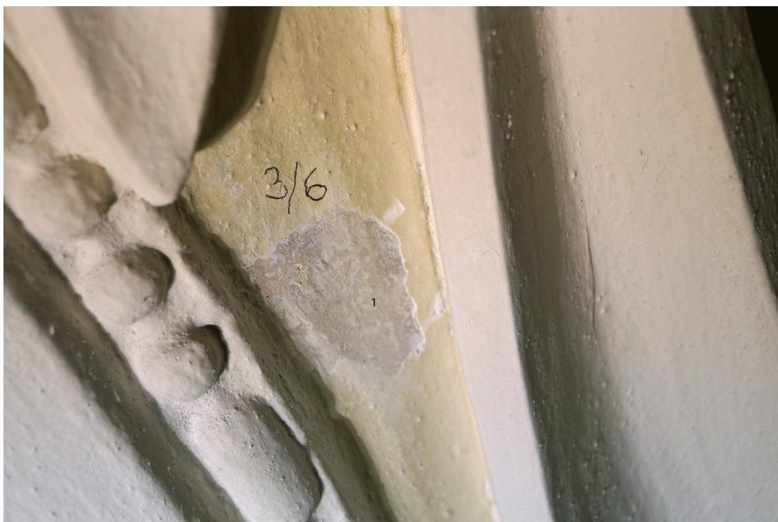
Obr 38 Sonda č. 3/6 v ploše mezi rámem a perlovcem nad náběhem klenby - 1. šedo- okrový hladký povrch štku se dvěma bílými nátěry a posledním okrovým
