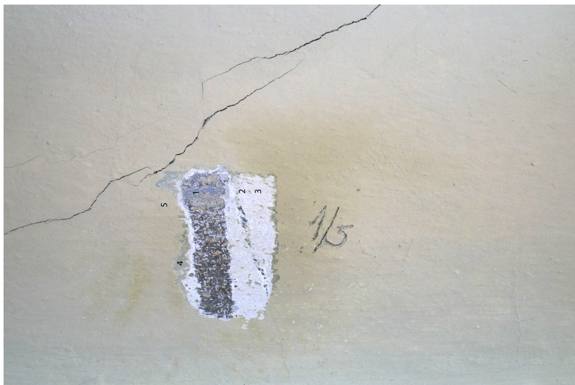
Obr 18 Sonda č. 1/5 - výmalba zrcadla. 1. barokní malba (šedá, modrá) 2. bílá; 3. bílá, 4. zelená, 5. okrová. Nad sondou probíhá statická trhlinka.
