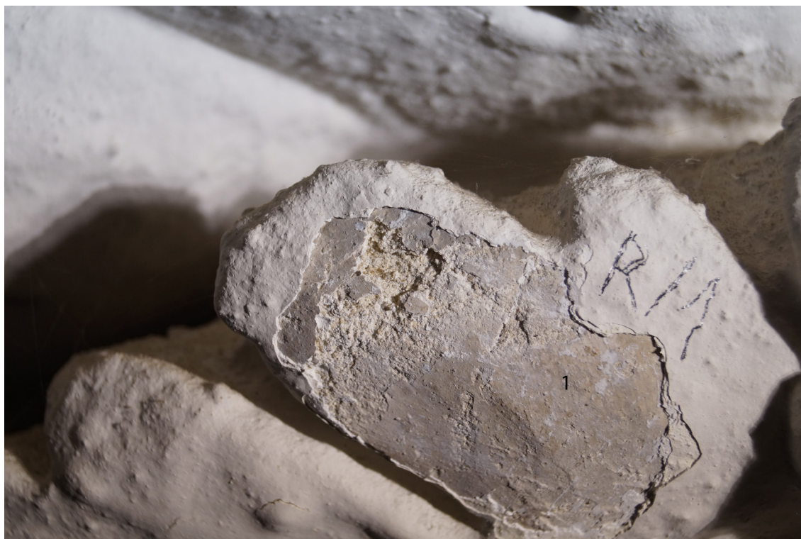
Obr 53 Sonda č. R/1 na středové rozetě - č. 1. šedookrový hladký povrch štku se bílými nátěry. Špice lístku - namodelovaná oprava vrcholu lístku se šedým nátěrem.
