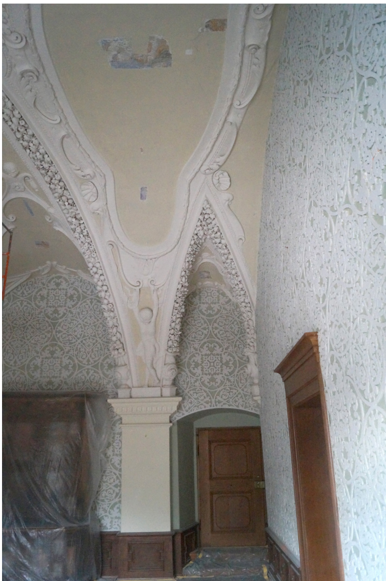
Obr 3 Celkový pohled na náběh klenby a malé pole nad vstupem naproti oknu.
