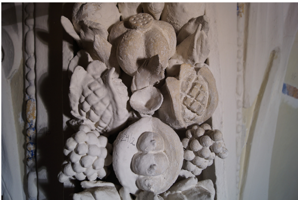
Obr 48 Sonda Ž4/2 - zkouška odkryvu - levá část zalitá vápnou a stříkaným silným hlin- kovým nátěrem je neodkrytá; pravá část očištěná po navlhčení vodou s lihem (časový odhad: 3 kusy ovoce: ananas, granátové jablko a hroznový trs = 3 hodiny)
