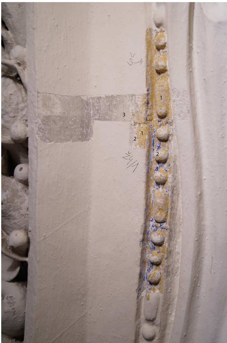
Obr 46 Sonda Ž4/1 - 1. okrová podklad pod zlacení, ostatní plochy šedookrový hladký povrch 2. bílá - podklad (přes všechny vrstvy) 3. modrá v pozadí perlovce, zlaté akcenty na vrcholech perlovce a spojovacích nitkách, šedá ostatní plochy.
