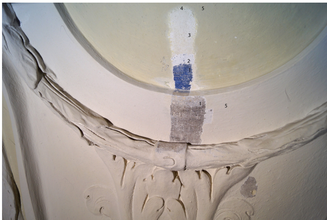
Obr 21 Sonda č. 1/8 - výmalba zrcadla a rám. 1. barokní malba (modrá, částečně se přelévá do poloviny vnitřního lemu rámu) rám šedá 2. bílá v ploše; 3. bílá v ploše, šedá na rámu 4. zelená, 5. okrová hlinka.
