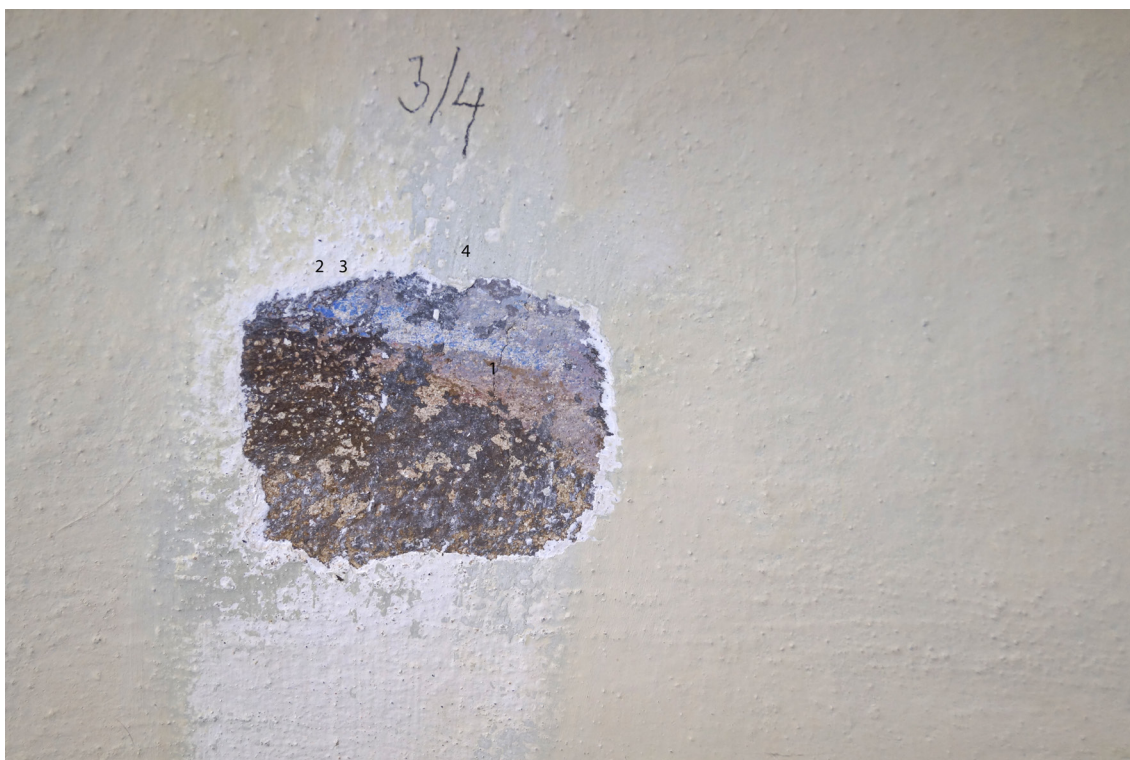
Obr 36 Sonda č. 3/4 - výmalba zrcadla: 1. barokní malba (modrá, hnědá s přemalbou ?) 2,3. bílá, 4. zelená fragmenty, 5. okrová hlínka.
