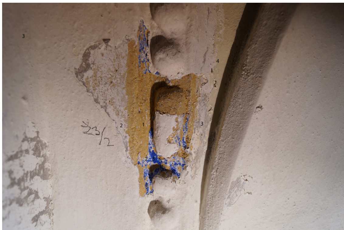
Obr 28 Sonda č. Ž3/2 - 1. okrová podklad pod zlacení (fragmenty zlata vizuálně na této vrstvě nenalezeny), ostatní plochy šedookrový hladký povrch 2. bílá - podklad (přes všechny vrstvy) 3. modrá v pozadí perlovce (i na bocích), zlaté akcenty na vrcholech perlovce a spojovacích nitkách, šedá ostatní plochy.
