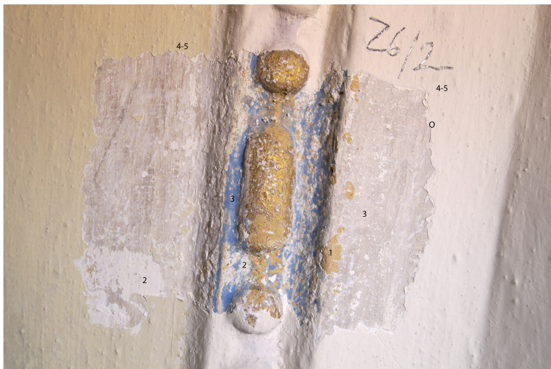
Obr 66 Sonda Ž6/2 - 1. okrová - podklad pod zlacení zřetelně pod vrstvou šedé na bílém podkladovém nátěru 2. bílá - podklad (přes všechny vrstvy) 3. modrá v pozadí perlovce, zlaté akcenty na vrcholech perlovce a spojovacích nitkách, šedá ostatní plochy. 4,5. bílá a okrová hlínka. Modrá má jiný barevný odstín než v jiných částech.
