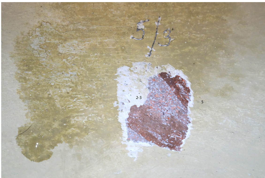
Obr 62 Sonda č. 5/3 - výmalba zrcadla a rám. 1. barokní malba (červená a lososová), 3. bílé, 4. chybí, 5. okrová hlínka.
