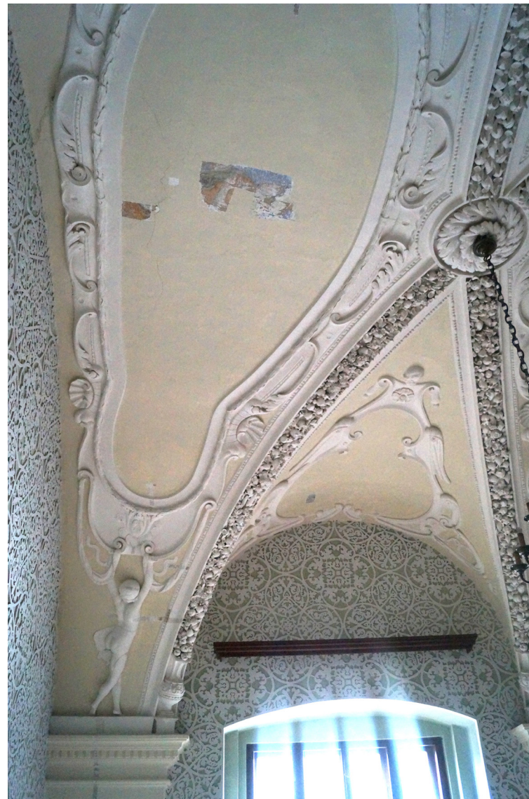
Obr 4 Celkový pohled na náběh klenby nalevo od okna.
