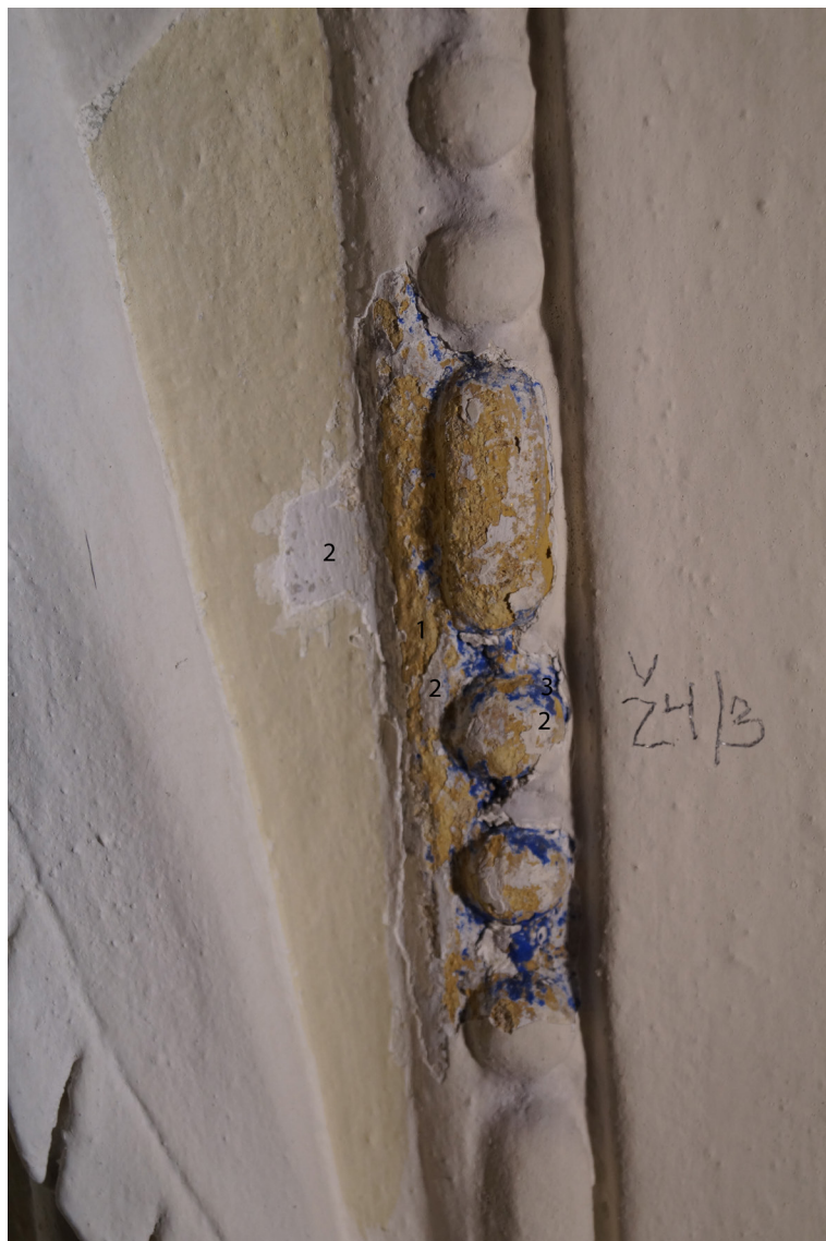
Obr 50 Sonda Ž4/3 - 1. okrová podklad pod zlacení 2. bílá - podklad (přes všechny vrstvy) 3. modrá v pozadí perlovce, zlaté akcenty na vrcholech perlovce.
