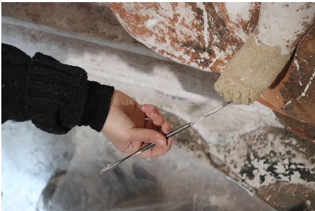
Obr. 18 Nanášení vnitřního hrubého tmelu špachtlí
