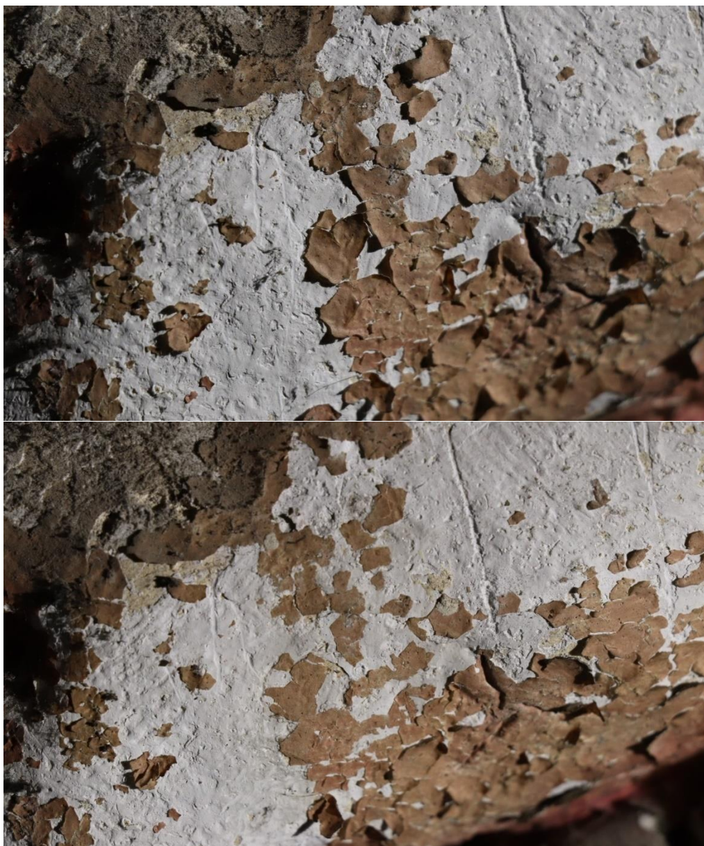
Obr. 5 Zkoušky fixace barevné vrstvy. Obrázek nahoře stav před, obrázek dole stav po fixaci.
